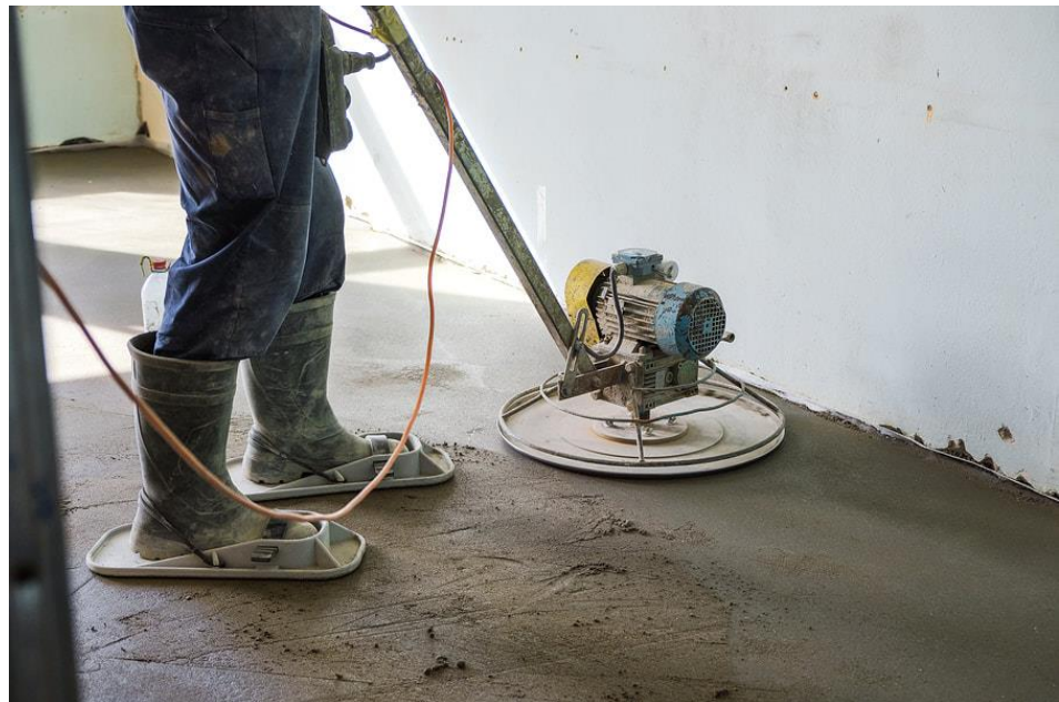
Afbeelding 28: plaatsen van gepolierd beton (Arna, 2020)
