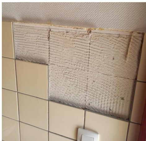
Afbeelding 43: geslaagde ontmanteling in het toilet van een woning in de Canteclaerwijk
