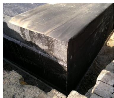
Afbeelding 6: Kimlaag wordt afgedekt met waterkerende EPDM folie (BLAF Architecten, 2015)
