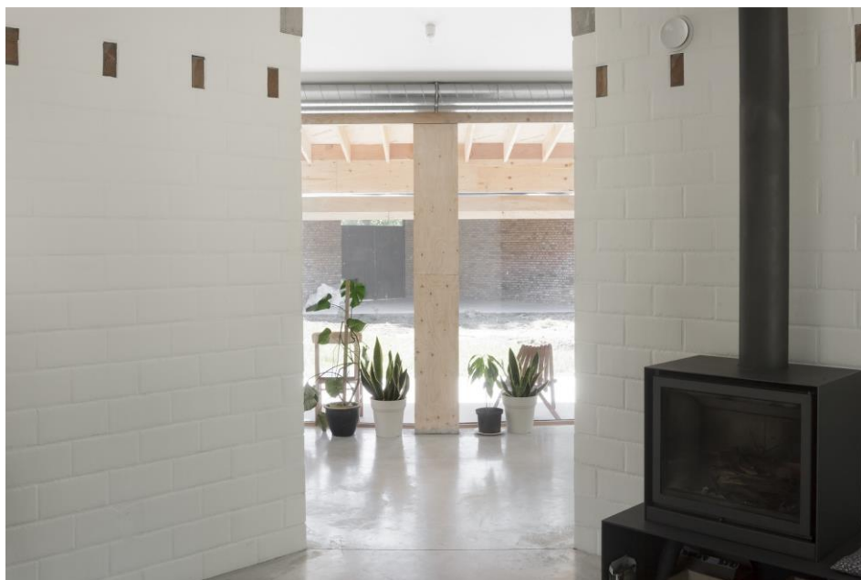
Afbeelding 19: Interieurbeeld IbSN woning: de verf als afwerkingslaag staat toe de voegen van het metselwerk te onderscheiden (BLAF Architecten, 2015)
