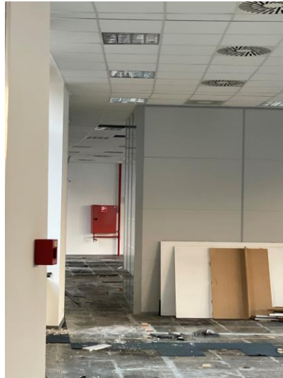
Afbeelding 58: Interieur sloopwerf De Meuter, brandhaspel in de achtergrond te zien
