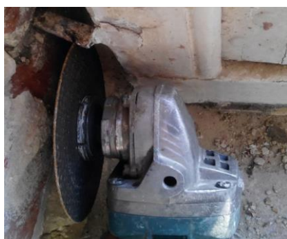
Afbeelding 49: Doorslijpen van de staartankers met een slijpschijf voor het ontmantelen van de raamkaders (ReUse Brussels, 2016)
