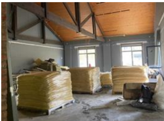
Afbeelding 22: Ontmantelde glaswol uit binnenwanden (HuisMus, 2024)
