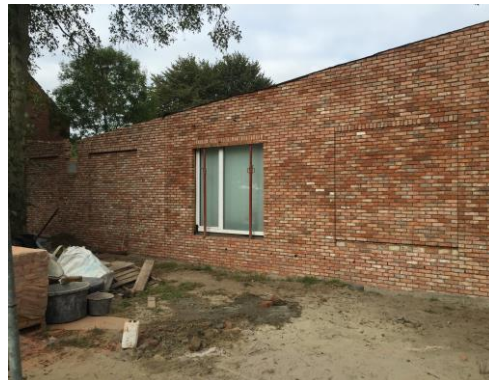
Afbeelding 53: Oostgevel IbSN woning met dichtgemetste gevelopeningen (BLAF Architecten, 2015)
