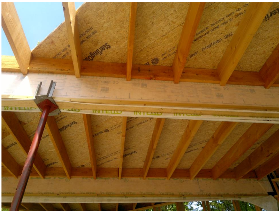
Afbeelding 15: OSB beplating wordt op de dakroostering geplaatst (BLAF Architecten, 2015)
