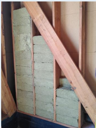
Afbeelding 24: Hergebruikte minerale wol tussen houten kepers (Ecobouwers, 2024b)
