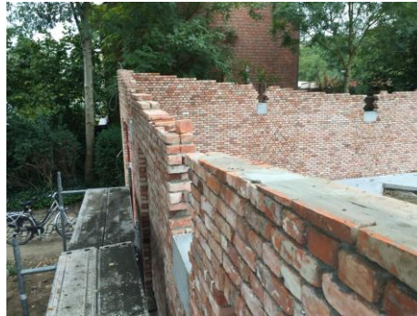
Afbeelding 36: Foto steens verband IbSN (BLAF Architecten, 2015)
