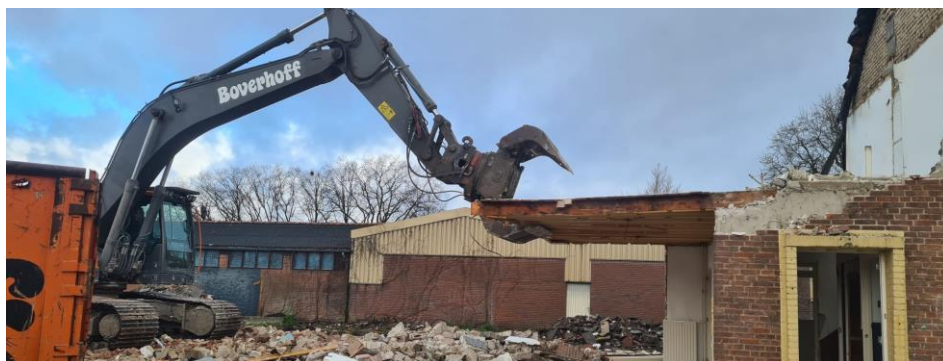
Afbeelding 8: Ontmanteling van een vloerplaat met houten balken als draagstructuur met behulp van een grijpkraan (Houthandel Ruiterkamp, 2024)
