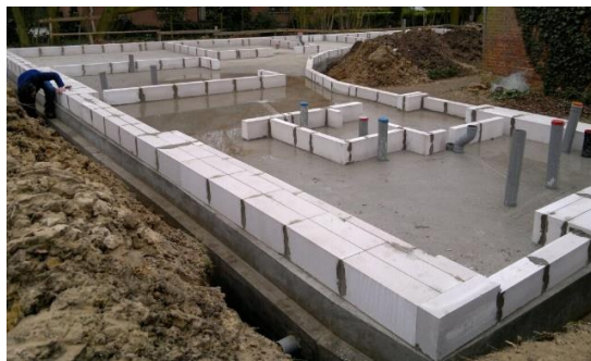
Afbeelding 5: Werffoto van de plaatsing van de kimlaag van de IbSN woning (BLAF Architecten, 2015)
