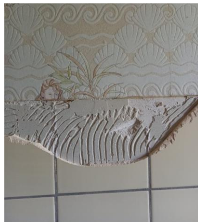
Afbeelding 44: niet-succesvolle ontmanteling in de badkamer van een woning in de Canteclaerwijk
