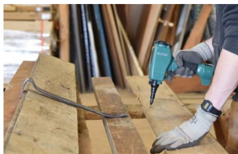
Afbeelding 9: Ontnagelen met behulp van de nail kicker (The ReStore, 2024)
