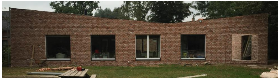
Afbeelding 52: Noordgevel IbSN woning met gevelopeningen waarin schrijnwerk werd geplaatst (BLAF Architecten, 2015)
