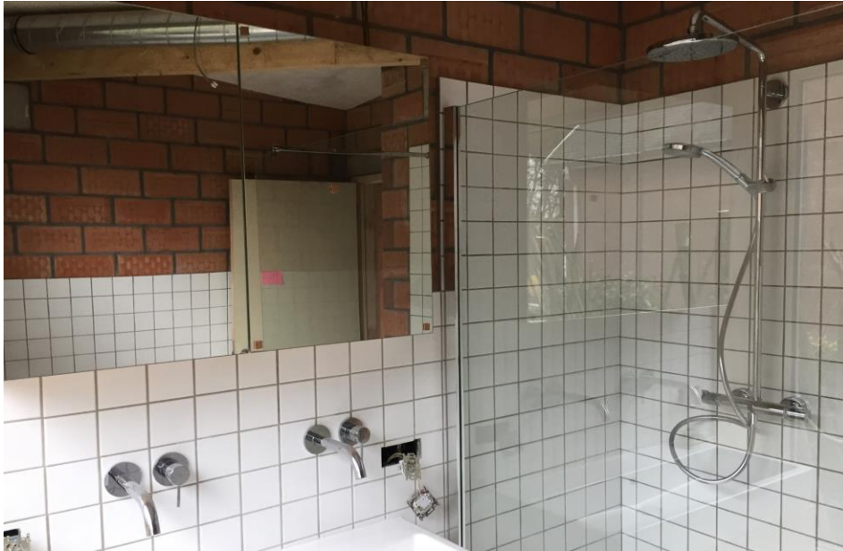
Afbeelding 46: Faiencetegels in de badkamer van de IbSN woning, geplaatst op uitgecementeerde snelbouwsteen (BLAF Architecten, 2015)
