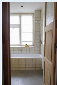
Afbeelding 45: Hergebruikte faiencetegel in badkamer
