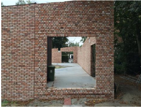
Afbeelding 37: Werffoto metselwerk IbSN (BLAF Architecten, 2015)
