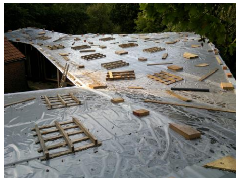
Afbeelding 25: PIR- isolatie wordt afgedekt met een zeil en ballast (BLAF Architecten, 2015)
