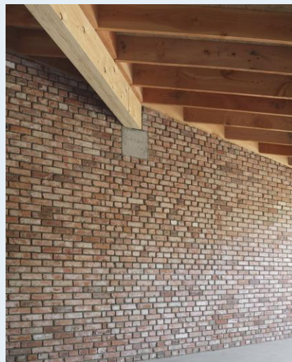
Afbeelding 35: metselwerk IbSN met gerecupereerde gevelstenen (BLAF Architecten, 2015)
