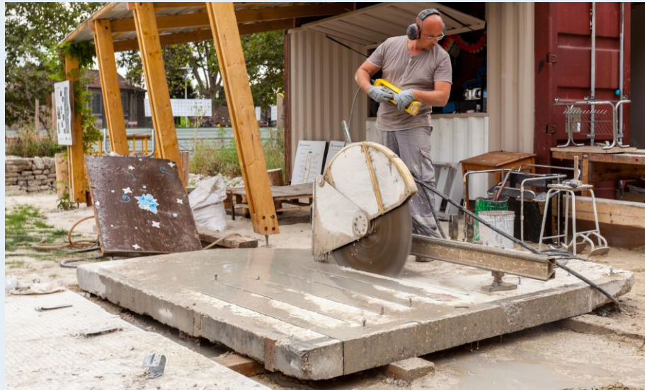
Afbeelding 29: Verzagen van betonnen wanden tot niet dragende wandstukken (Leclercq, 2018)
