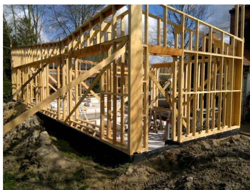
Afbeelding 12: Opbouw houtskeletwanden IbSN woning (BLAF Architecten, 2015)
