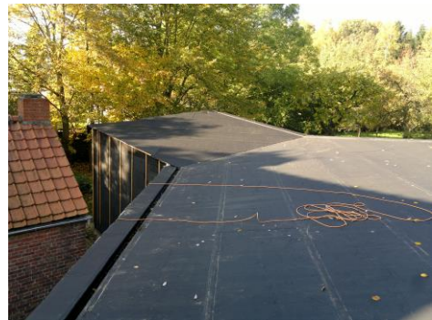
Afbeelding 26: Dak wordt afgewerkt met een EPDM dakdichting (BLAF Architecten, 2015)
