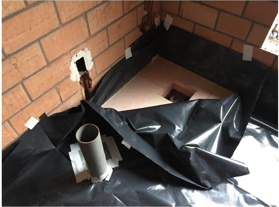
Afbeelding 27: werffoto van de IbSN woning waarop de PE-folie op de resolplaten wordt geplaatst (BLAF Architecten, 2015)
