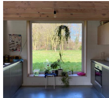
Afbeelding 54: Raam afgewerkt met multiplex kader in het interieur (BLAF Architecten, 2015)
