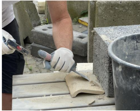
Afbeelding 42: Mortelresten worden handmatig met hamer en beitel verwijderd (De Wilde Vincent, 2023)
