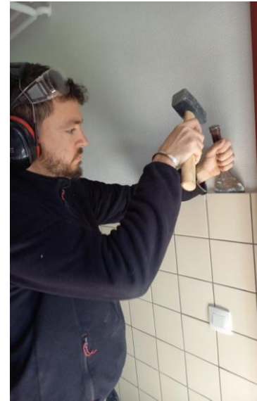
Afbeelding 40: Ontmanteling van keramische wandtegels in het toilet van een woning in de Cantecleerwijk
