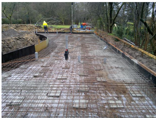
Afbeelding 2: Wapening van de betonnen fundering (BLAF Architecten, 2015)
