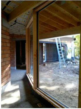
Afbeelding 55: werffoto plaatsing glas in houten kaders gordijngevel (BLAF Architecten, 2015)
