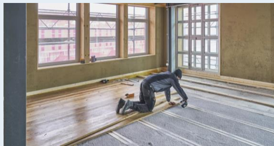
Afbeelding 20: Plaatsing cellulosevlokken vloer K118 (Opalis, 2024)
