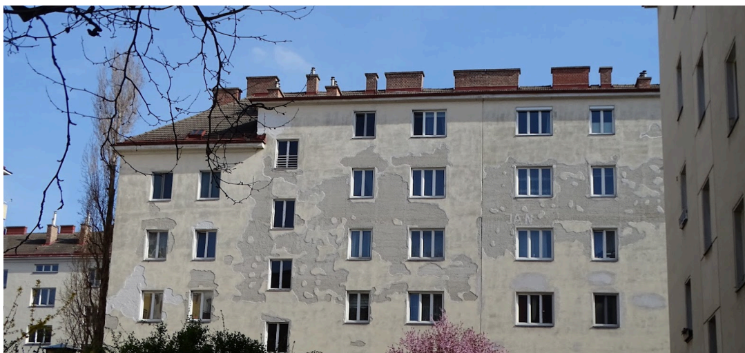
Achtergevel van het gebouw van de Leonhardgasse, rechts in het midden staat 'Jan' geschreven.
