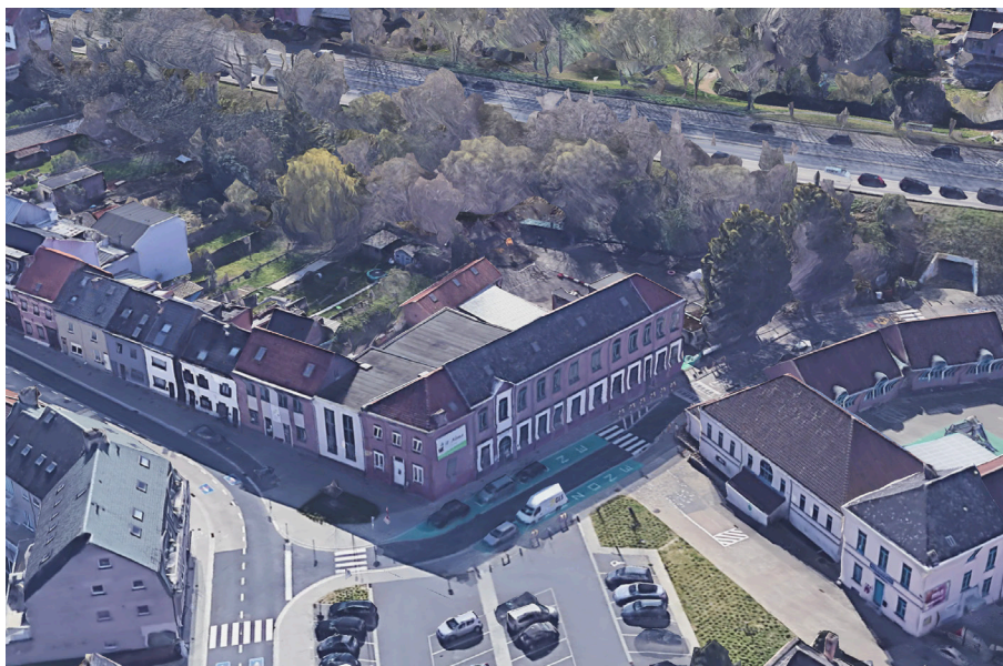
Afbeelding 5: Luchtfoto bestaande toestand voorzijde- Vrije Basisschool Sint-Alena 14
