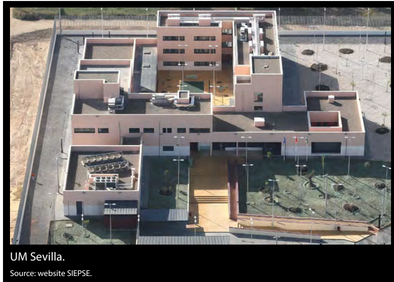
FIGURE 4.6: Image of Unidad Externa de Madre Andalucía (Sevilla).
