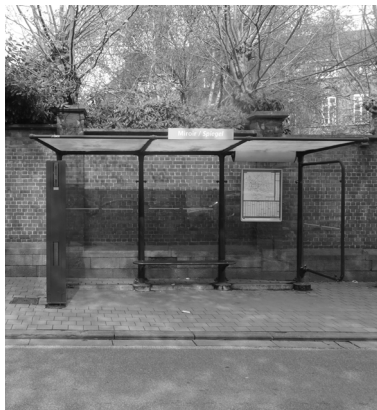
bushalte bij tuinmuur Lakenselaan
