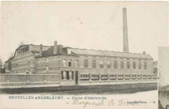
↑ Belfius postcards. (<1920). Usine d'électricité – Quai Fernand Demets. Via Bruciel. https://bruciel.brussels/#
