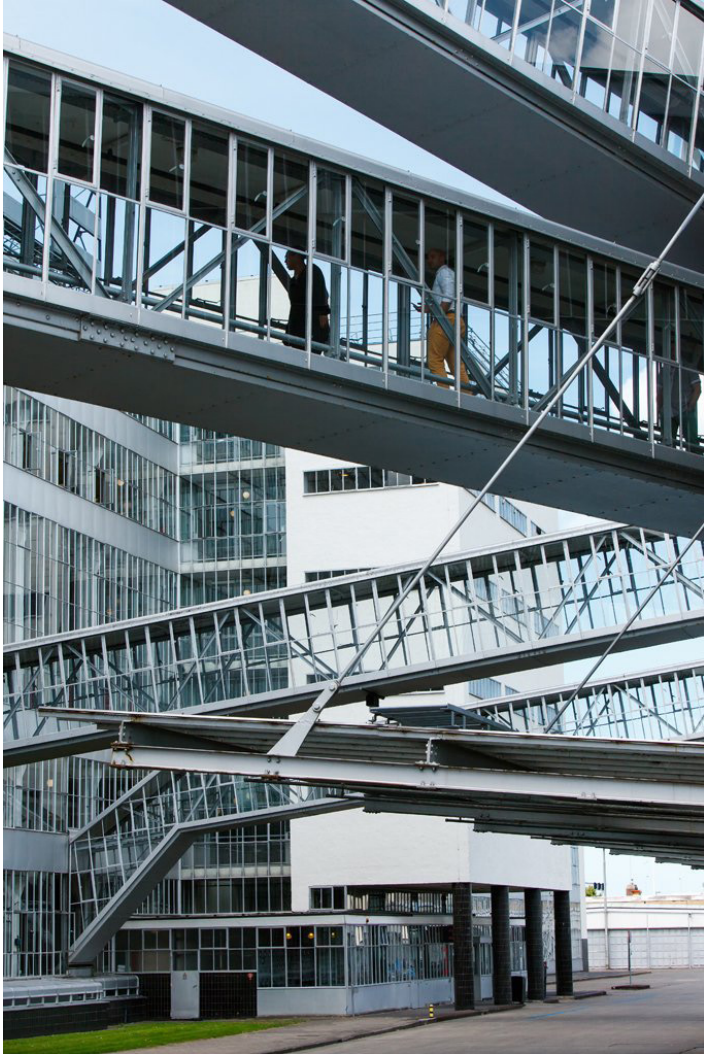
Loopbrug van de Van Nellefabriek in Rotterdam (De Jong, N, z.d.).
