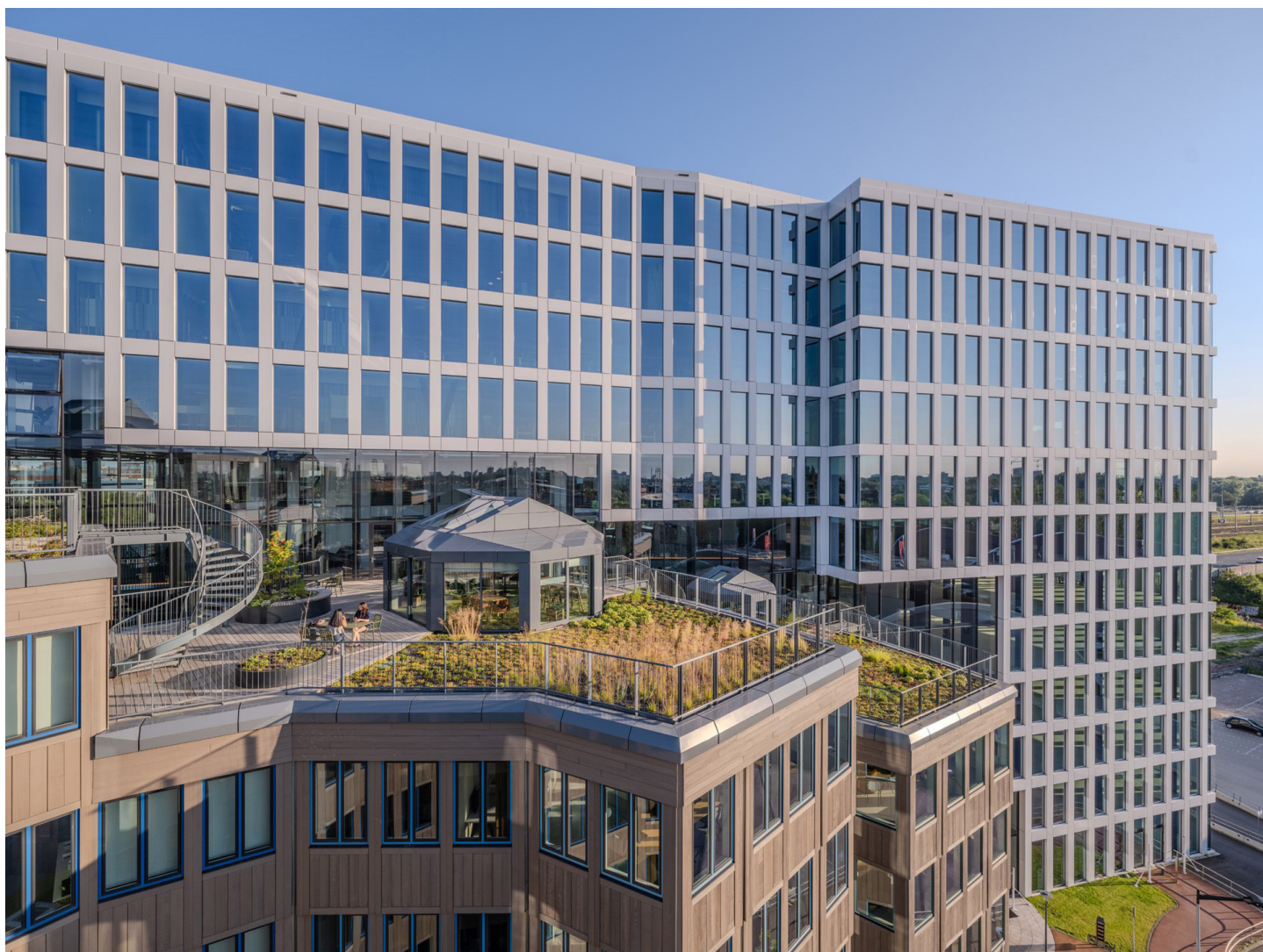
Het vergroende dak van Tripolis met een paviljoen dat fungeert als tussenruimte (Van Duivenbode, O, 2023).
