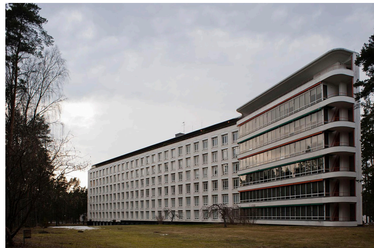
Fig. 46: Docomomo (1993), Foto van de ligbadzaal in Paimio Sanatorium, ontworpen door Alvar Aalto.
