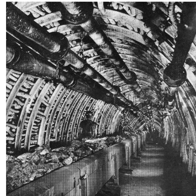
Fig.38: Fotograaf onbekend (z.d.), Kolenmijn van Waterschei met houten ondersteuning. Foto getoond door Michiel Dusart, in zijn presentatie op de faculteit op 28 november 2025.
