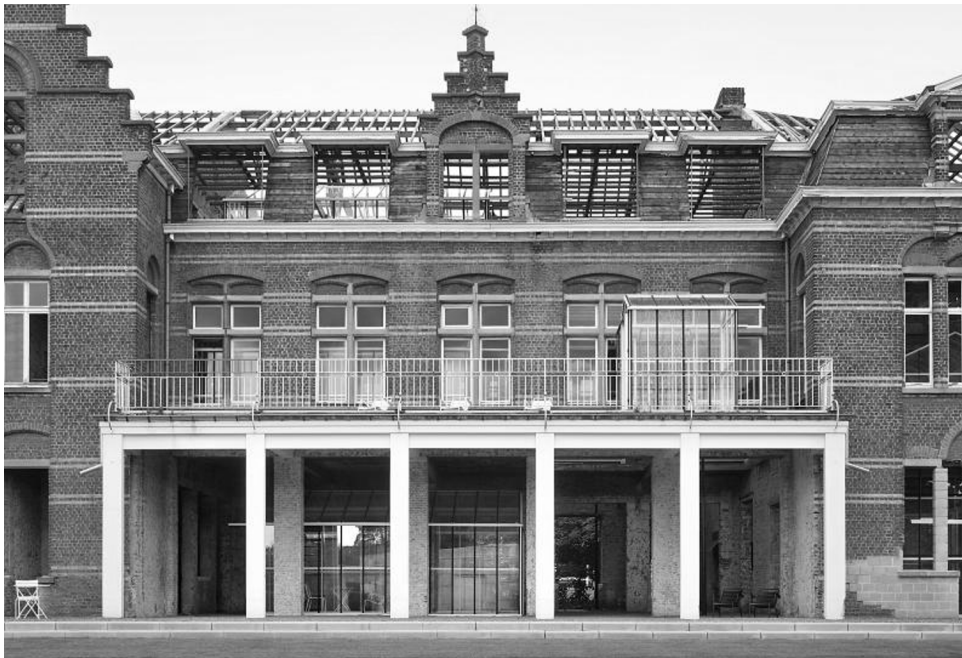
Fig. 24: De Vylder Vinck Taillieu (2017), PC Caritas, Melle.
