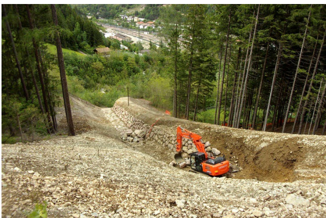
Figuur 49 - Constructie aan het opvangbasin F10 in 2019, ©BBT SE
