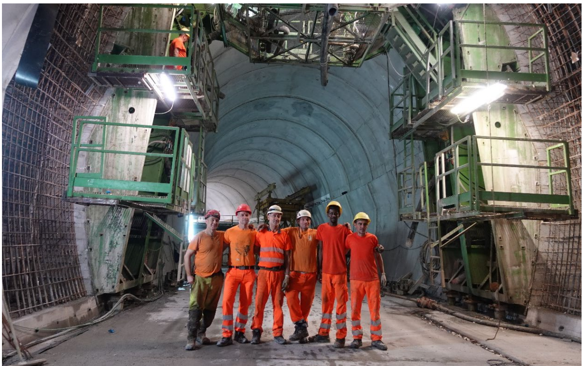
Figuur 24 - Werknemers bij de laatste lopende meter bekleding in de werf Mules in april 2025, Eigen foto
