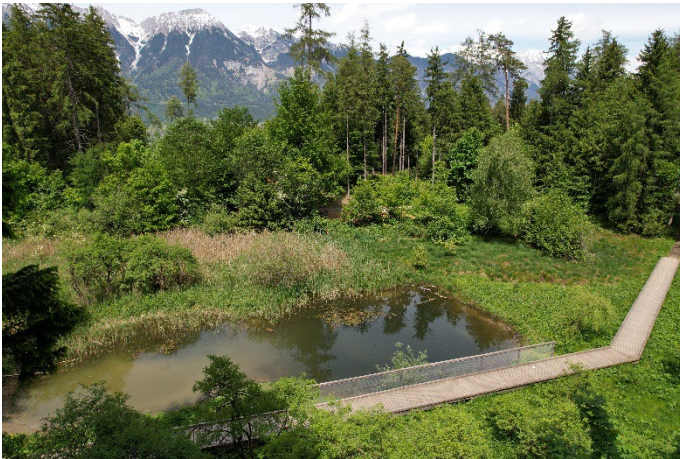
Figuur 33 - Drone beeld van project Inn1 in 2021, ©BBT SE
