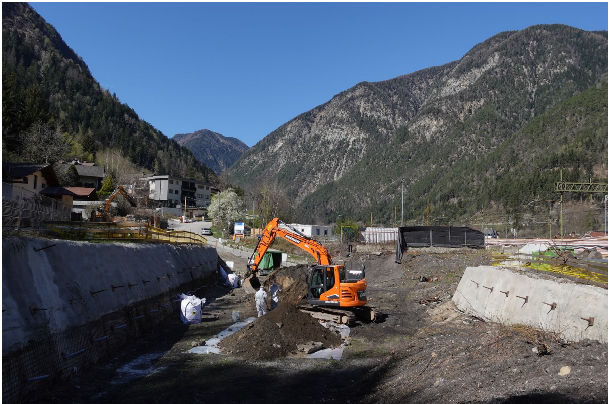
Figuur 66 - Bouwwerf H81 Riol in Fortezza, Eigen foto in april 2025
