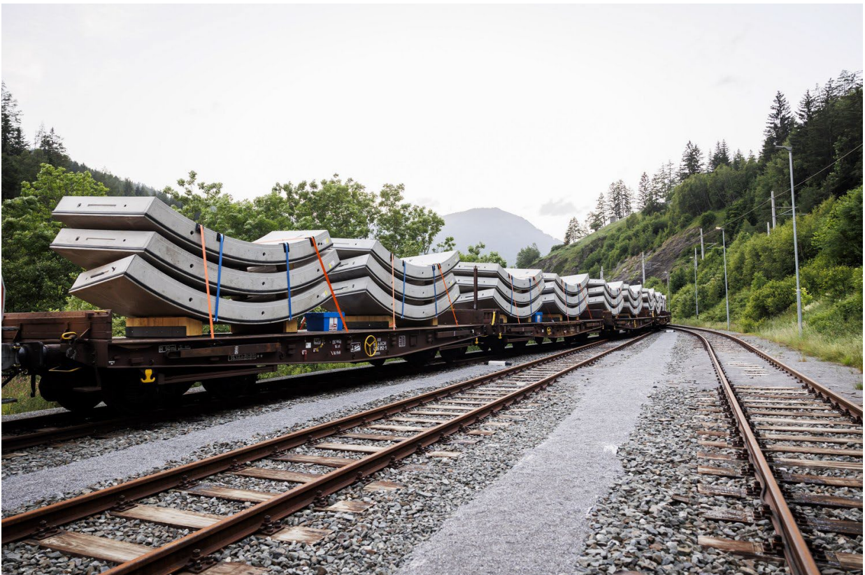
Figuur 20 - Tubbingringen worden via het spoor getransporteerd, ©BBT SE
