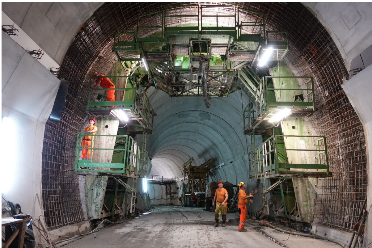
Figuur 17 - De laatste lopende meter van bekleding wordt toegevoegd aan de toegangstunnel, Eigen foto, april 2025
