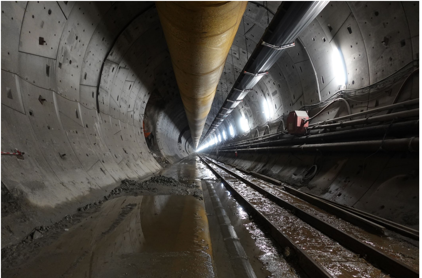
Figuur 28 - Eigen foto's in de tunnels van bouwwerf 'Mules', april 2025
