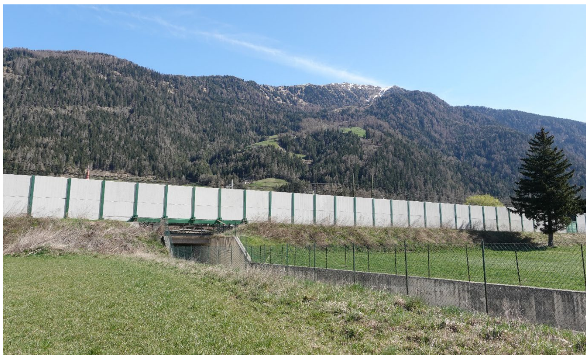
Figuur 52 - Afgewerkt geluidsscherm CdT8 in april 2025, Eigen foto
