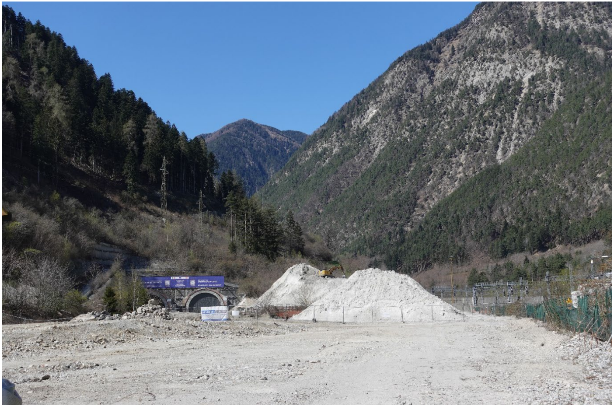
Figuur 22 - Zicht op de werf H81 Riol in Fortezza, de zuidelijke 'poort' van de BBT, Eigen foto, april 2025
