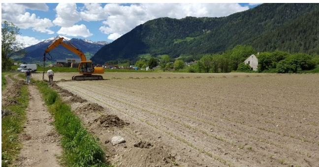
Figuur 48 - Renovatie en uitbreiding waterleiding CdT19 in 2017, ©BBT SE
