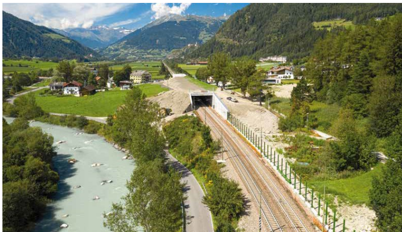
Figuur 51 - CdT7 en CdT8 in constructie, 2020, ©BBT SE
