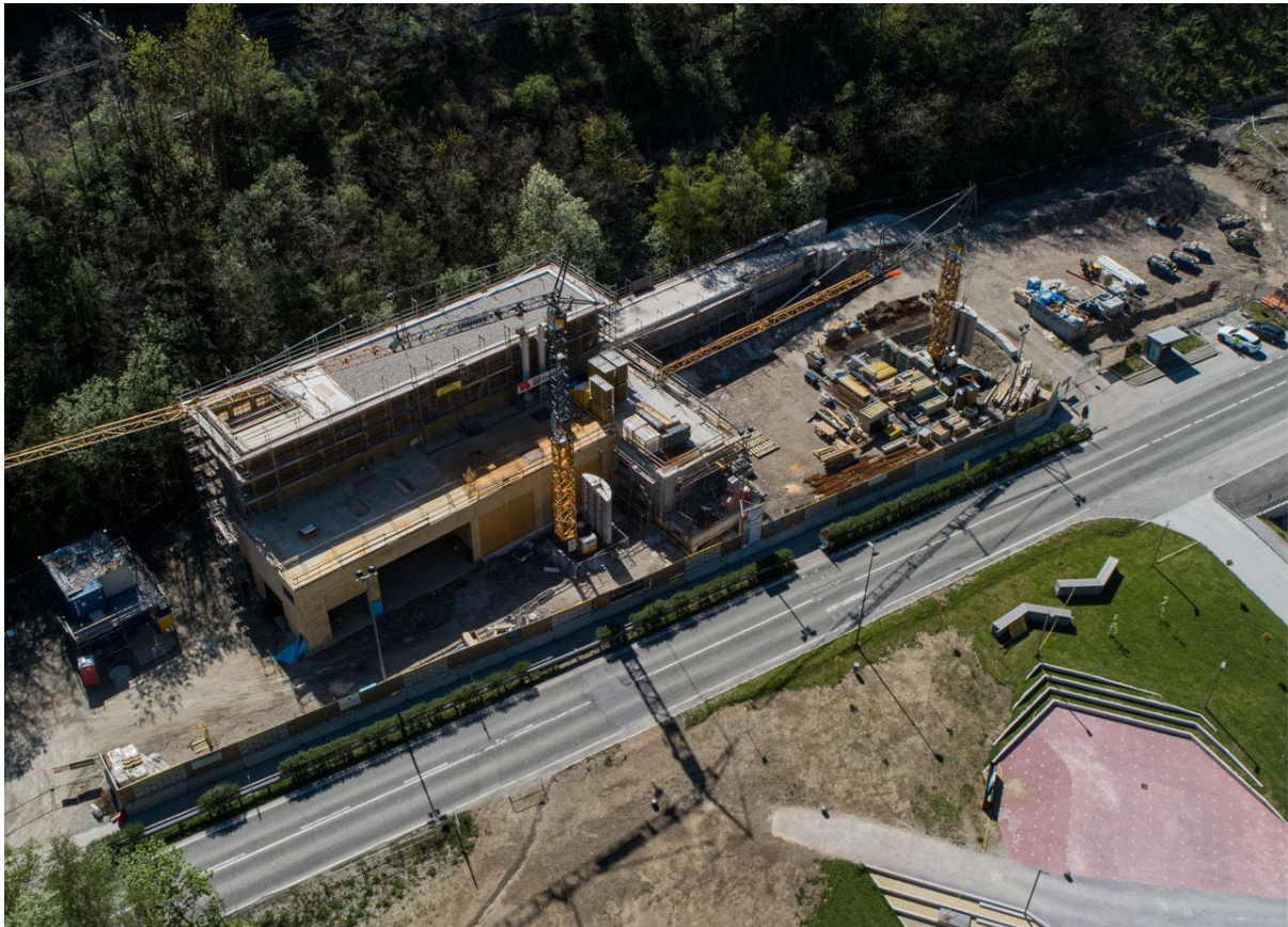
Figuur 54 - Constructiewerken aan project F9 in 2020, ©BBT SE
