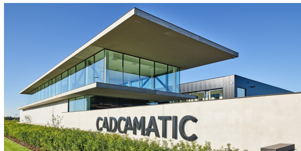
Figuur 1.2: Gebouw van Cadcamatic (Architect Naert, 2024)
