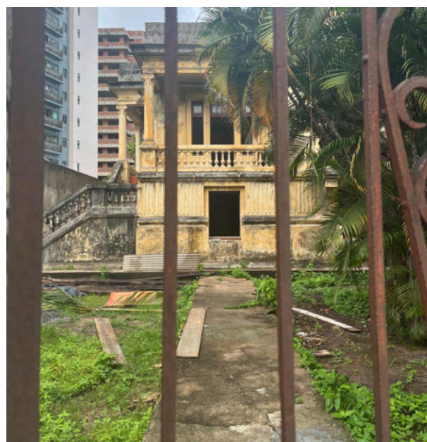
66. Soledad Barrett occupatie in huidige staat, en zal binnenkort worden getransformeerd tot ouderentehuis, eigen werk (2025).
