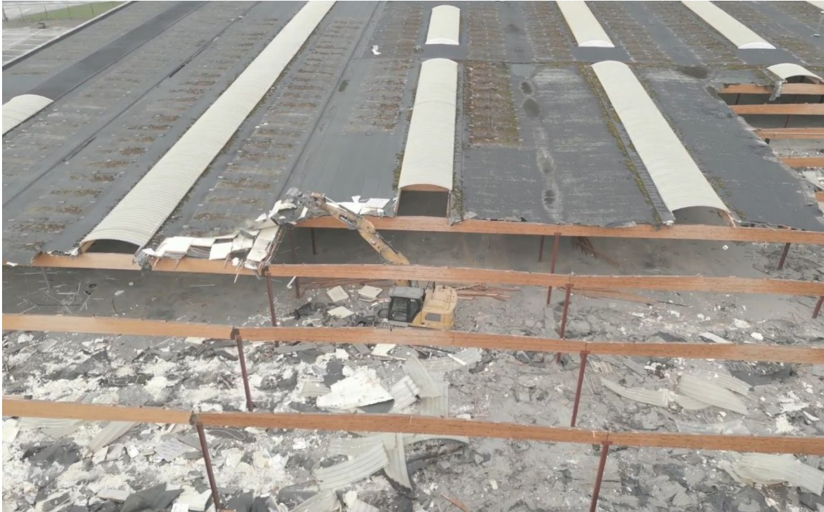
Figuur 80: Vrijleggen van balken voor hergebruik bij de afbraak van een loods in Kortrijk (casus 2.3) ( Provincie Oost-Vlaanderen, 2024 )
