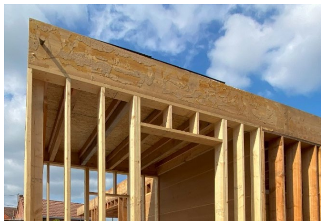
Figuur 36: Randbalk met nog zichtbare lijmresten tijdens de werffase (D. Smet, 2023)
