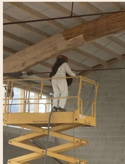
Figuur 96: Luchtgommen van spanten (M. Vandaele, 2024)
