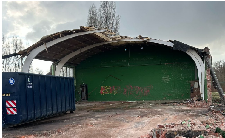
Figuur 63: Gebroken spanten tijdens de afbraak van de sporthallen (R. Osselaer, 2025)
