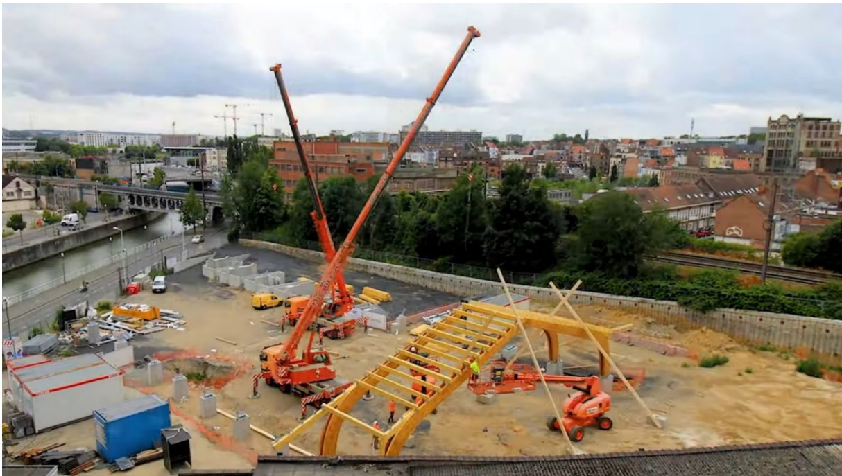
Figuur 103: Installatie van hergebruikte spanten voor het Recypark in Anderlecht (casus 2.1) ( Bruxelles Propreté – Net Brussel )
