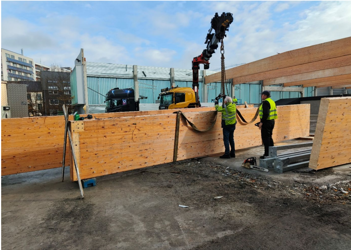
Figuur 86: Een geschoorde balk, vlak na ontmanteling (casus 2.4)
