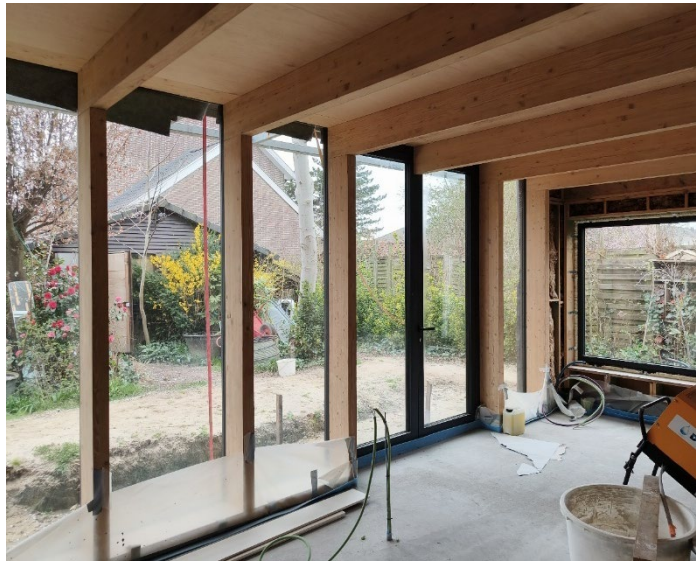
Figuur 41: De opbouw van de gordijngewel en verdiepingvloer in werffase
