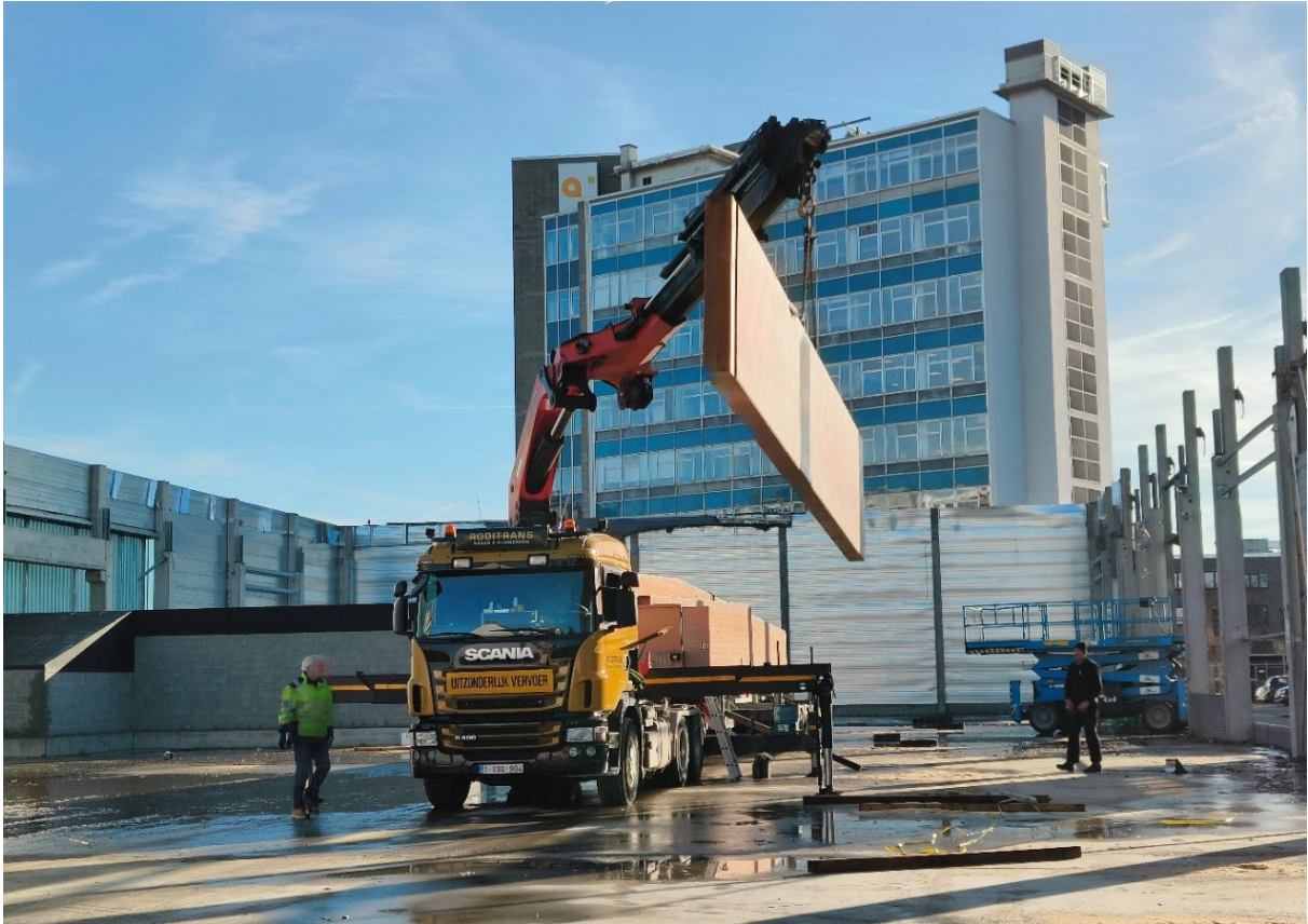
Figuur 87: Hijsen van een balk op transport met een camionkraan (casus 2.4)
