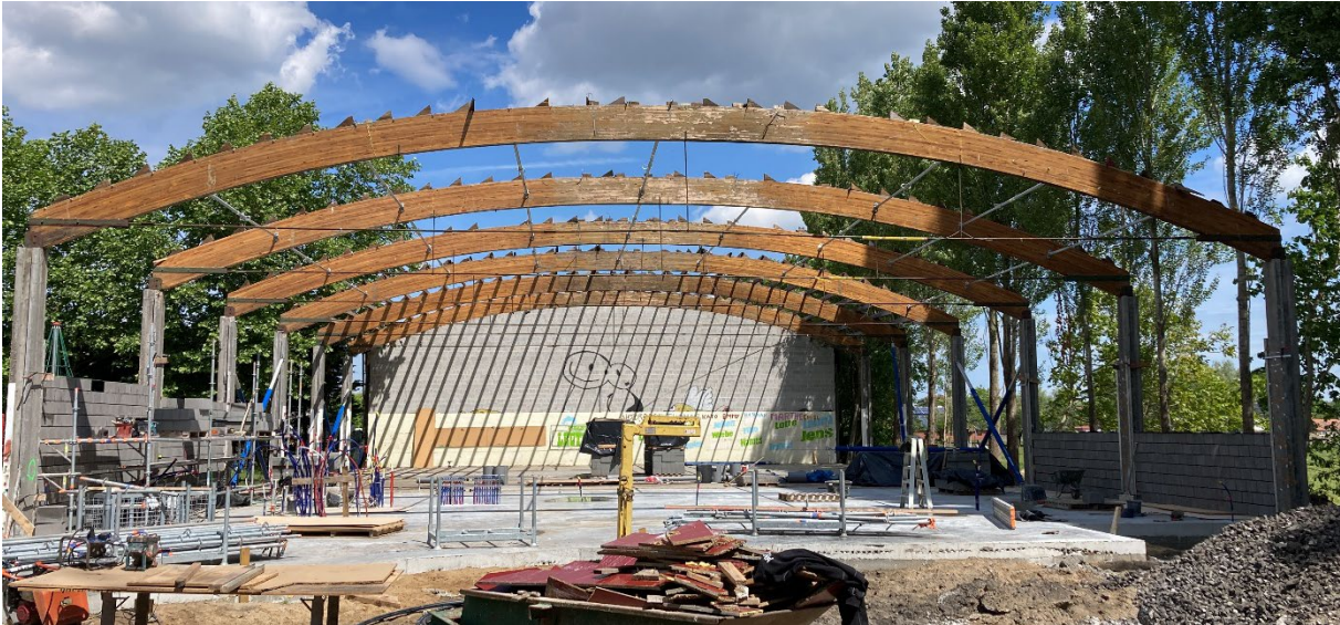
Figuur 58: De blootgelegde basisstructuur tijdens het metsen van de nieuwe wanden (D. Vandendriessche, 2022)
