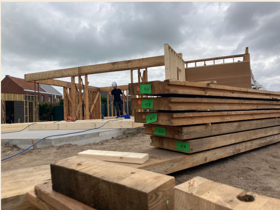
Figuur 104: Werffoto tijdens de opbouw met glulambalken (N. Meerschaut, 2025)
