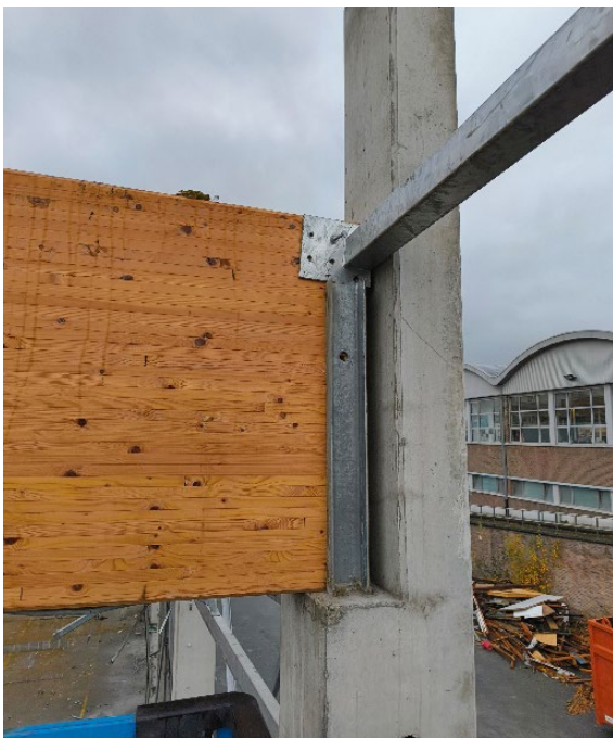
Figuur 82: Typische paal-balk verbinding, na het verwijderen van bouten (casus 2.4)
