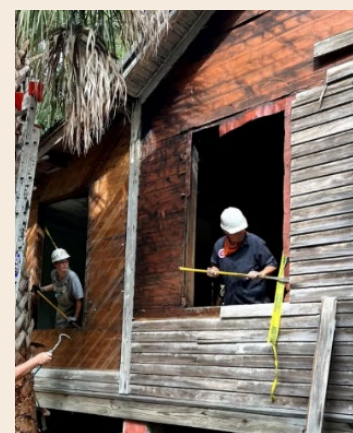
Figuur 15: Ontmanteling van gevelplanken (Re:Purpose Savannah, 2022)
