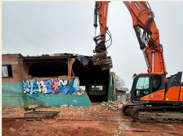
Figuur 118: het slopen van glulam aan de hand van een rupgraafmachine (casus 3.1) (R. Osselaer, 2025)
