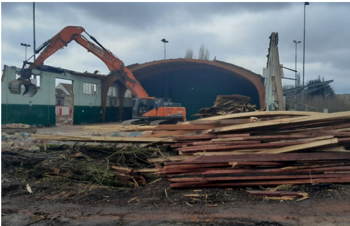
Figuur 64: Afbraak van de sporthallen met grijpkraan (R. Osselaer, 2025)
