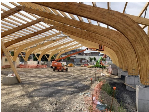
Figuur 29: De hergebruikte elementen na installatie, in werffase (Rotor, 2023)
