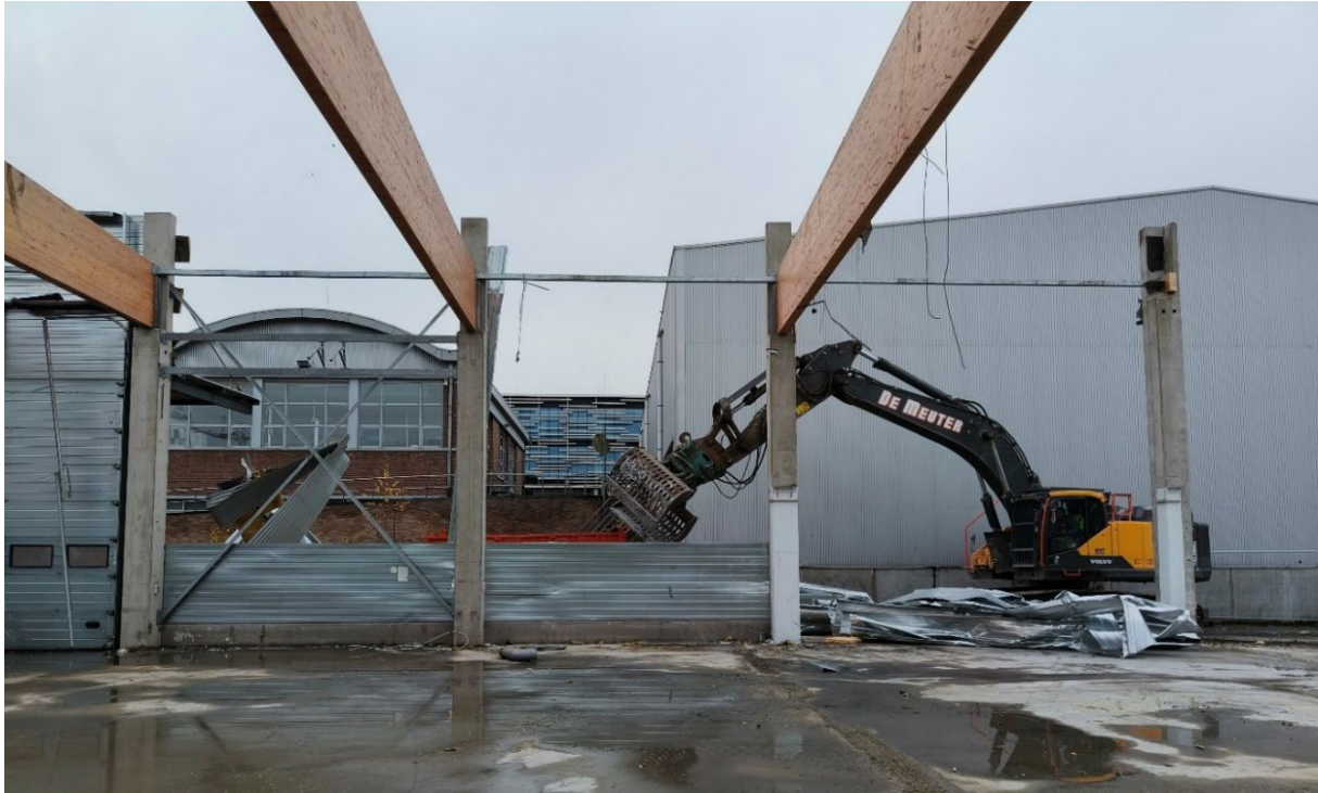
Figuur 81: Verwijderen van wandpanelen bij afbraak (casus 2.4)
