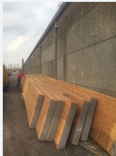
Figuur 76: Afgeleverde balken bij de opslagplaats (G. Polfliet, 2024)
