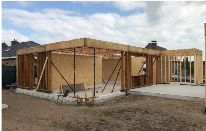
Figuur 37: Opbouw van de woning tijdens werffase met gebruik van gerecupereerde glulam als randbalken (N. Meersschaut, 2023)
