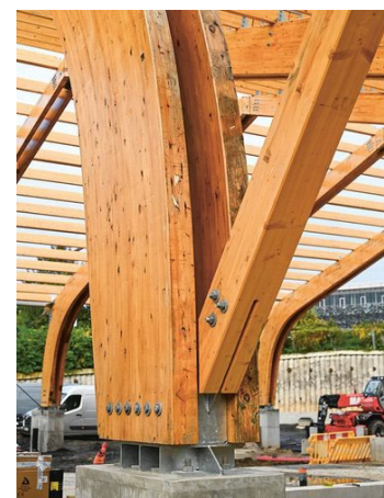
Figuur 32: Ontdubbeling van de spanten en montering op een betonsokkel (Cousins, 2025)
