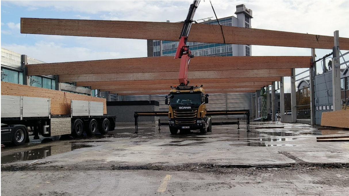
Figuur 85: Uithijzen van een balk met een camionkraan (casus 2.4)
