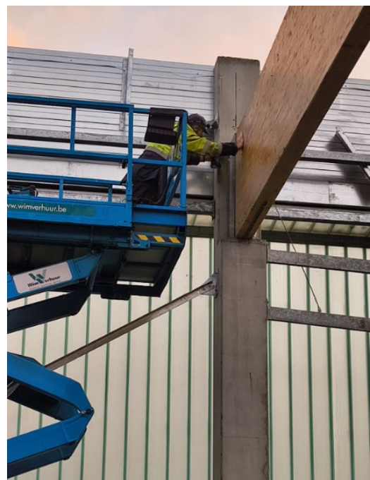
Figuur 83: Losmaken van verbindingen met een elektrische slagmoersleutel (casus 2.4)
