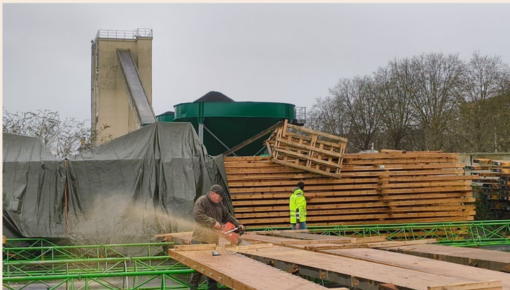
Figuur 94: Nauwkeurig verzaagen in de breedte met een kettingzaag
