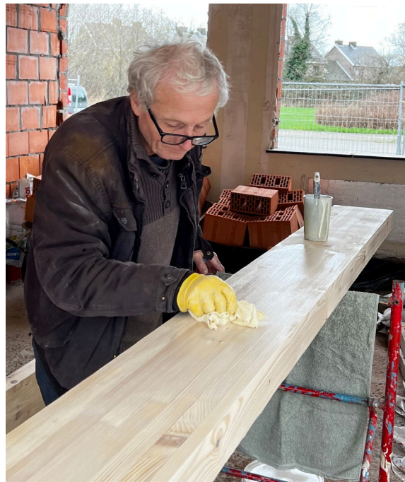
Figuur 95: Manueel aanbrengen van lijnolie op een balk (casus 2.2) (W. Thys, 2024)
