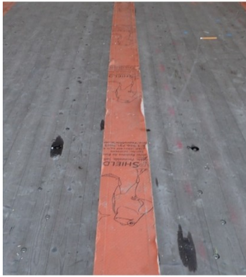
Dampopen tape aan paneelranden
