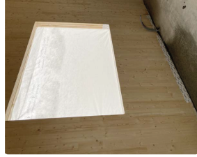
Tijdelijk dichtgegewerkte openingen © Gustafsson, A.
