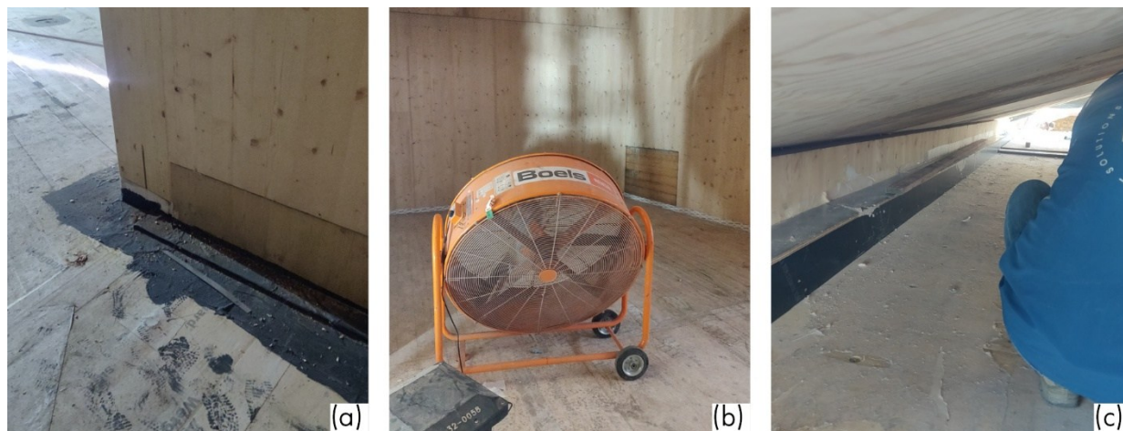
Figuur 148 - Aanbrengen van bitumineuze waterdichtingen bij een bouwnaad om verdere bevochtiging tegen te gaan (a). Mechanische droging via een geforceerde luchtstroom (b). Tijdelijke overkapping in de buitenomgeving om een droge luchtstroom hierdoor te sturen zonder verdere bevochtiging. De membranen zijn hier verwijderd voor optimale droging.
