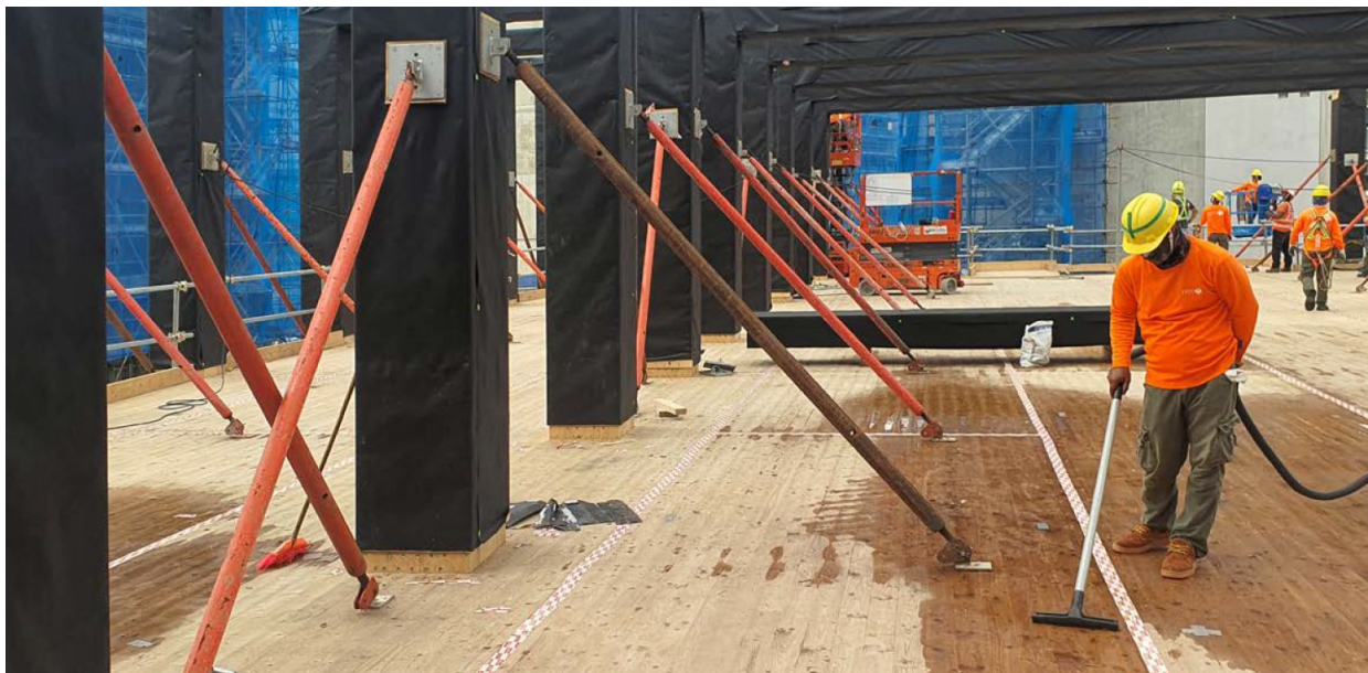
Figuur 103 - Gebruik van een bouwstofzuiger om overtollig stagnerend water op te zuigen (Pröbel & Alsmarker, 2022)
