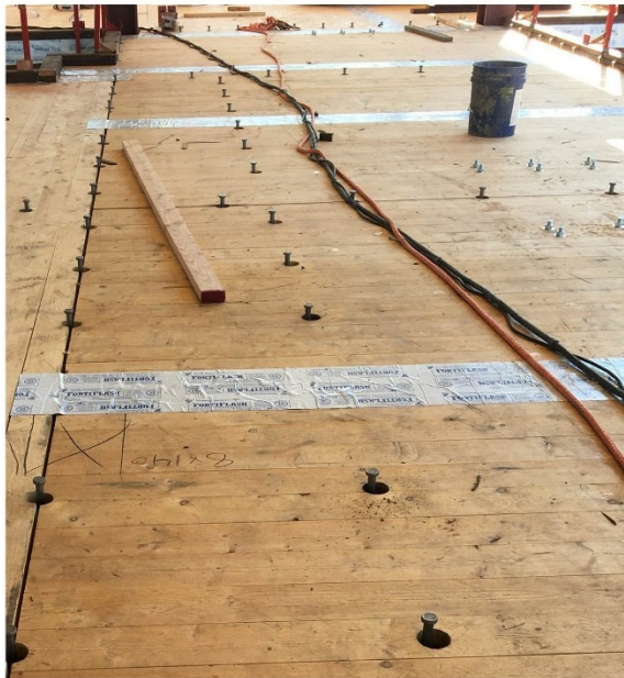
Figuur 58 - Werkbeeld en opbouw van een TCC-systeem
