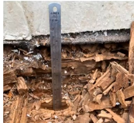
Figuur 73 - Ernstige bruinrotaantasting van een CLT-paneel onder een groen dak, twee jaar na oplevering (Clifford 2025)
