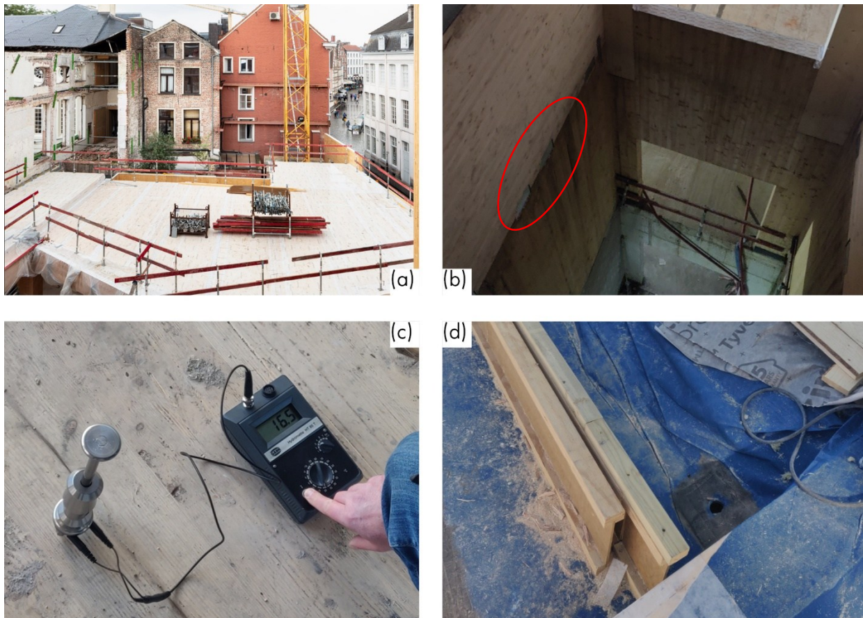
Figuur 147 - Stilstand van de werf na montage van het gelijkvloers (a) (Atama, 2023). Bijgevolg kenden de reeds gemonteerde panelen hoge vochtgehalten en verkleuring waarna mechanische droging vereist was (b). Vochtmetingen worden volgens een correct protocol uitgevoerd nabij paneelranden op verschillende dieptes (c). Verhinderde drainage door onnauwkeurigheden van arbeiders (d).
