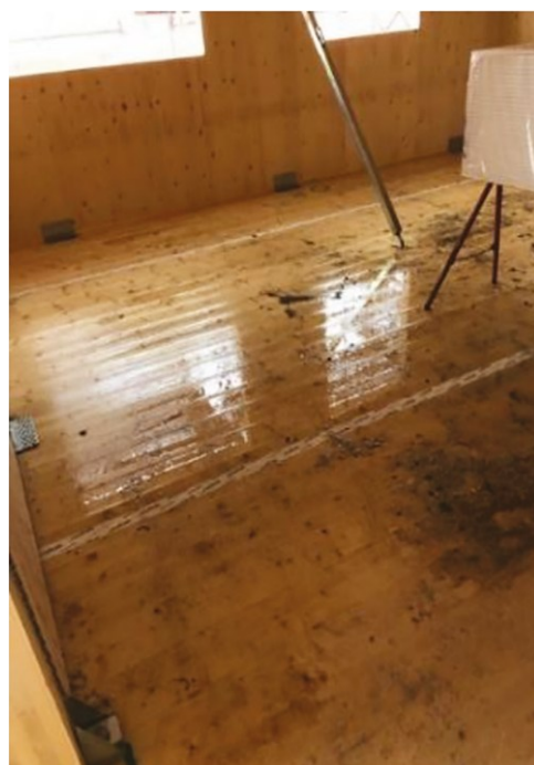
Figuur 39 - Verbinding van twee vloerpanelen met afgetapete naden (aangebracht na bevochtiging). Plasmavorming op de panelen, afkomstig van doorvoer op bovenliggende verdiepingen (Olsson, 2020)
