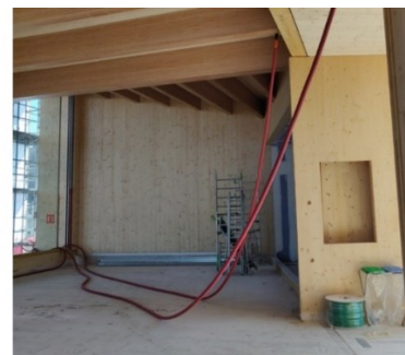
Figuur 102 - Doorvoering voor een drainagebuis, waarin een zelfklevend membraan verkleefd wordt op de bestaande bescherming van het vloerpaneel (links). Afvoer van bovenliggende vloer naar de buitenschil via drainagebuizen (rechts) (Design Museum Gent).
