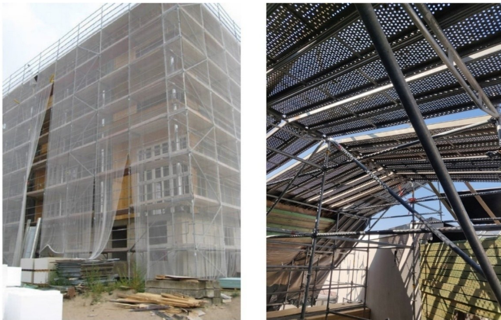
Figuur 106 - Tijdelijke werfbescherming via stellingen met zeilen rondom de hele structuur (links) (Gagnon & Karacabeyli, 2019) of lokale risicovolle zones (rechts) (Design Museum Gent).
