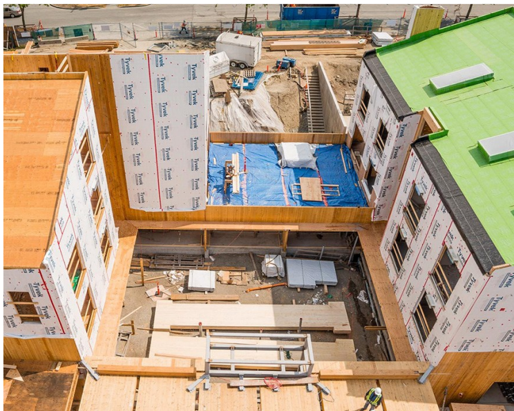
Figuur 52 - WRB aangebracht als weersbescherming over de gehele wandopbouw (Ronald McDonald House, British Columbia)
