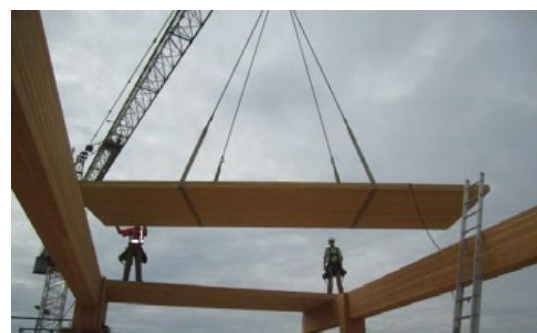
Figuur 108 - Hijssysteem met spanbanden onder het paneel (Gagnon & Karacabeyli, 2019)
