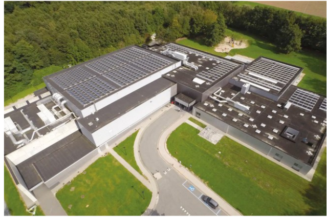
Figuur 68 - Veelheid aan installaties op een plat dak (WTCB 2022)
