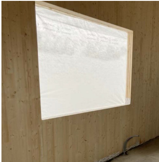
Figuur 104 - Tijdelijke bescherming van gevelopeningen, schachten en doorvoeringen (Pröbel & Alsmarker, 2022)
