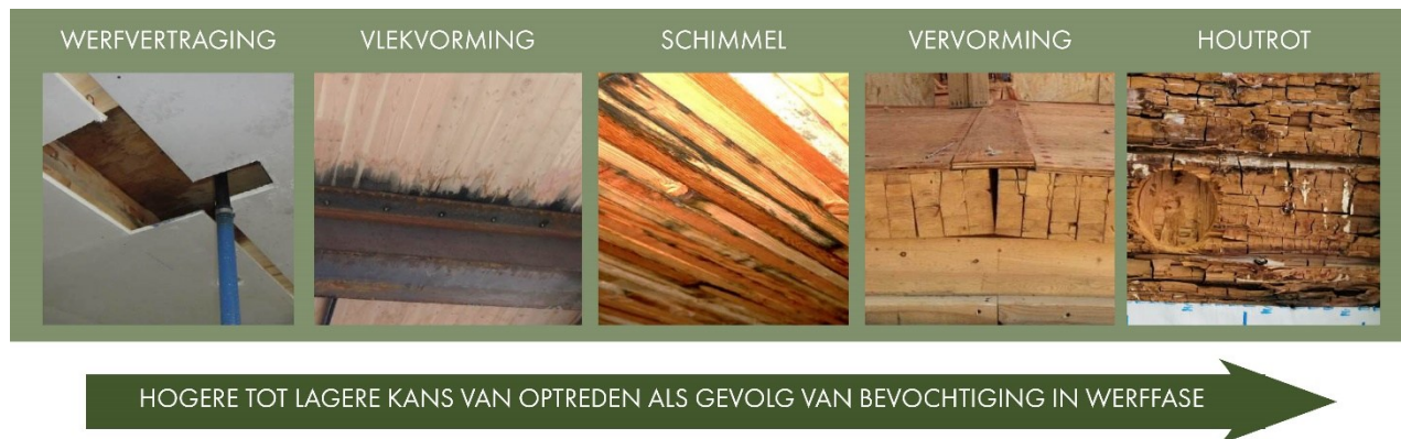
Figuur 36 - Progressieve schadefenomenen bij bevochtiging. Men krijgt meestal een eerste waarschuwing via bijvoorbeeld vlekvorming of blauwschimmel, vooraleer ernstige gevolgen en houtaantasting plaats vinden. (Shane 2024)
