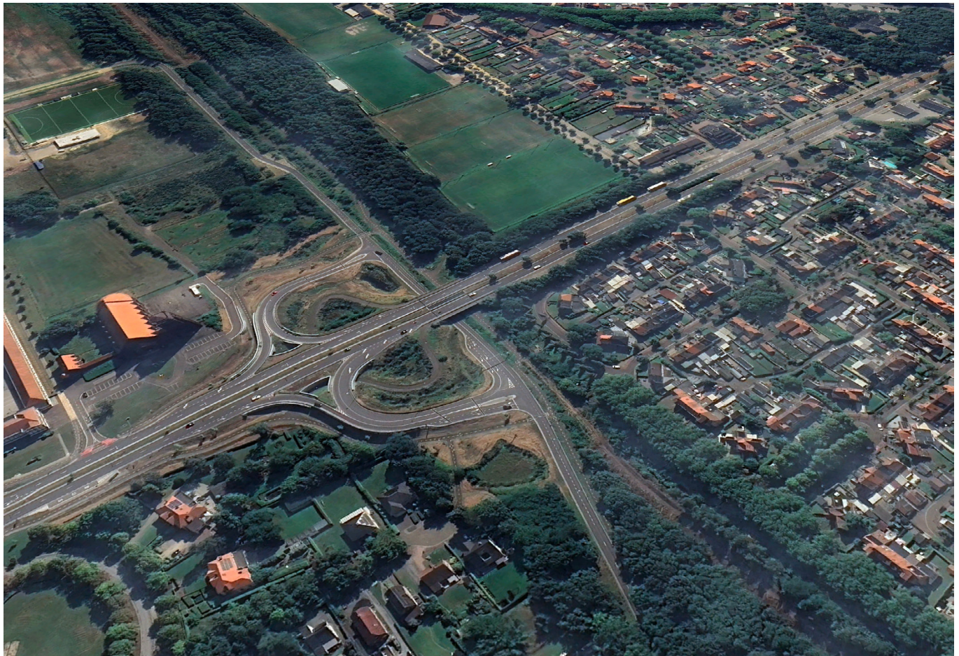
Figuur 25: Overzichtsfoto projectlocatie (Google Earth, 2023)
