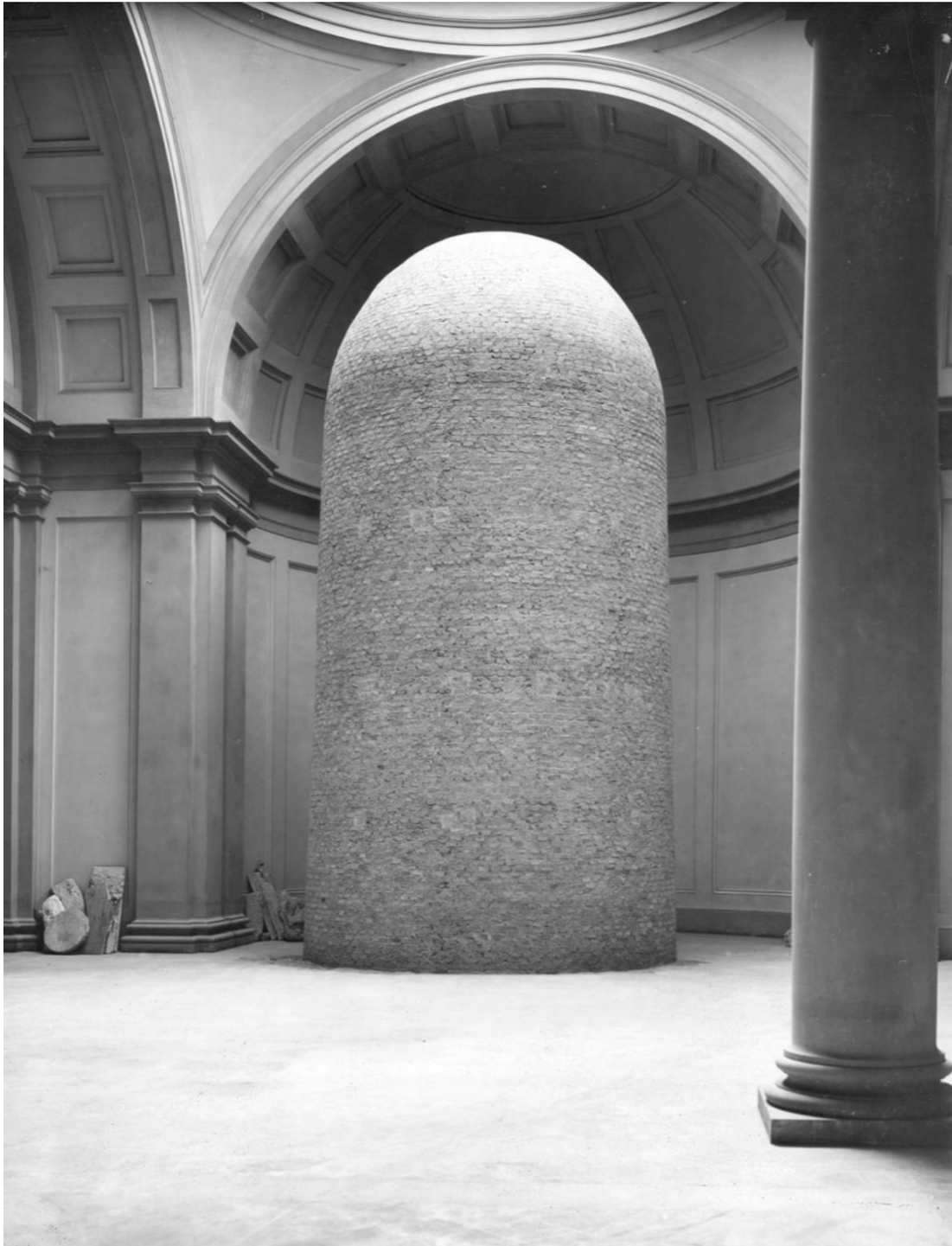
Figuur 2. David van Michelangelo ingemetseld in de Galleria dell'Accademia in Florence ter bescherming tijdens WOII
