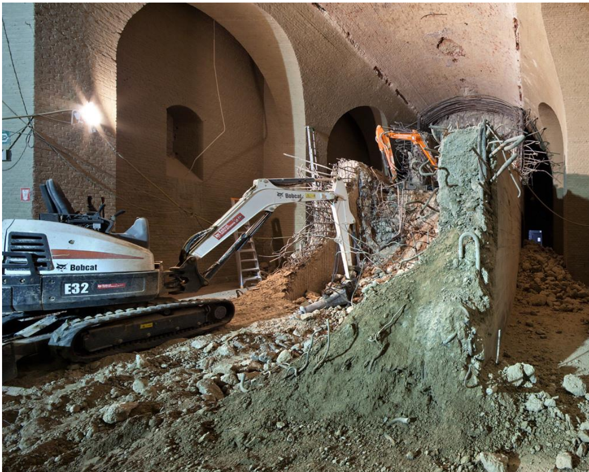
Figuur 5. Een kraan is volop bezig met het losboren van de gepantserde structuren van de atoomkelder in het KMSKA
