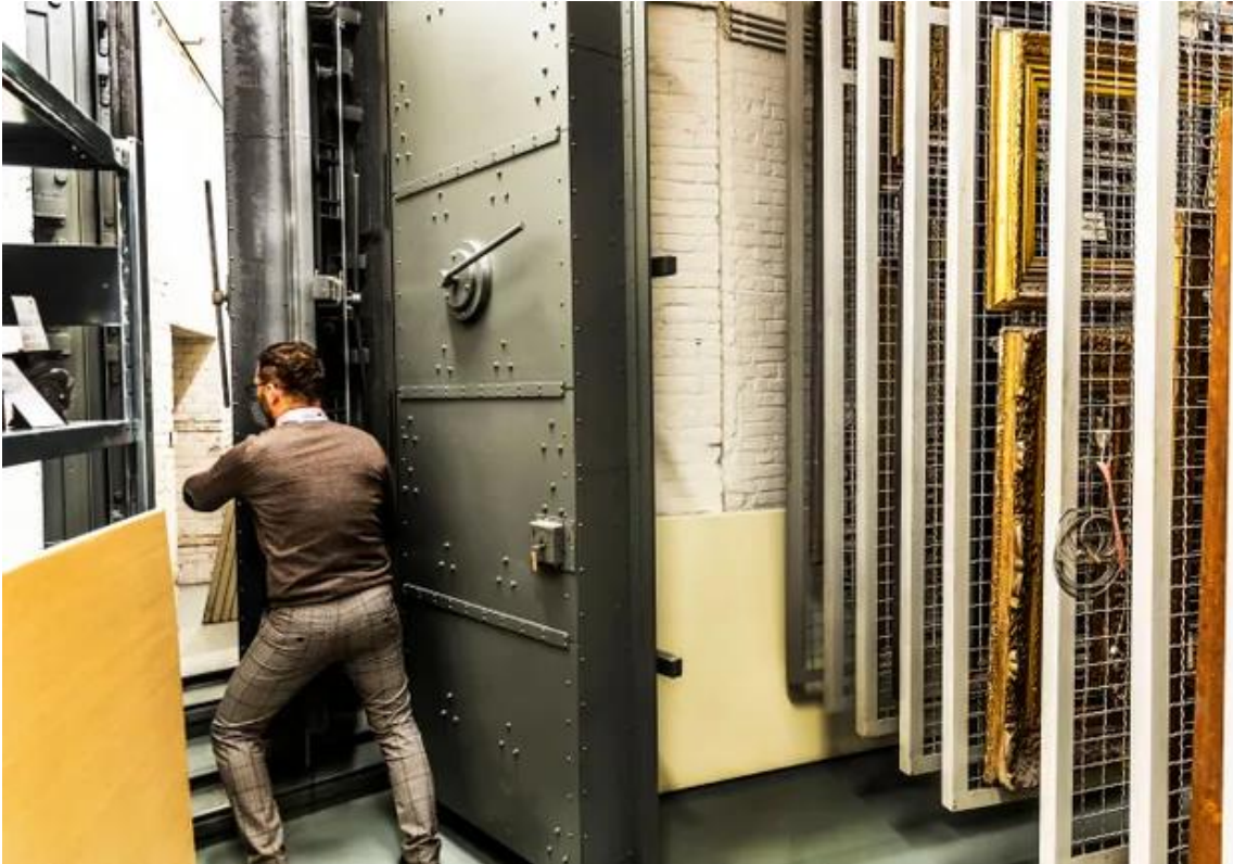
Figuur 6. Een museummedewerker van de KMSKB toont de gepantserde deur in één van de schuilkelders onder het museum
