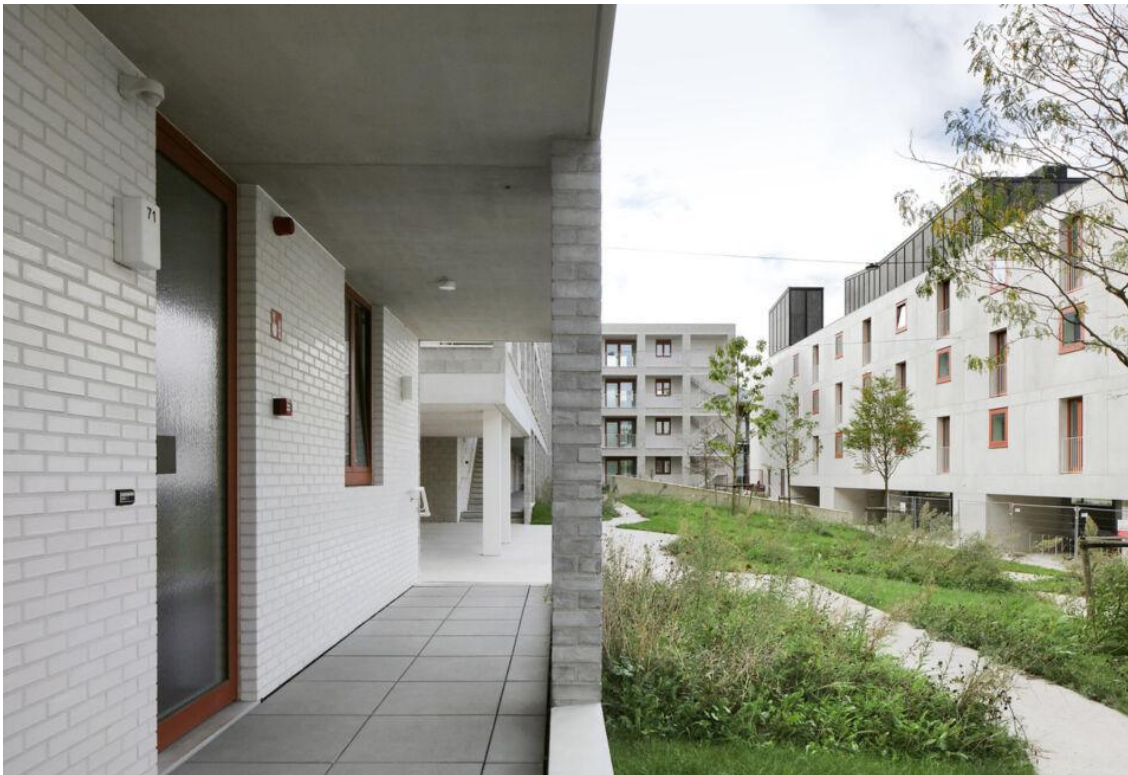
Figuur 21: KAAI 24 - zicht vanuit gaanderij sociaal woongebouw op binnentuin
