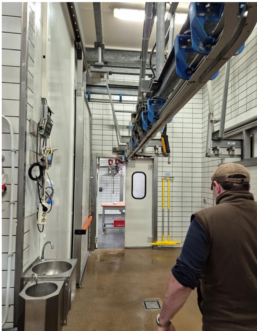
Fig. 25: Infrastructuur slachthuis Vande Walle deel 2 (bron: eigen auteur).
