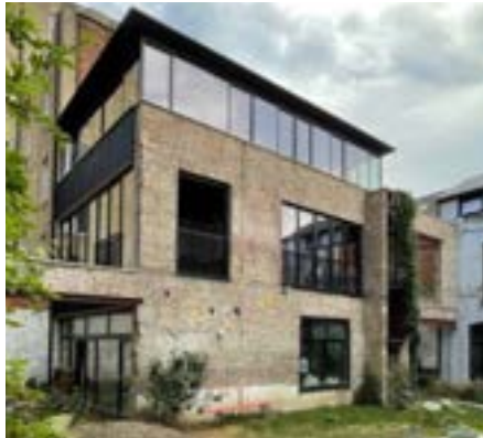
Figuur 3.42 Nieuw schrijnwerk in bestaande structuur
