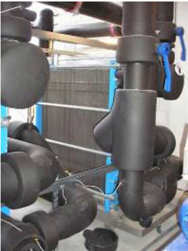
Figuur 44-45 Geïsoleerde leidingen in een energiestation (Universiteit Hasselt, 2023a).
