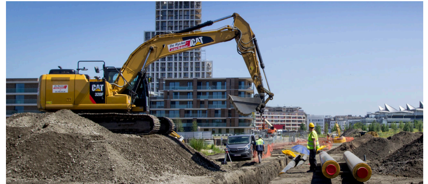
Figuur 19 Aanleg warmtenet Nieuw-Zuid in Antwerpen, België (Fluvius, 2024).
