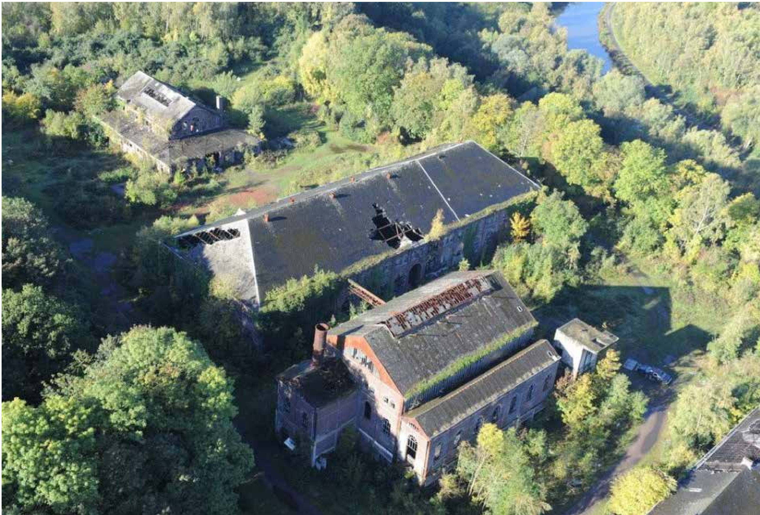
Fig. 2.11: Luchtfoto van de site Forte-Taille in Montigny-le-Tilleul. Bron: SPAQUE
