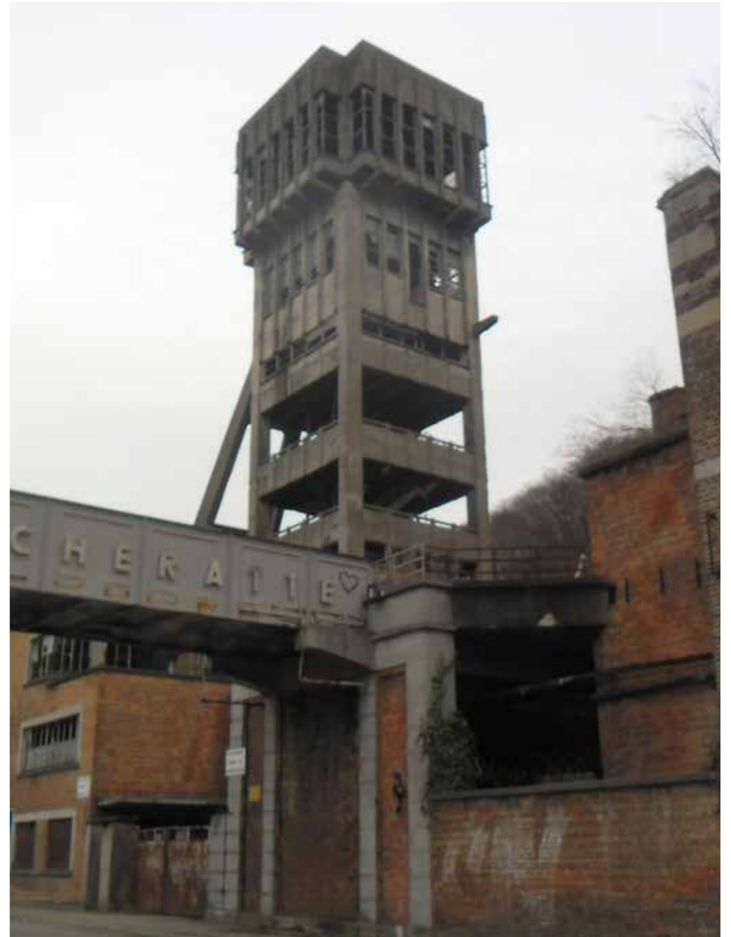
Fig. 2.10: Malakofftoren (L) en reeds verdwenen schachtbok (R) van Hasard de Cheratte. Bron: Serge V. via Google Maps
