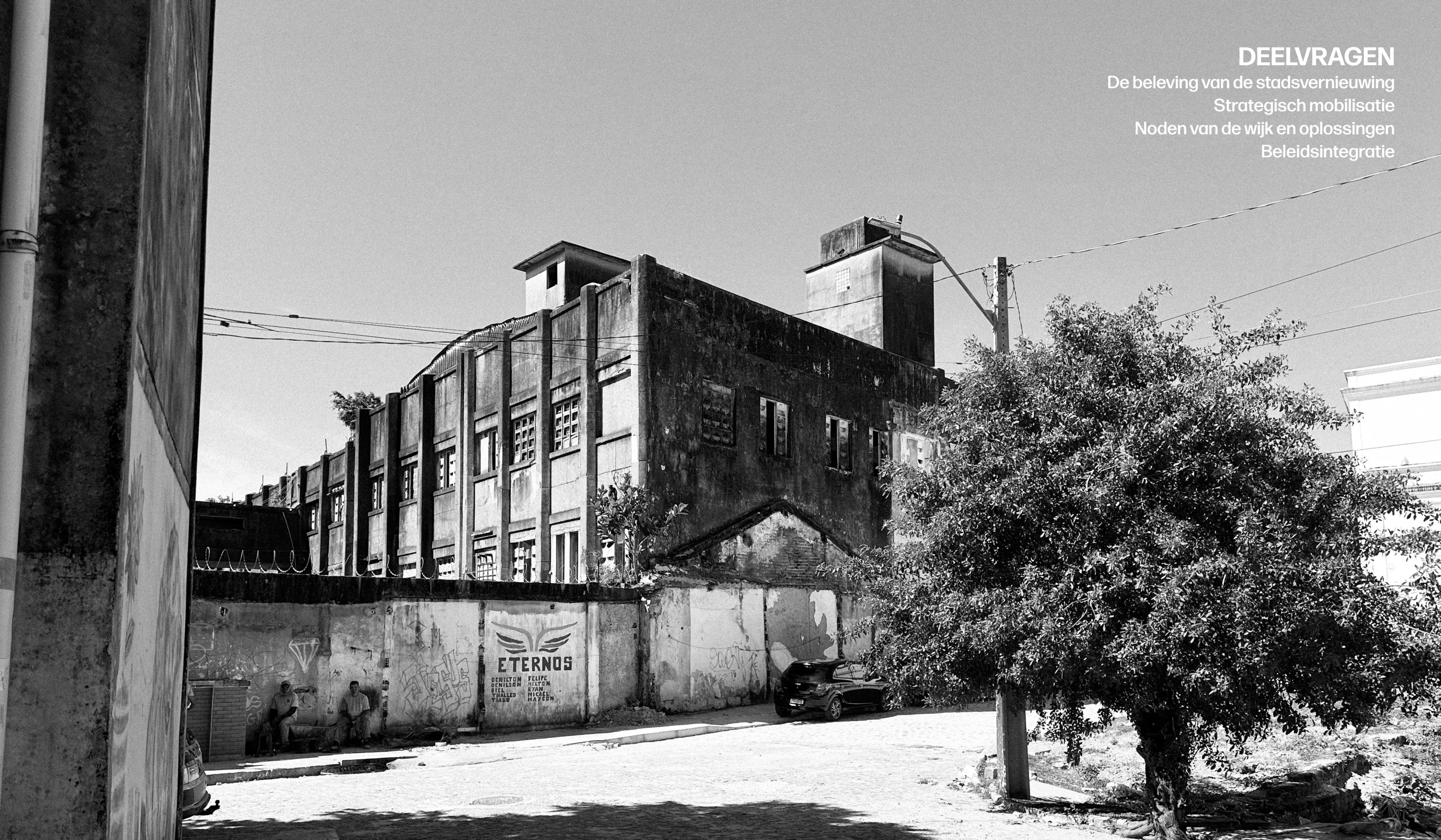
Figuur 127: Fábrica da Pilar Bron: eigen werk
