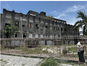
Figuur 93: Fábrica da Pilar Bron: eigen werk
