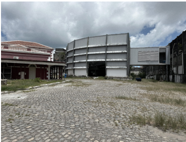
Figuur 90: Fábrica da Pilar Bron: eigen werk
