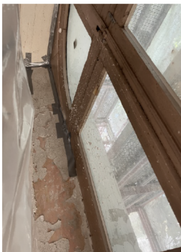
Figuur 5: dichting van de naden
