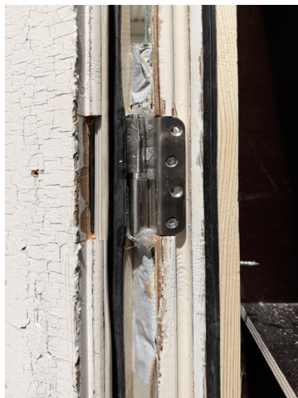
Figuur 48: wolfbek en scharnier ARE_{2f}
