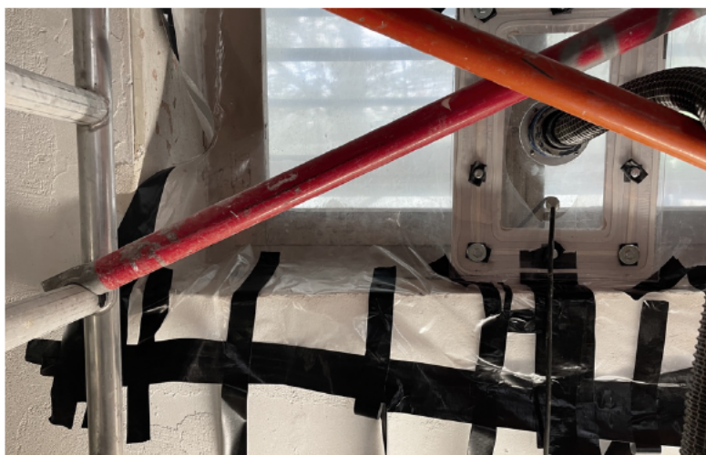
Figuur 7: losgetrokken tape (drukverschil te groot)
