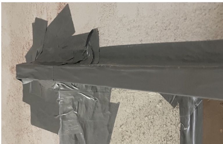
Figuur 6: dichtgeplakte aansluiting muur
