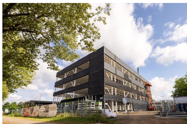
Figuur 30: Techbank in opbouw. Overgenomen van Open dagen op 12 en 13 september 2025 , door Techbank, 2025.
