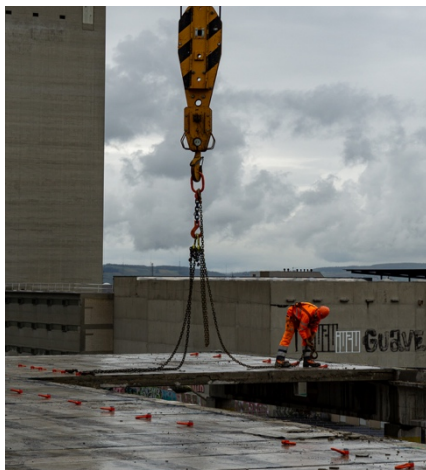
Figuur 58: Uithijzen van een geprefabriceerd TT-vloerelement. Overgenomen van Schiffner, 2024.
