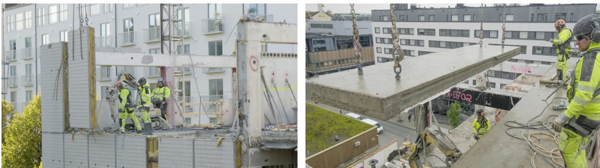
Figuur 49: Ontmanteling van een gebouw in Tampere door Umacon en Skanska. Overgenomen van Finland, door ReCreate project.
