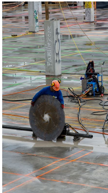
Figuur 125: Vervangen zaagblad diamantzaag. Overgenomen van Schiffner, 2024.
