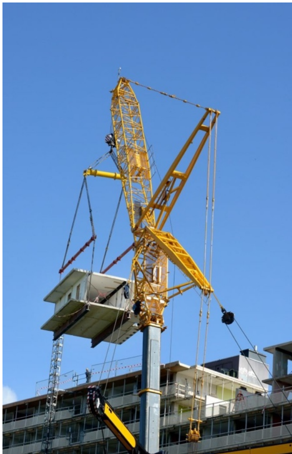
Figuur 34: Uithijzen van een unit in het Superlocal project. Overgenomen van SUPERLOCAL is genomineerd voor de Limburg Duurzaamheid Award 2019, door Super Circular Estate.
