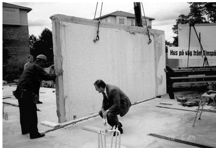
Figuur 55: Ontmantelen van een betonnen muur. Overgenomen van Eriksson, geciteerd in The conditions and constraints for using reused materials in building projects , door Eklund et al., 2003.
