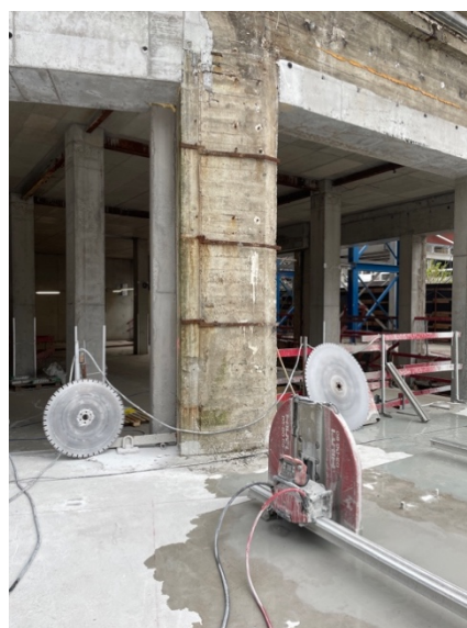
Figuur 20: Uitsnijden van betonmassieven . Overgenomen van Babini Geysen Architects, 2026.
