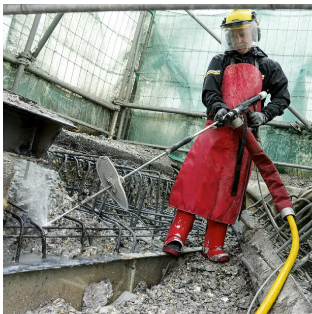
Figuur 95: Wapeningsstaven vrijmaken met hydrojet. Overgenomen van Betonreparatie met ultra-hogedruk waterstralen , door Kärcher.
