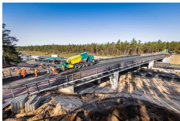
Figuur 41: Bouw viaduct A44 . Overgenomen van Erik Karst Fotografie, geciteerd in Waarom Nederland met z'n mooie wegennet stokoude 'tweedehands' viaducten neerzet , door Redactie TopGear, 2024.
