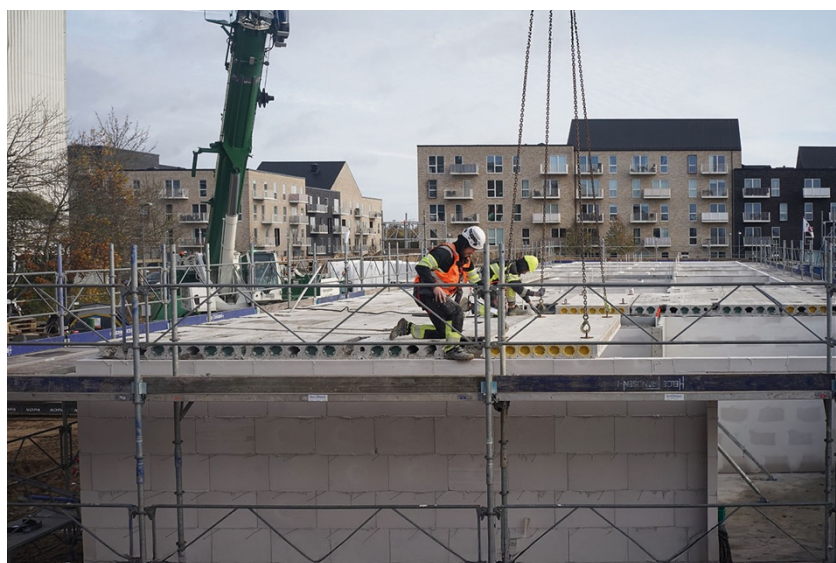
Figuur 70: Plaatsen van gerecupereerde holle welfsels in Gellerup . Overgenomen van GXN, geciteerd in (P)recast , door mpa, 2025.
