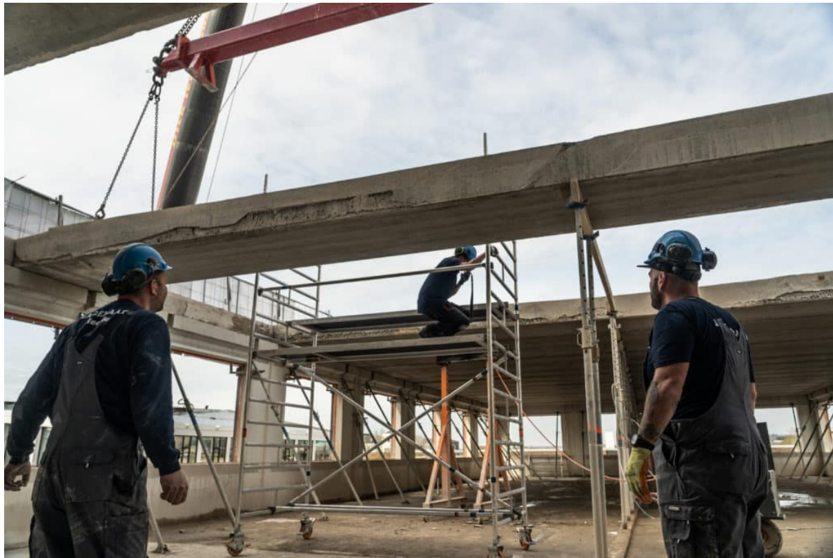
Figuur 168: Circulaire ontmanteling holle welfsels uit het Prinsenhof Arnhem. Overgenomen van 'Circulair slopen is een omgekeerd bouwproces', door Van Elburg, 2022.
