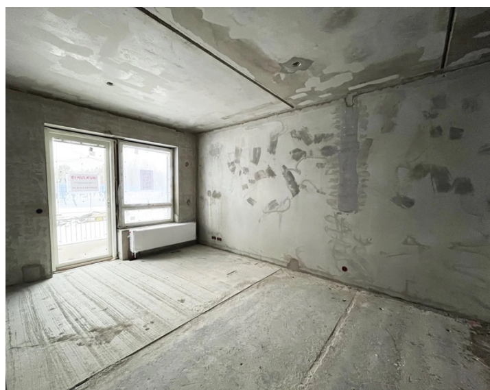
Figuur 50: Hergebruikte holle welfsels in Tampere, 6 km van het donorgebouw. Overgenomen van First elements reclaimed by the Finnish cluster reused in a real-life mini pilot, door ReCreate project, 2025.
