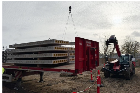
Figuur 69: Uitladen van gerecupereerde holle welfsels in Gellerup . Overgenomen van Falborg Pedersen (2024), geciteerd in Reuse of Concrete Element slabs in Terraced Houses in Gellerup , door AU Engineering, 2026.
