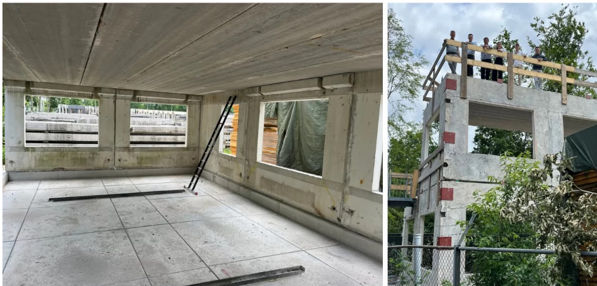
Figuur 28: Mock-up als voorbereiding op het Circulair Centrum Nederland. Overgenomen van The Dutch Mock-up: Building, Testing, and Learning for a Circular Future , door ReCreate project, 2025.
