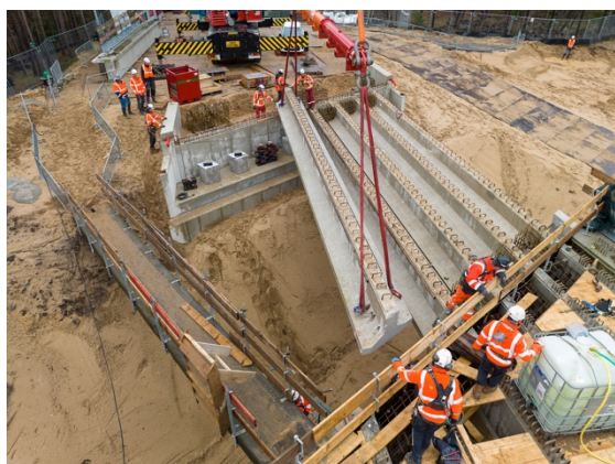
Figuur 42: Plaatsen van gerecupereerde brugliggers. Overgenomen van Hergebruik prefab liggers viaducten is duurzaam, veilig en haalbaar , door Haskoning, 2024.
