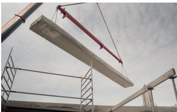
Figuur 26: Ontmanteling van een hol welfsel uit het Prinsenhof A. Overgenomen van Circulaire ontmanteling Prinsenhof A , door Lagemaat.
