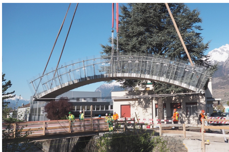
Figuur 63: Plaatsing van de Re:Crete brug in Conthey, Zwitserland. Overgenomen van Passerelle Re:Crete , door Bastien Masse, 2022.
