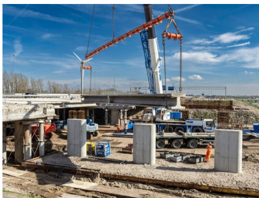
Figuur 38: Uithijsen van brugliggers. Overgenomen van Aan de slag met hergebruikte liggers! , door Beton & staalbouw, 2025.
