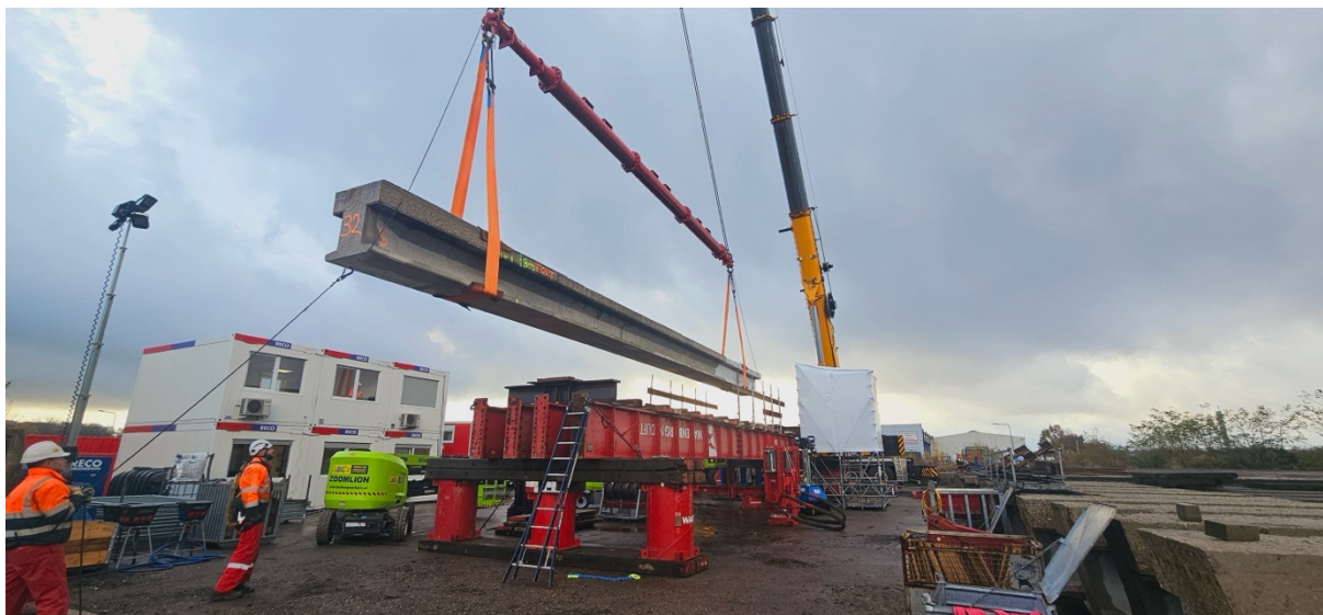
Figuur 40: Hijsen van een brugligger op een proefopstelling. Overgenomen van Modulaire testopstelling voor circulaire liggers , geciteerd in Infra services , door Royal Wagenborg.
