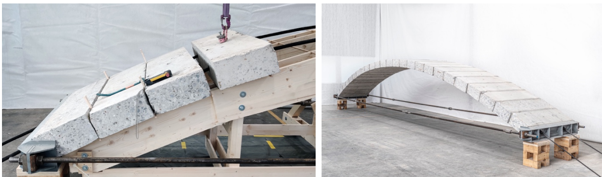
Figuur 62: Assemblage van uitgesneden betonnen blokken tot de Re:Crete brug. Overgenomen van Passerelle Re:Crete , door Bastien Masse, 2022.
