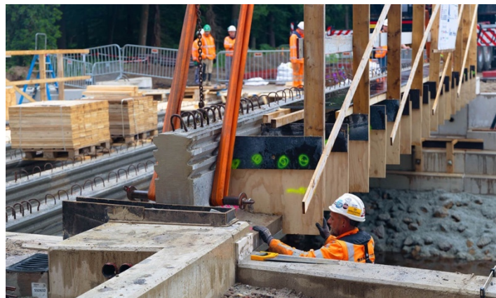
Figuur 36: Plaatsen van een gerecupereerde brugligger. Overgenomen van Drone Addicts, geciteerd in Vloedstegenbrug N18 Haaksbergen , door BruggenArchitectuur.
