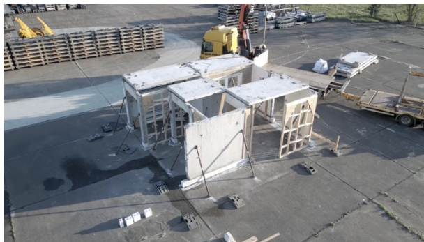
Figuur 46: Mock-up van de Duitse cluster in het ReCreate-project. Overgenomen van German country cluster completes test building , door ReCreate project, 2024.
