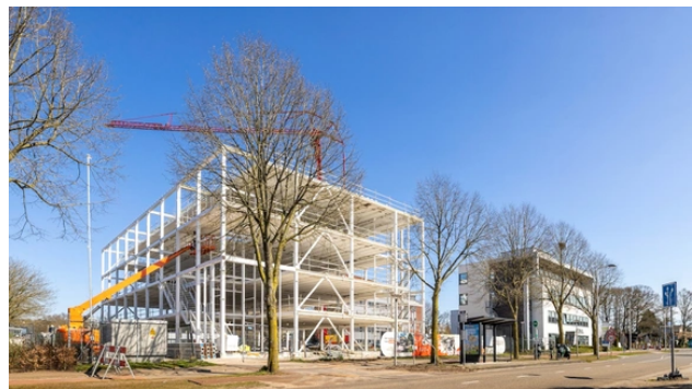
Figuur 31: Heropbouw techbank. Overgenomen van Koggel, geciteerd in Een gebouw demonteren en elders weer opbouwen? Kan gewoon! , door Cepezed, 2025.
