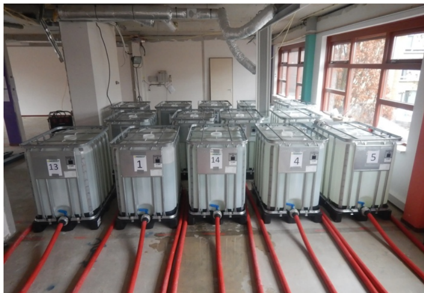
Figuur 103: Proefbelasting in situ met watertonnen. Overgenomen van Proefbelasting , door Nebest.
