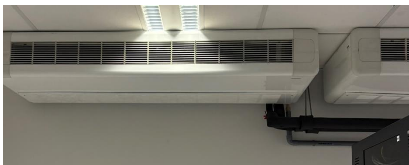
Figuur 17: Ventiloconvector datalokalen
