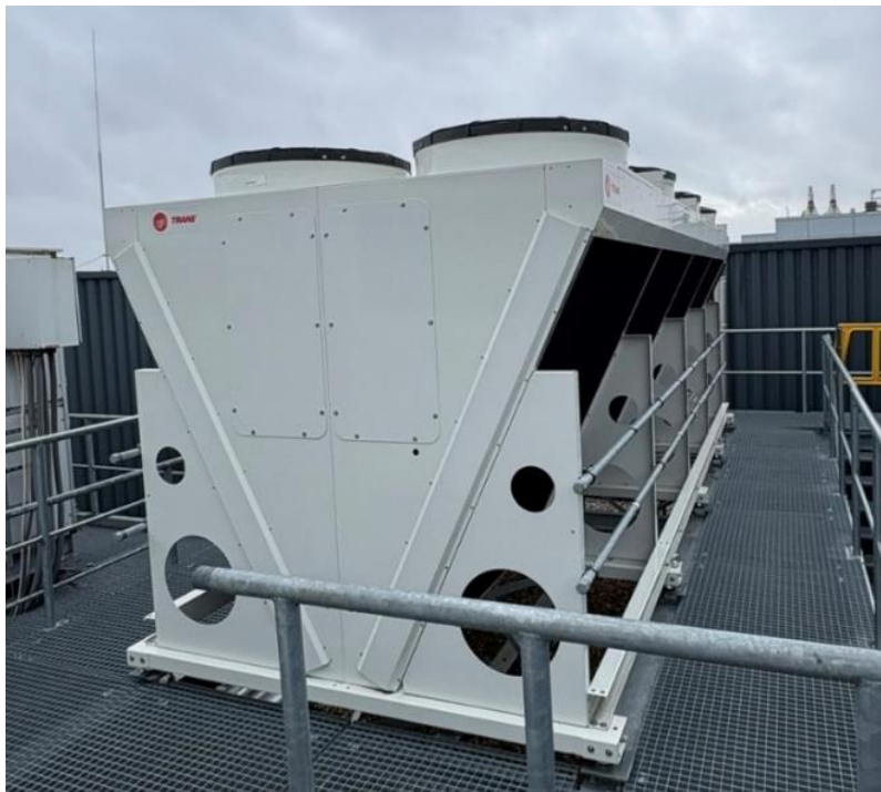
Figuur 8: Dry cooler
