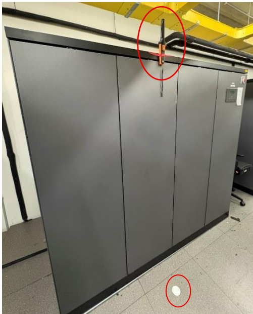
Figuur 30: Meetpunten luchttemperatuurmeting klimaatkasten
