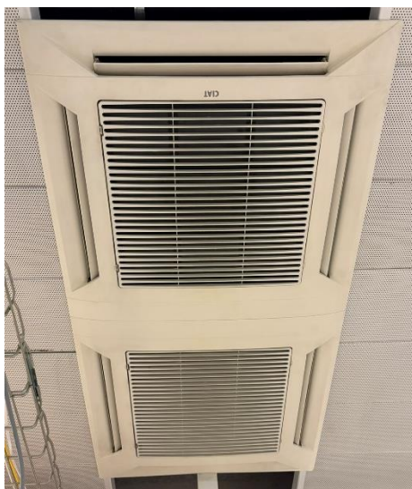
Figuur 18: Plafondunit
