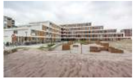
Woonproject voor starters met modulaire en tijdelijke woningen, Amsterdam IJburg (Foto Nadine Korringa)
