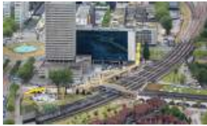
Luchtsingel, Rotterdam (ZUS Architecten) - Foto Ossip van Duivenbode.
