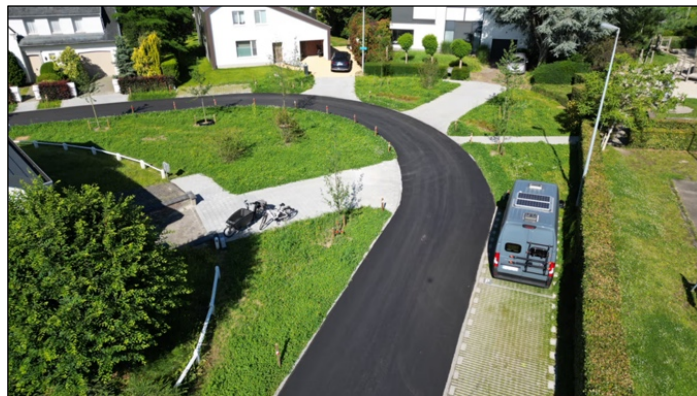
Figuur 14: Spaanse Kroonwijk in Leuven na de heraanleg, foto van Stad Leuven (Pierlet, 2024)
