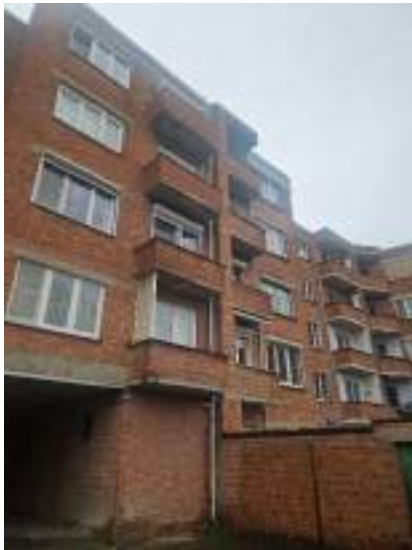
Afb. 26 Balkons die getest worden (eigen foto)
