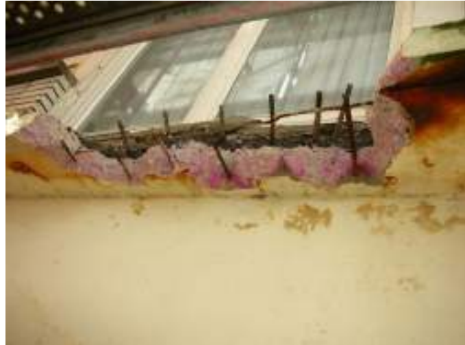
Afb. 23 Fenolftaleïne test (Buildwise – voorheen WTCB) Afb. 24 Destructie tot op niet gecarbonateerd beton (Joost Beke)
