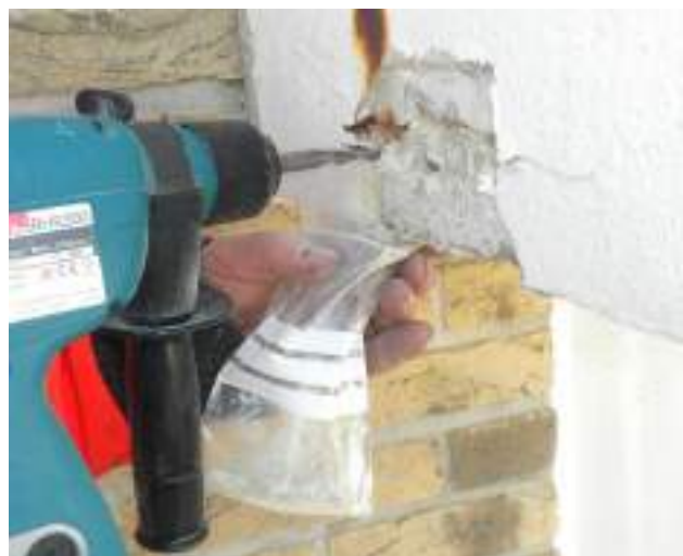
Afb. 57 Nemen van een betonstaal door boring (Joost Beke)
