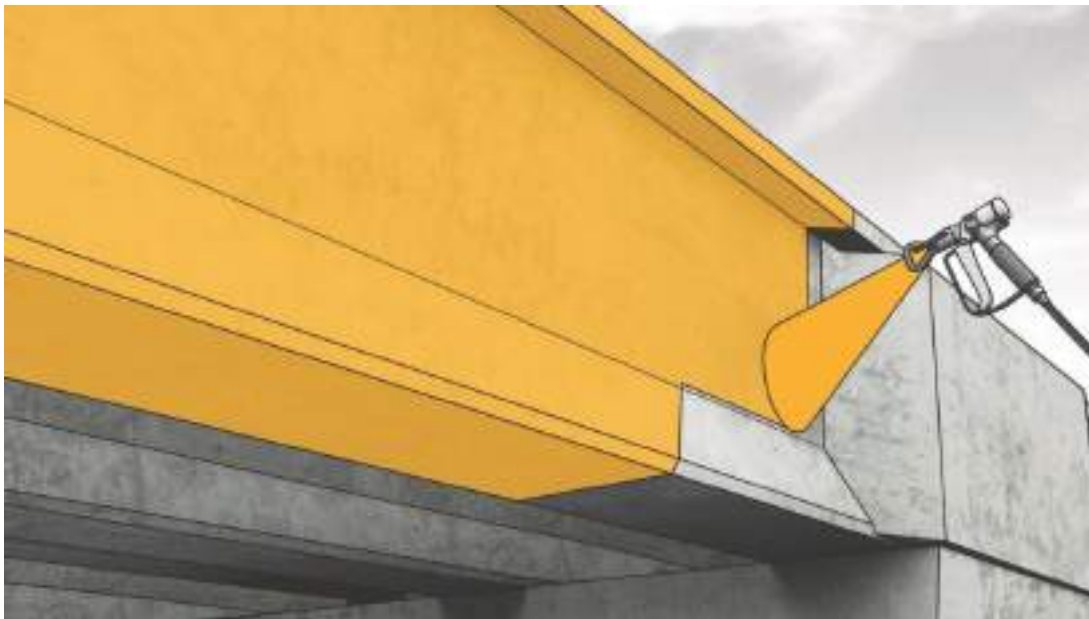
Afb. 37 Aanbrengen van een beschermende coating op beton ter beperking van carbonatatie en vochtindringing (Sika)
