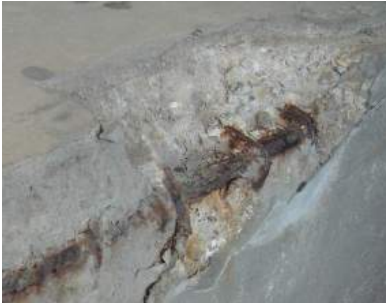
Afb. 1 Carbonatatatie veroorzaakt corrosie bij wapening (Wikipedia)
