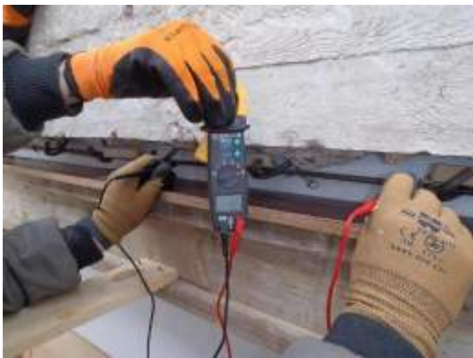
Afb. 22 Uitvoering halfcelpotentiaalmeting op wapeningsstaal (Joost Beke)
