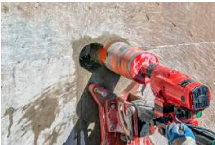
Afb. 36 Kernboring in beton als destructieve onderzoeksmethode
