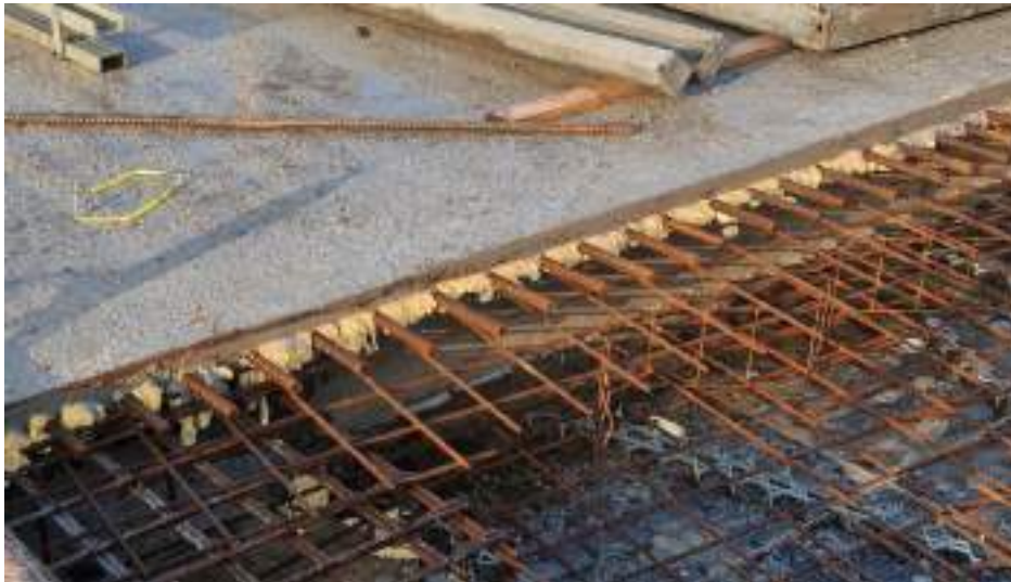
Afb. 54 Betondekking (eigen foto)
