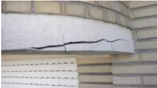
Afb. 11 Scheurvorming (Joost Beke)
