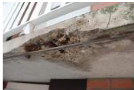
Afb. 39 Afbrokkeling (Konstant)
