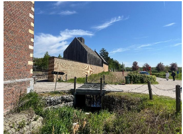
4 Ingang langs Paardenstallen brasserie
