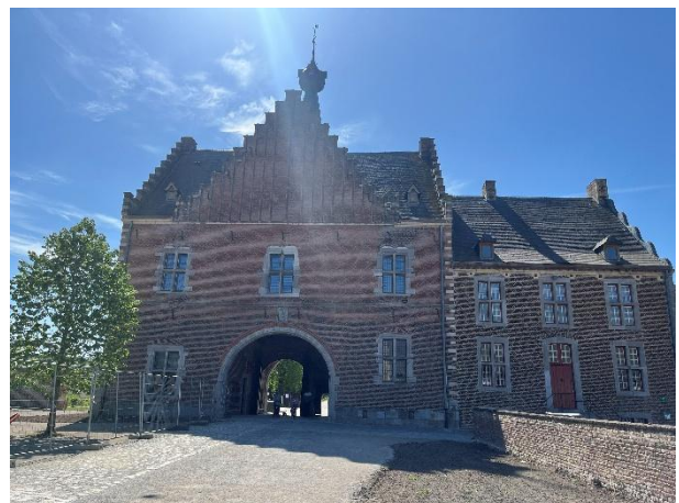
6 Poortgebouw en portierswoning
