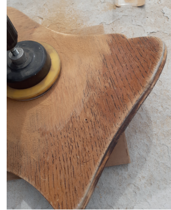
Figuur 87: Vernislaag verwijderen met schuurschijf. Eigen afbeelding.
