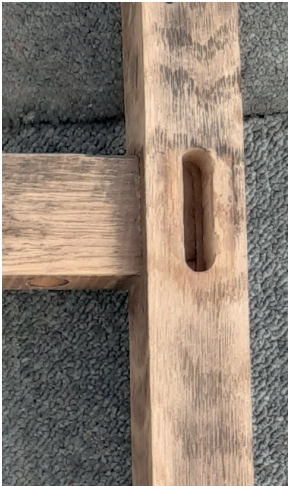
Figuur 108: Oude pen-en-gat-verbinding. Eigen afbeeldingen.
