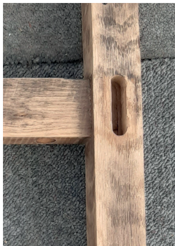
Figuur 64: Locatie van de ingelijmde pen-en-gatverbinding. Eigen afbeelding.
