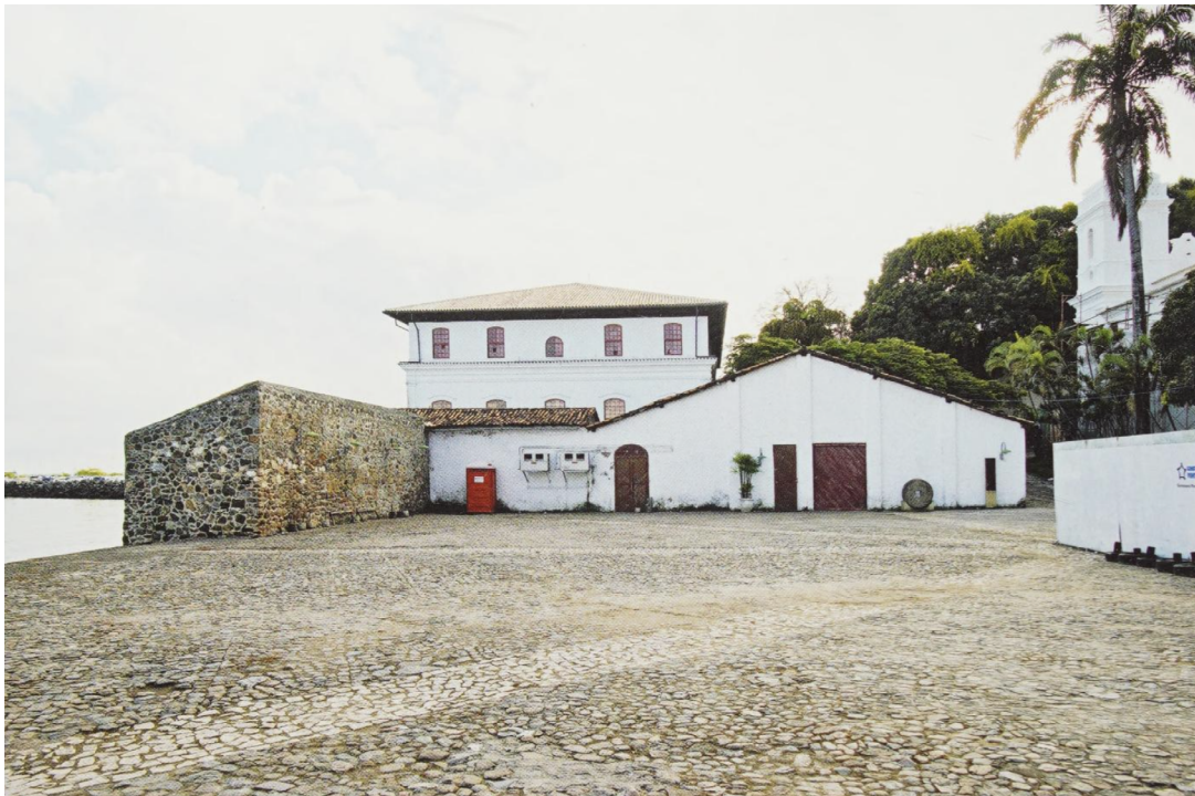
fig [3.3] Exterior Solar do Unhão_1959-1963
