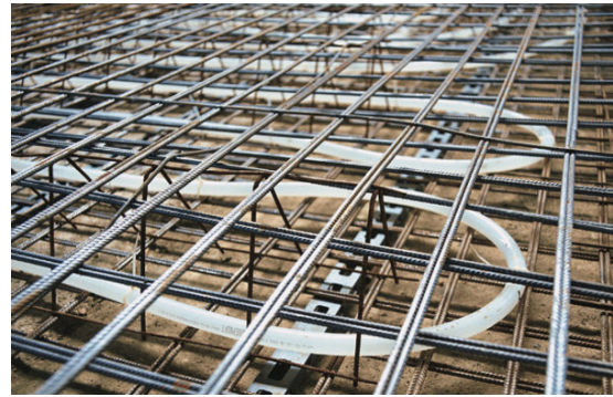
Figuur 31: Betonkernactivering (Bouwlogie, 2014)
