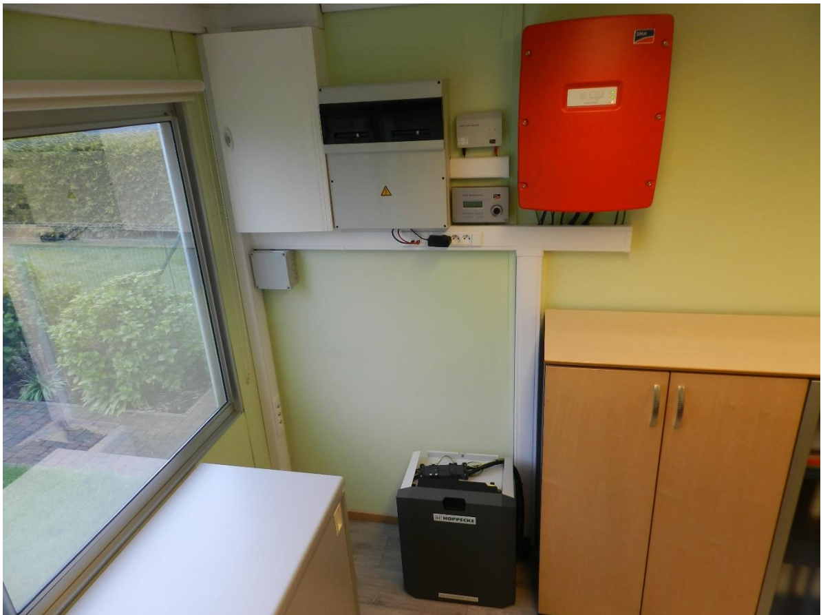
Figuur 33: Afgewerkte installatie
