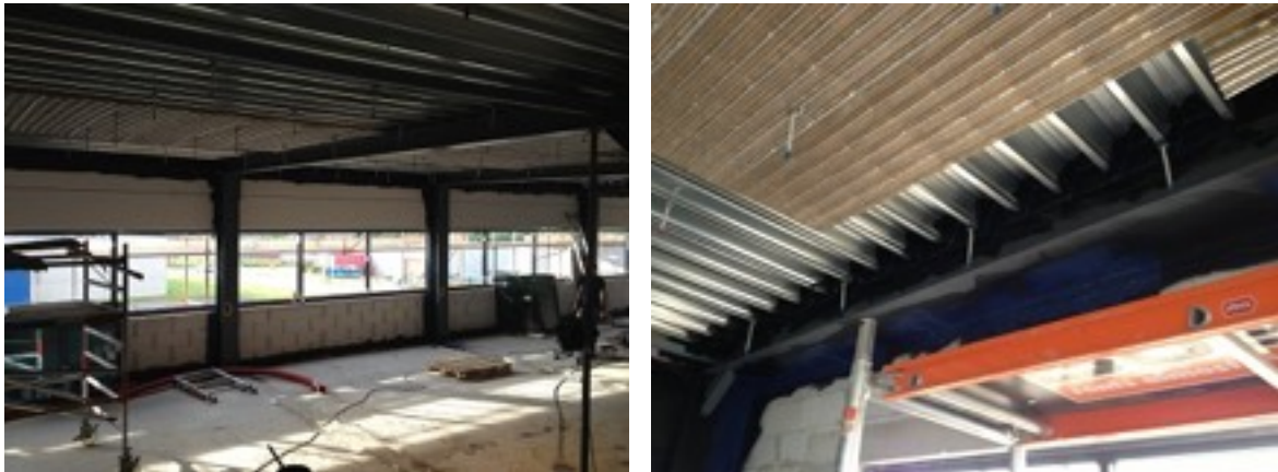
Figuur 3.18 Toepassing luchtdichte coating
