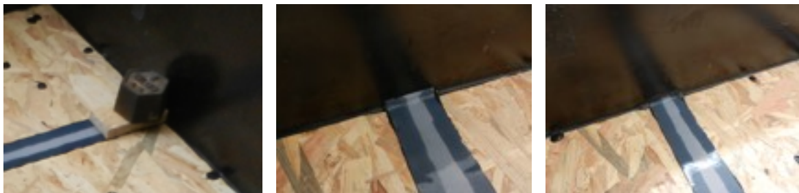
Figuur 2.21 Hoekaansluiting
