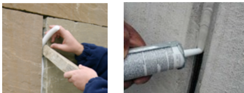
Figuur 3.15 Toepassing van backer rod en kitvoeg
