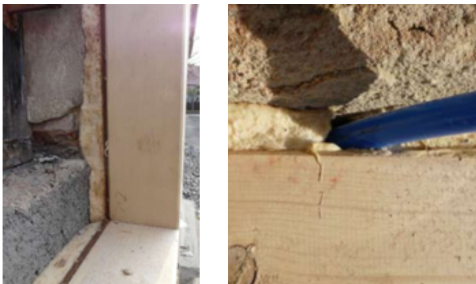
Figuur 3.22 links: Vulling met minerale wolmat, rechts: Inblaasgat voor cellulosevlokken
