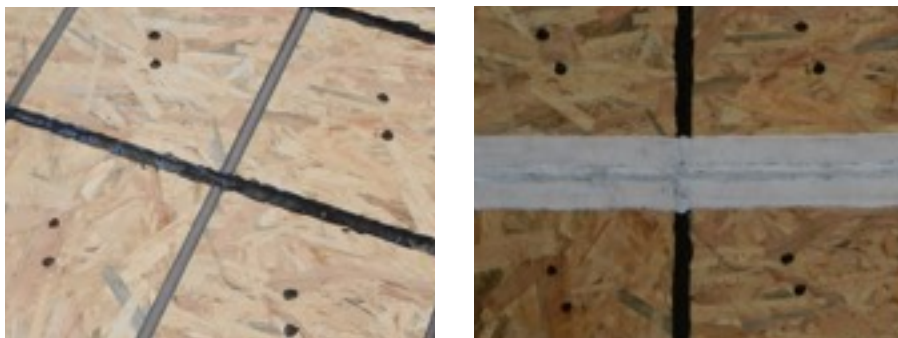
Figuur 1.3 Links: Silicone (zwart) op rugvulling (grijs), Rechts: Coating (wit) op silicone (zwart)
