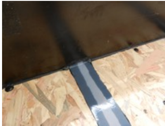
Figuur 2.18 Randaansluiting silicone strip
