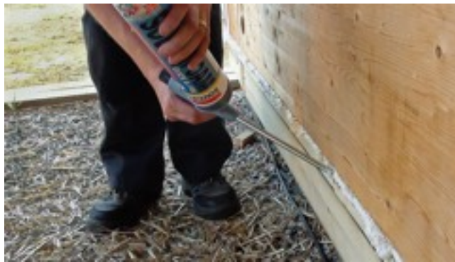
Figuur 3.16 Toepassing van PUR-schuim
