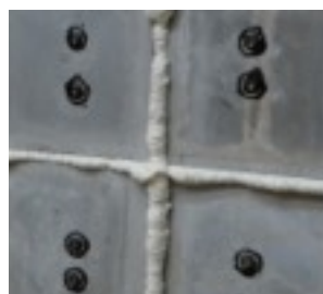
Figuur 1.4 Polyurethaanschuim tussen betontegels
