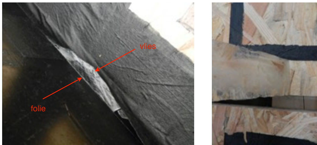
Figuur 2.12 Opbouw tape B
