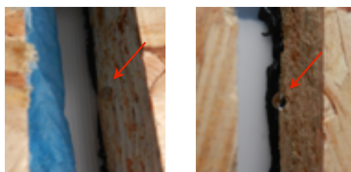
Figuur 3.1 Waterdruppeltjes door zijkant OSB
