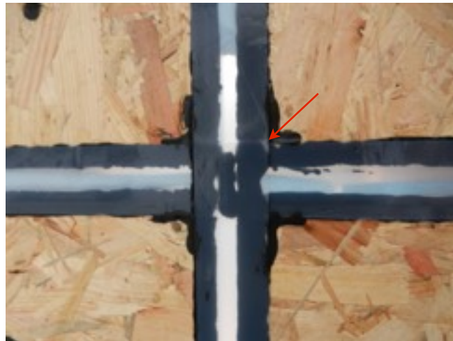
Figuur 3.3 Waterlek ten gevolge van niet voldoende aandrukken silicone
