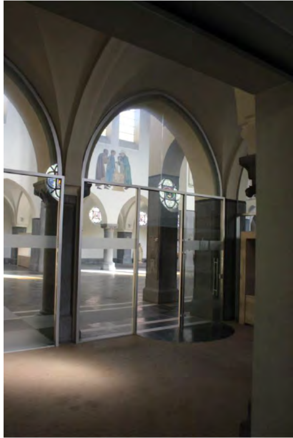
Figuur 140: glaspanelen om zijbeuk af te sluiten van middenbeuk, klooster testcase De Huizen
