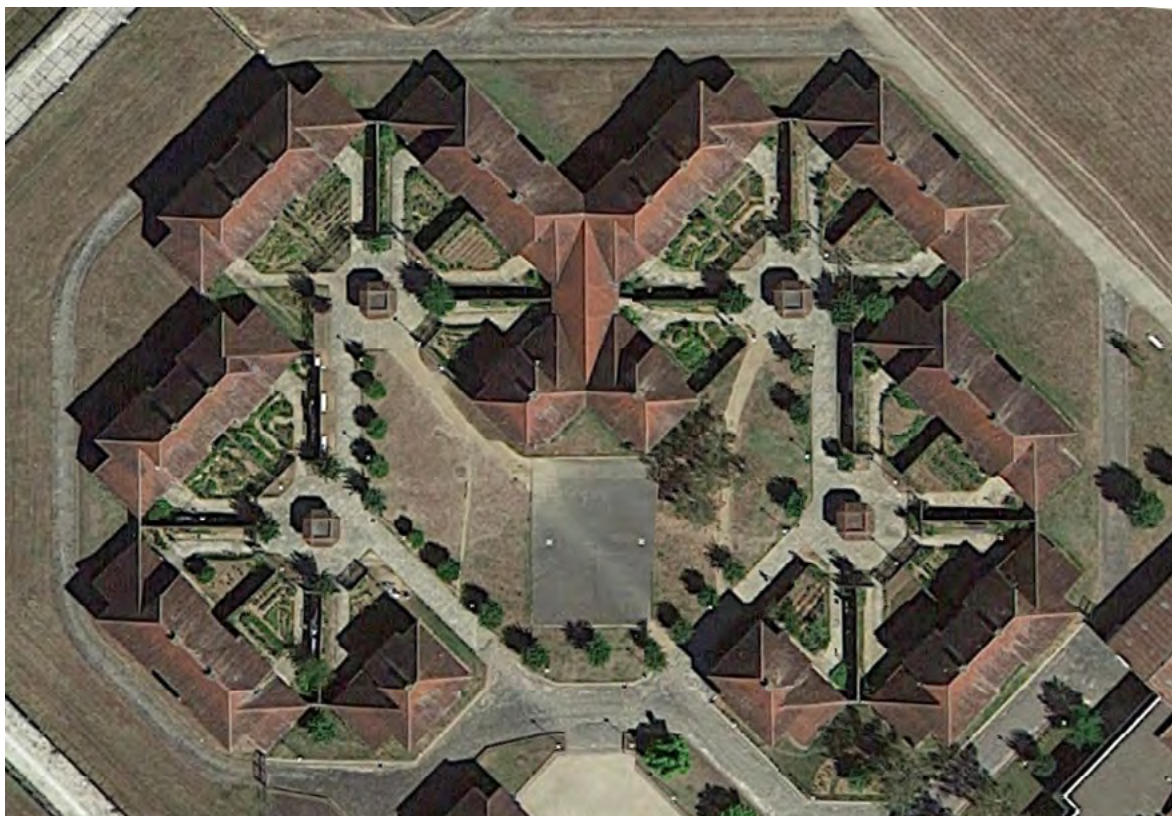
Figuur 54: bovenaanzicht van de paviljoengebouwen in Le Nouveau Mauzac
