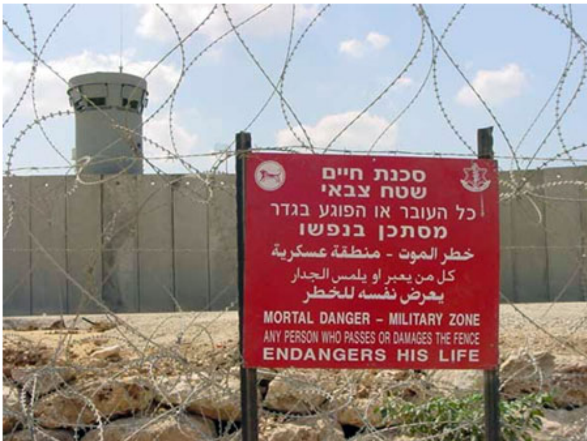
De muur als betonnen constructie in Qalqilya.
