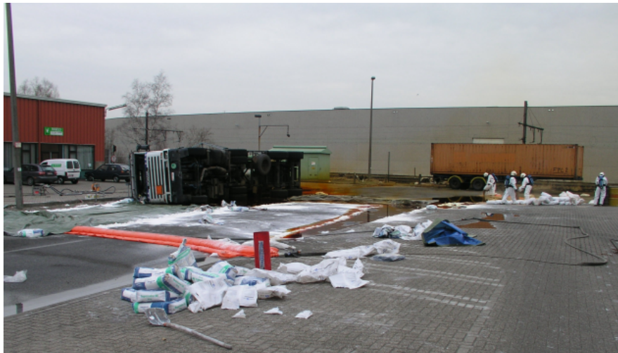
Figuur A.2: Afdammen en bedekken van de vloeibare broom nabij de gekantelde vrachtwagen
