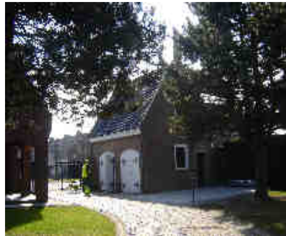
Achterzijde dienstgebouw links
