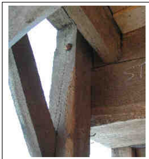
Figuur 127: De spoorstijl verstevigd door middel van een spilbout
