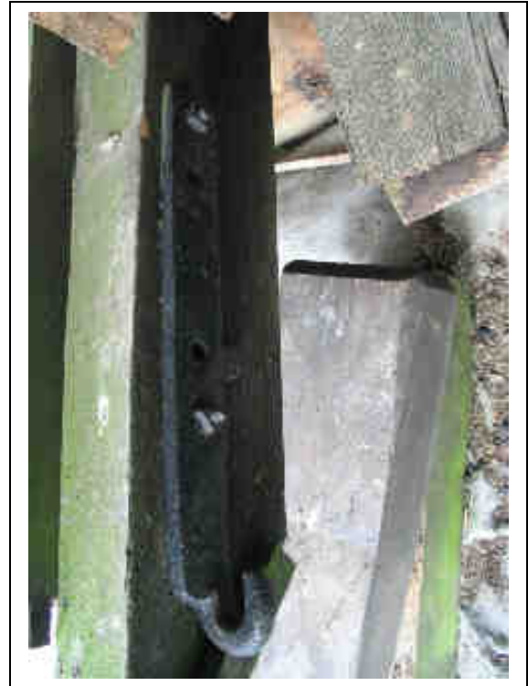
Figuur 52: Verbindingshaak trap - balkon
