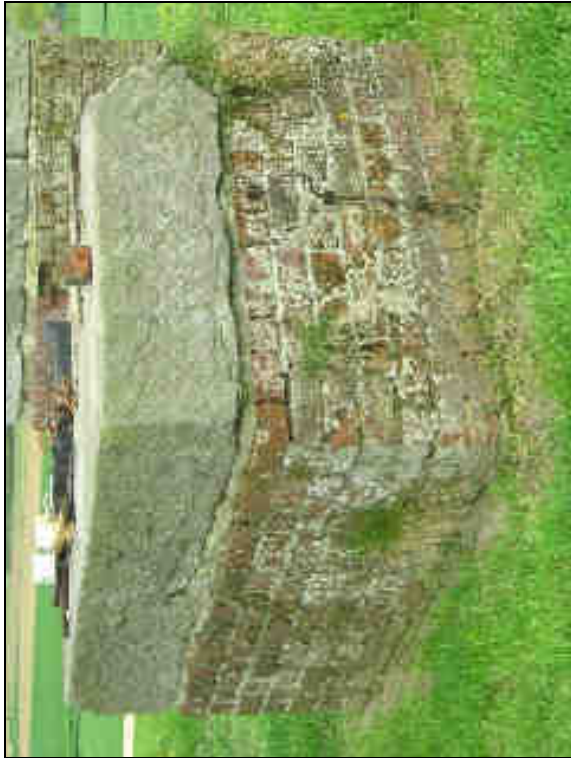
Figuur 63: Plantengroei en losse voegen aan de teerling
