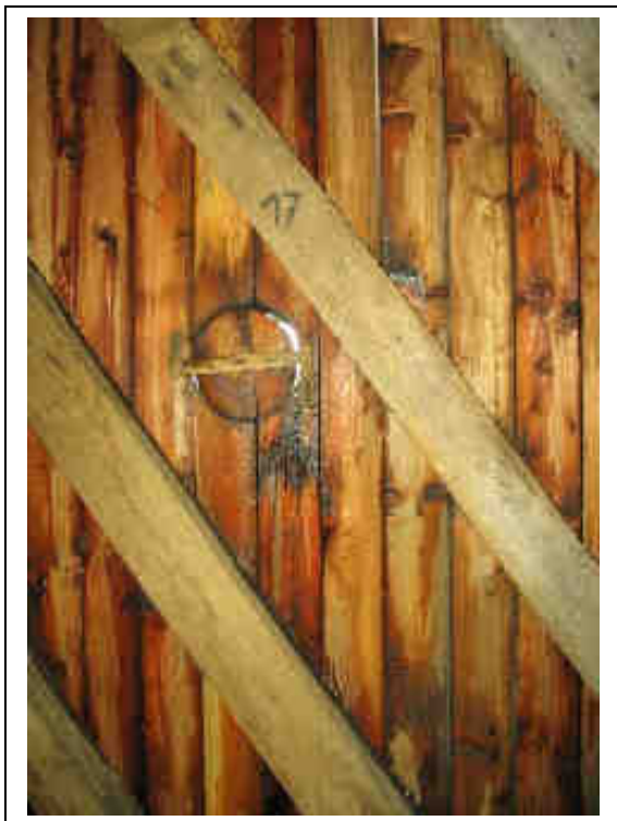
Figuur 76: Weegbanden – waterinfiltratie
