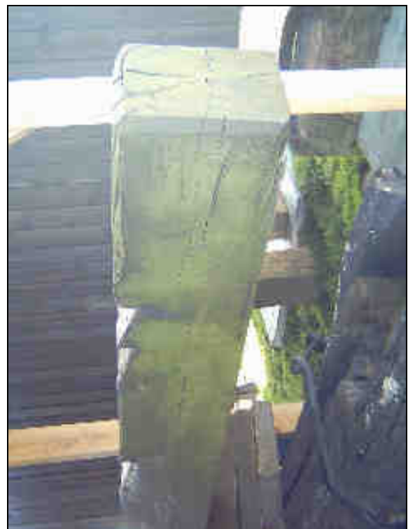
Figuur 66: Kruisplaat met stervormige hartscheur en langscheuren
