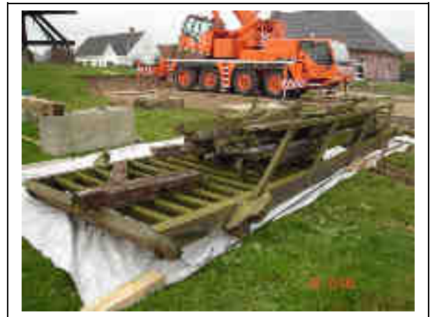
Figuur 114: Stapeling van de trap en losse onderdelen op de worteldoek
