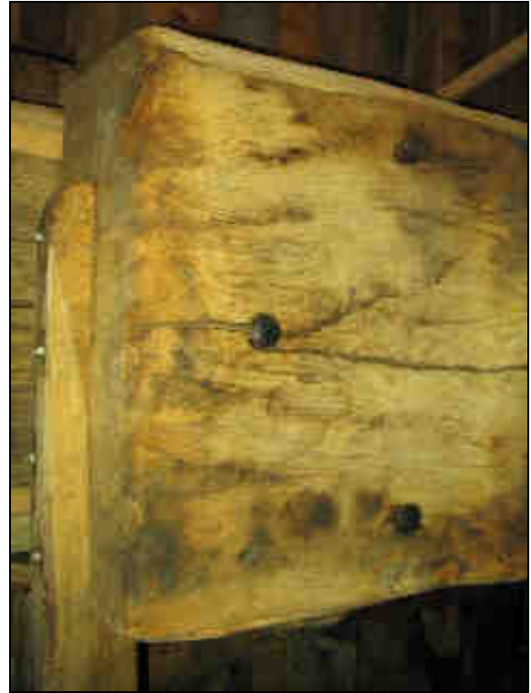
Figuur 73: Boezem met krimpscheuren en borgijzers
