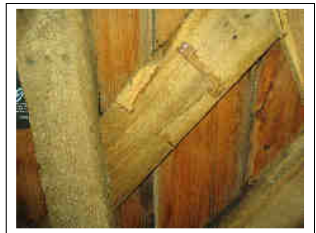
Figuur 107: Zwaluwstaartverbinding (Westermolen / Kaprijke)
