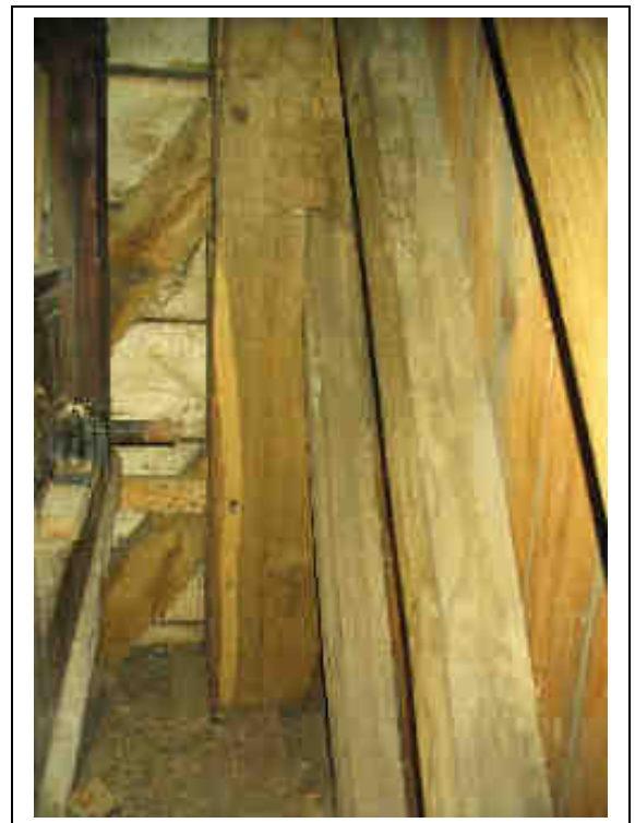
Figuur 74: Hoekstijl met spint en schors
