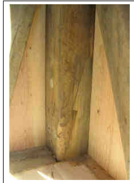
Figuur 106: Schuine haaklas (Kruiskoutermolen / Erpe-Mere)
