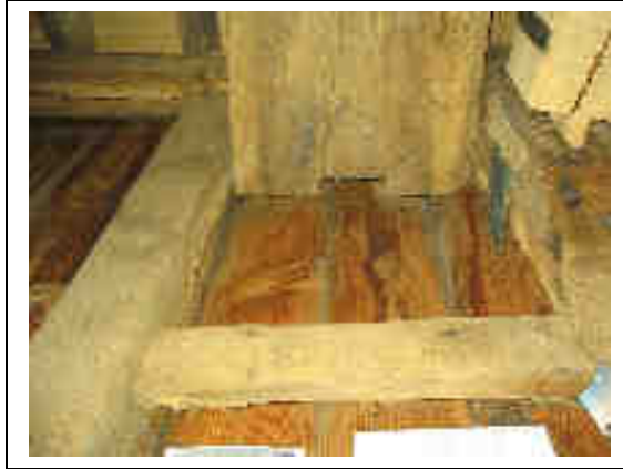
Figuur 126: De steenbalk met sporen van een moerstijl
