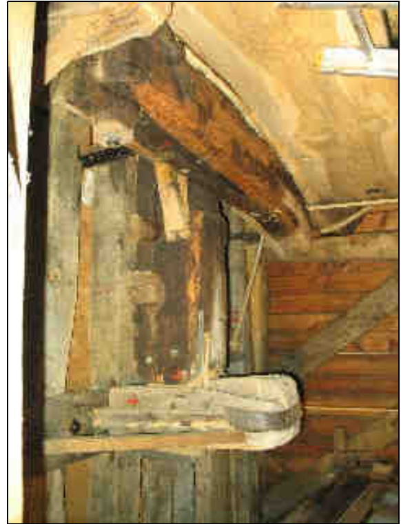
Figuur 89: Lichtewerk
