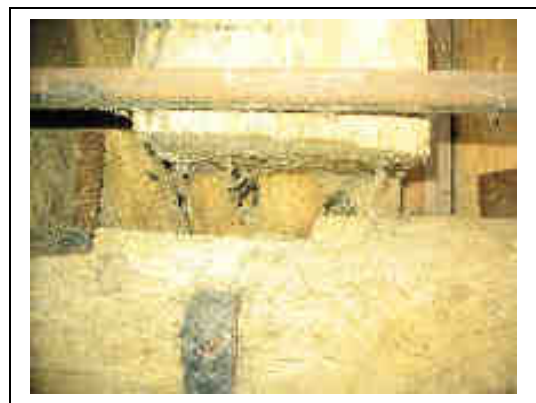
Figuur 123: De pen- gatverbinding met de middenlijst
