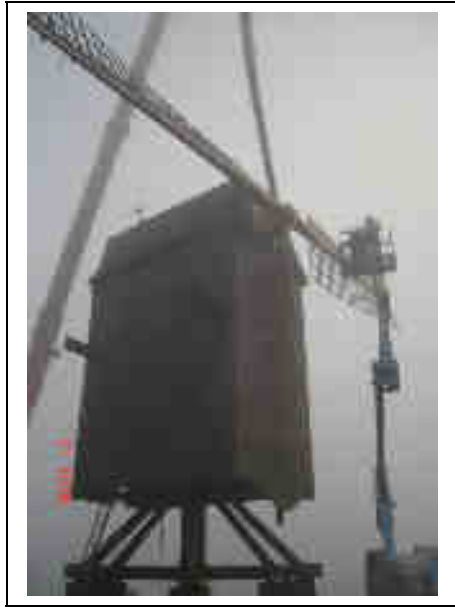
Figuur 116: Uitmaken van de binnenroede, aan één zijde is het hekwerk verdwenen zodat men ze eruit kan trekken
