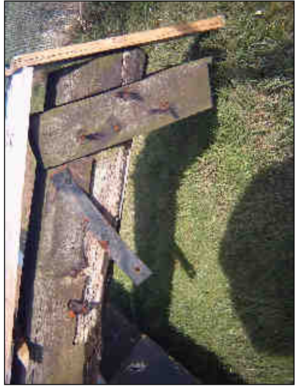
Figuur 69: Rot aan de staart thv de mannesstijlen
