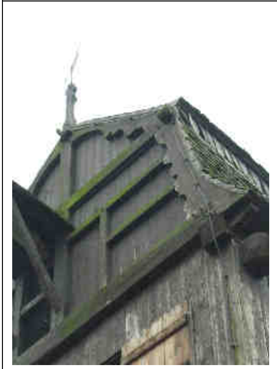
Figuur 49: Afwerking vanegespan
