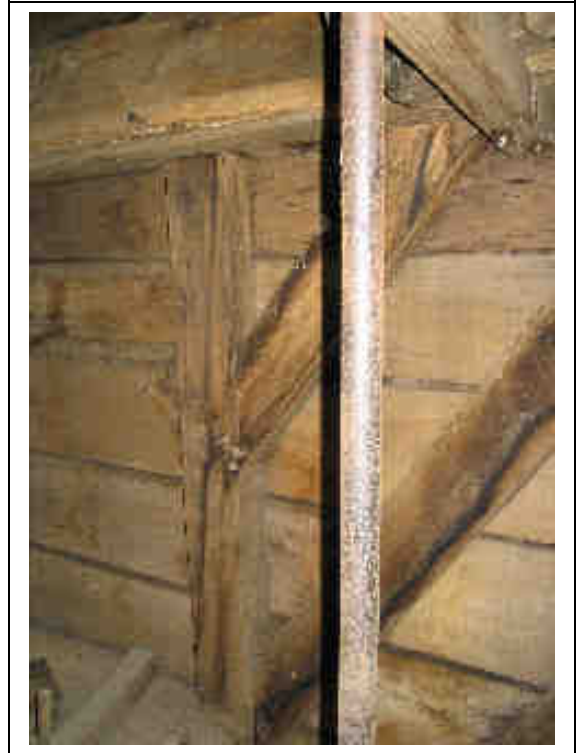
Figuur 77: Weegbanden – bruinverkleuring
