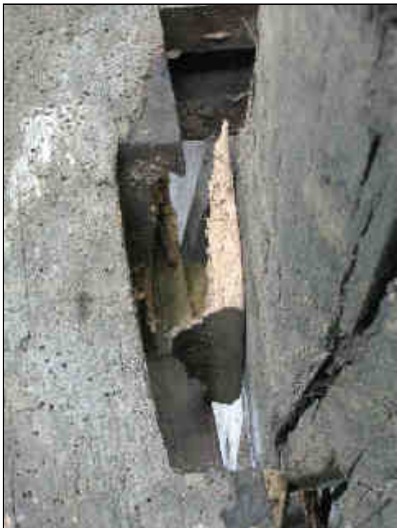
Figuur 68: Zetel aangetast door de grote klopkever
