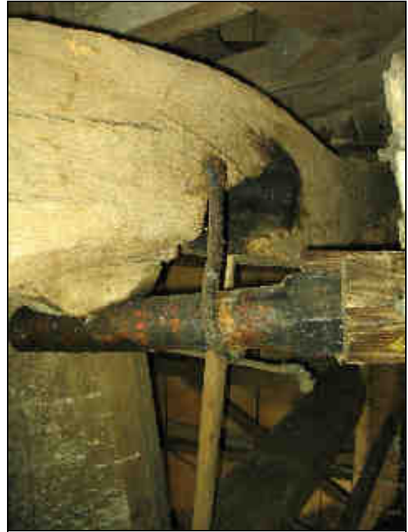
Figuur 85: De ijzerbalk en een roestig kluwijzer
