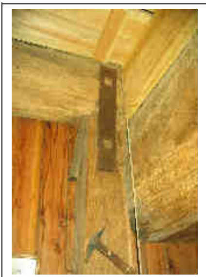
Figuur 131: Versteviging aan de middenlijst en met een spie
