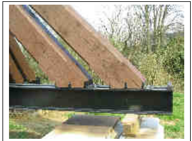
Figuur 144: Metalen kruisplaten
