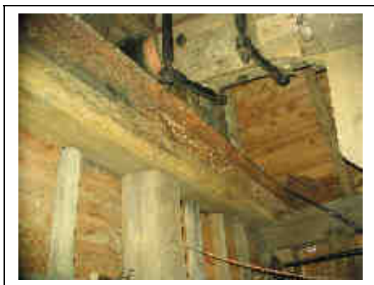
Figuur 122: Het ijzeren profiel voor de as op te stutten
