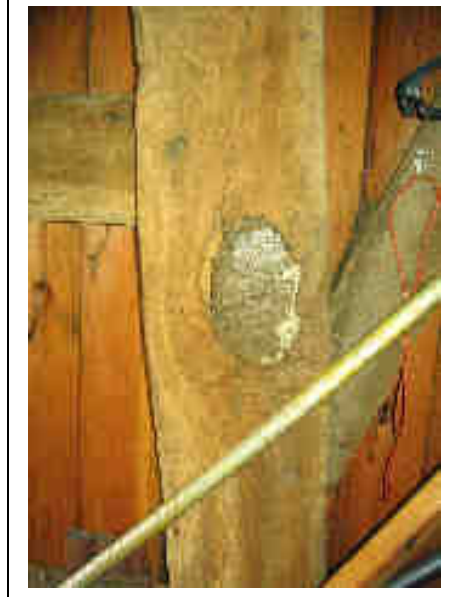
Figuur 109: Deuvelverbinding in de middenlijsten (Bossenaremolen / Etikhove)
