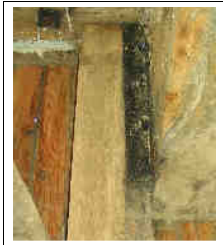
Figuur 121: Eiken spoorstijl met versteviging
