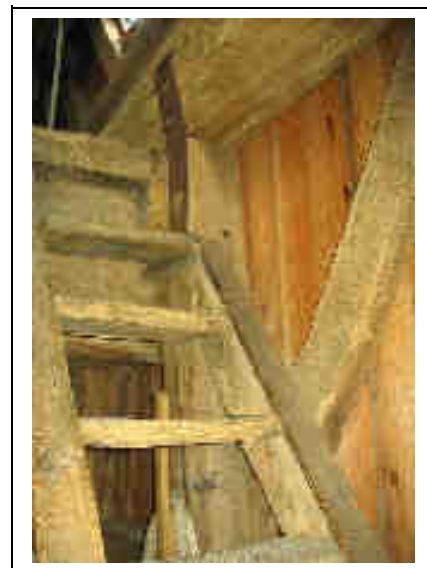
Figuur 132: Versteviging aan de middenlijst en met een bout
