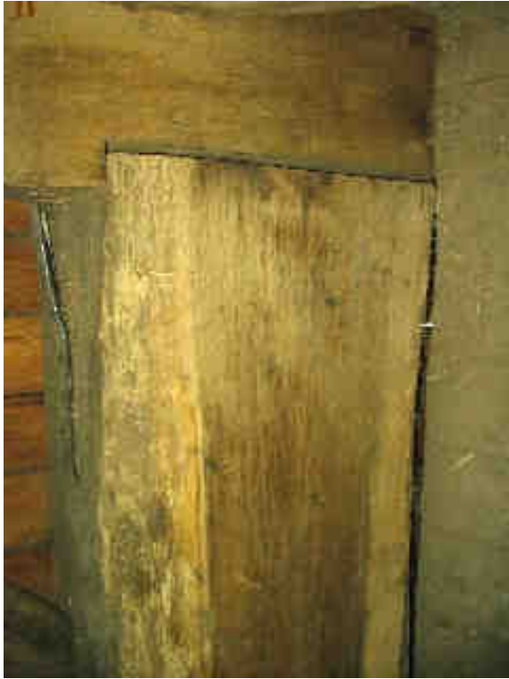
Figuur 79: Middenlijst - open verbinding en schors
