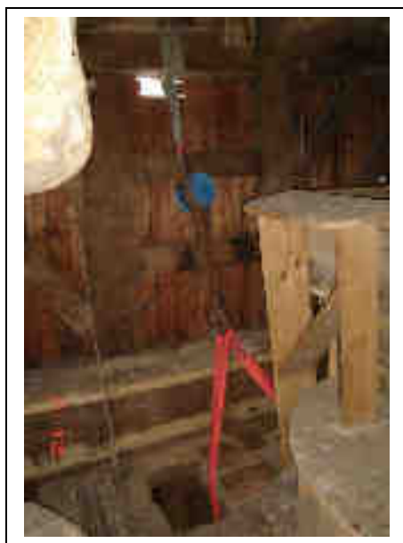
Figuur 115: Ophanging van de steenbalk aan de daklijst
