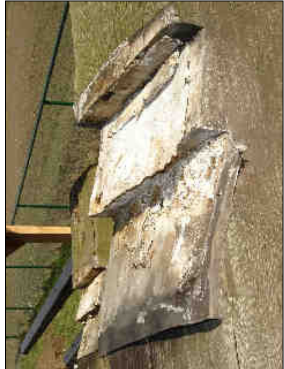
Figuur 65: Lood op de kruisplaten is aangetast
