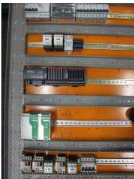
Foto 62: Montagebord met gemonteerde componenten
