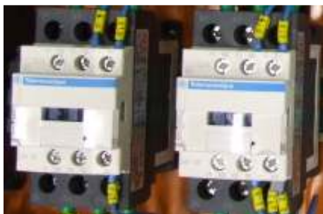
Foto 59: Vermogenrelais gebruikt voor de algemene noodstop
