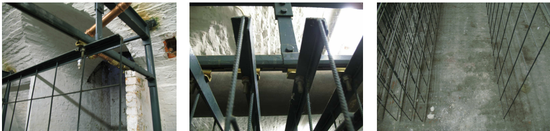
Afb. 23 Details van het ophangstelsel
