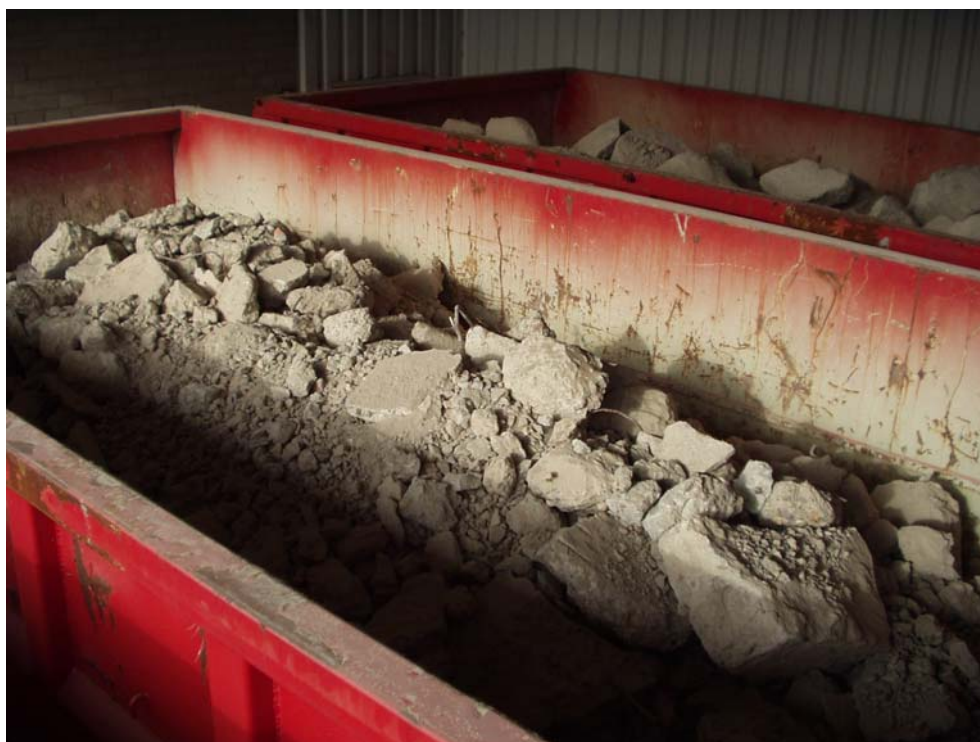
Figuur 4: Container gevuld met betonbrokstukken van de ontmanteling
