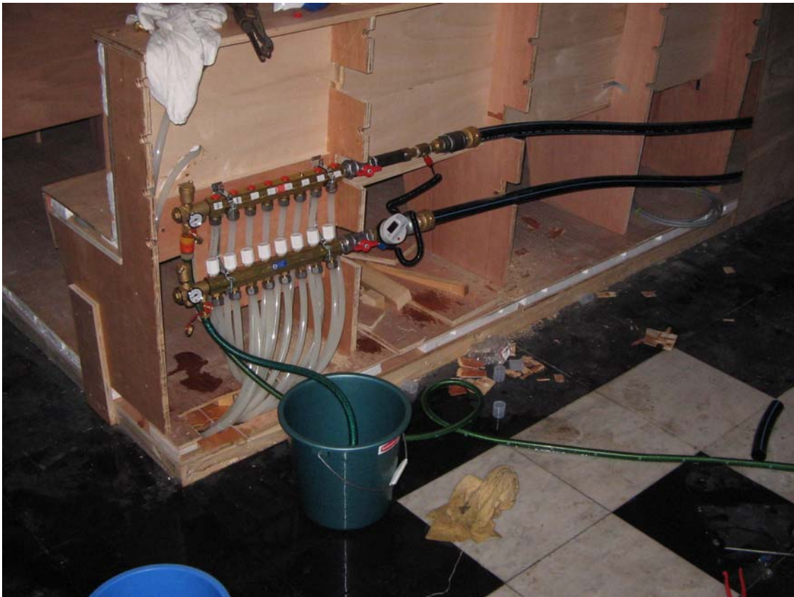
Figuur 3.51: Circuits vullen met water
