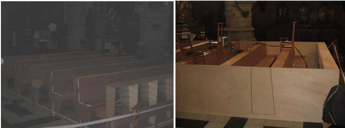
Figuur 3.63: Aanbrengen deuren aan de banken
