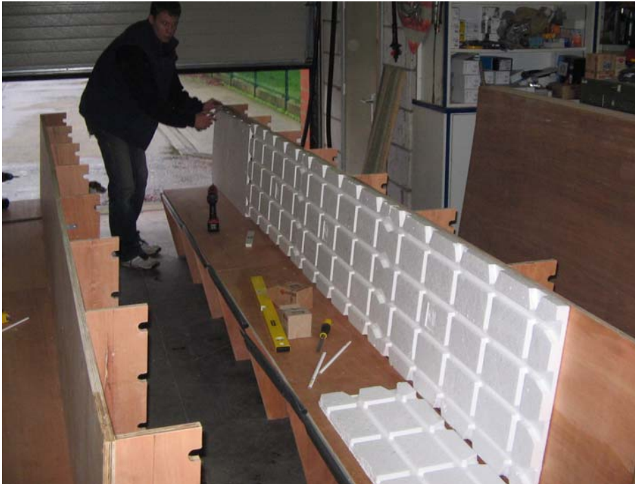
Figuur 3.34: Plaatsen isolatieprofielen
