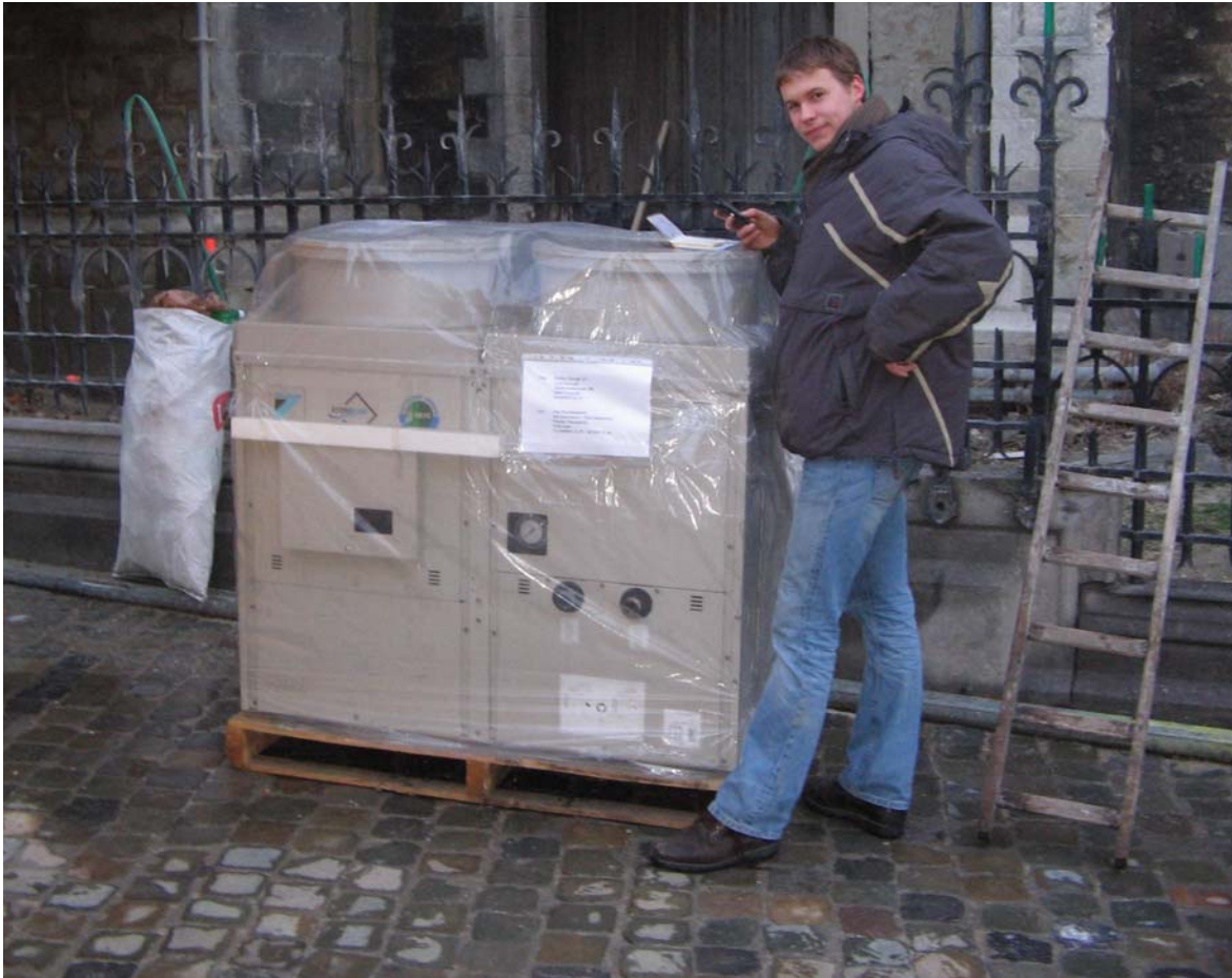
Figuur 3.47: Plaatsing Daikin toestel
