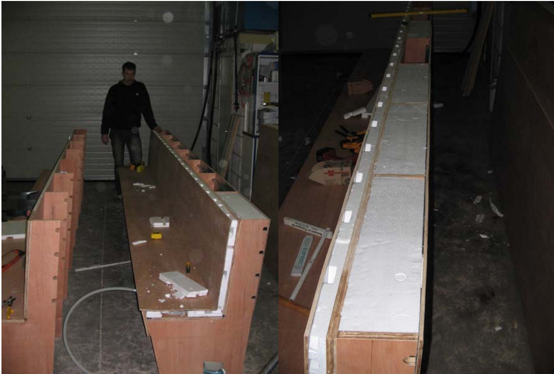
Figuur 3.40: Isolatie bovenkant banken
