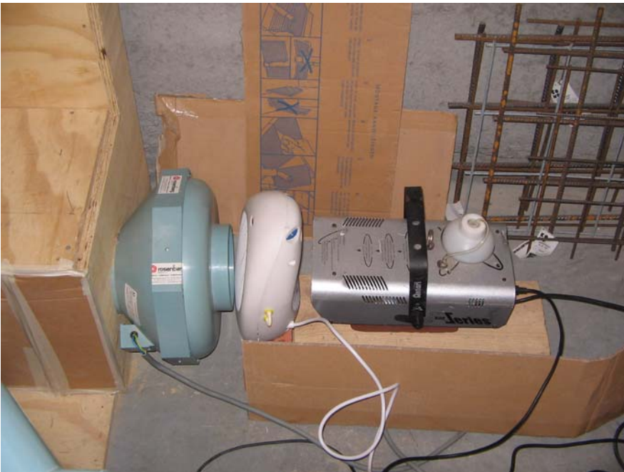
Figuur 2.10: Foto van opstelling, ventilator, verwarmings- en rookmachine
