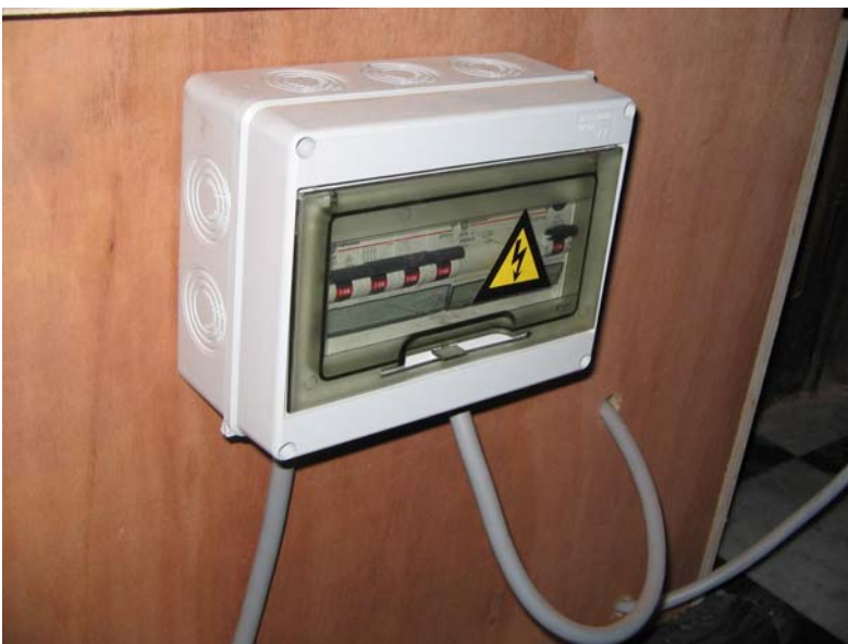
Figuur 3.49: Aansluiten transformator
