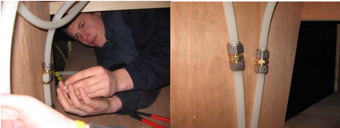
Figuur 3.46: Aansluiten banken op sokkel
