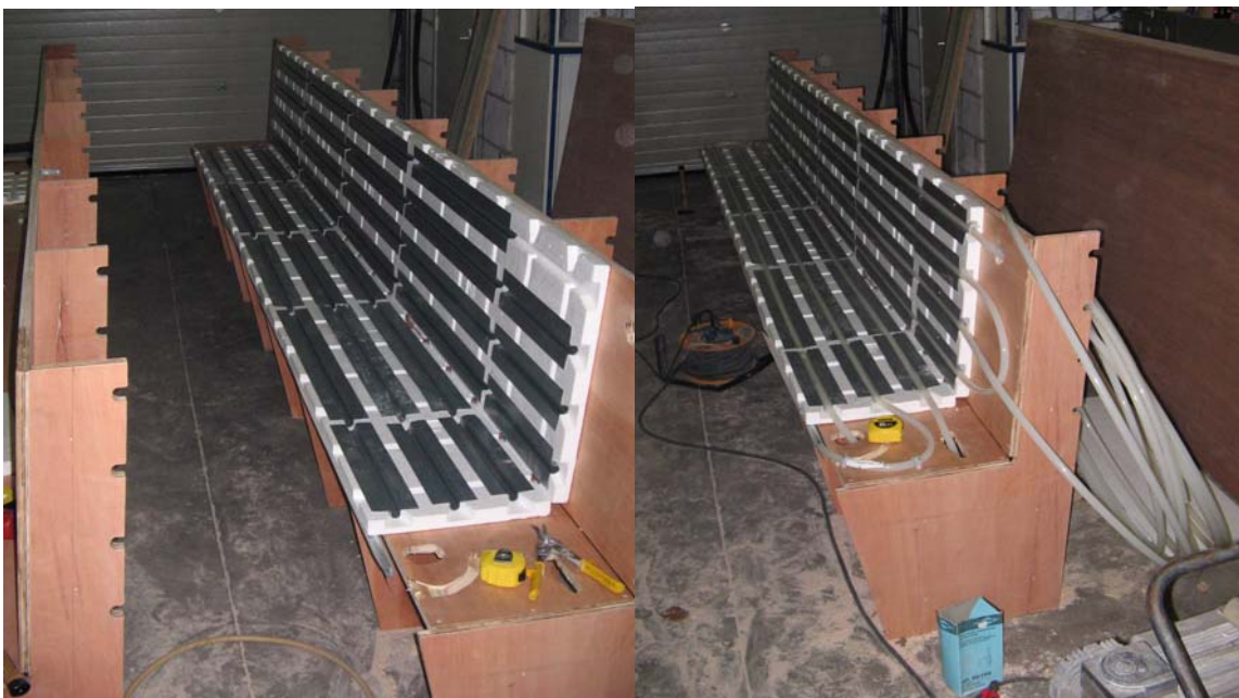
Figuur 3.37: Legschema buizen in bankenstelsel
