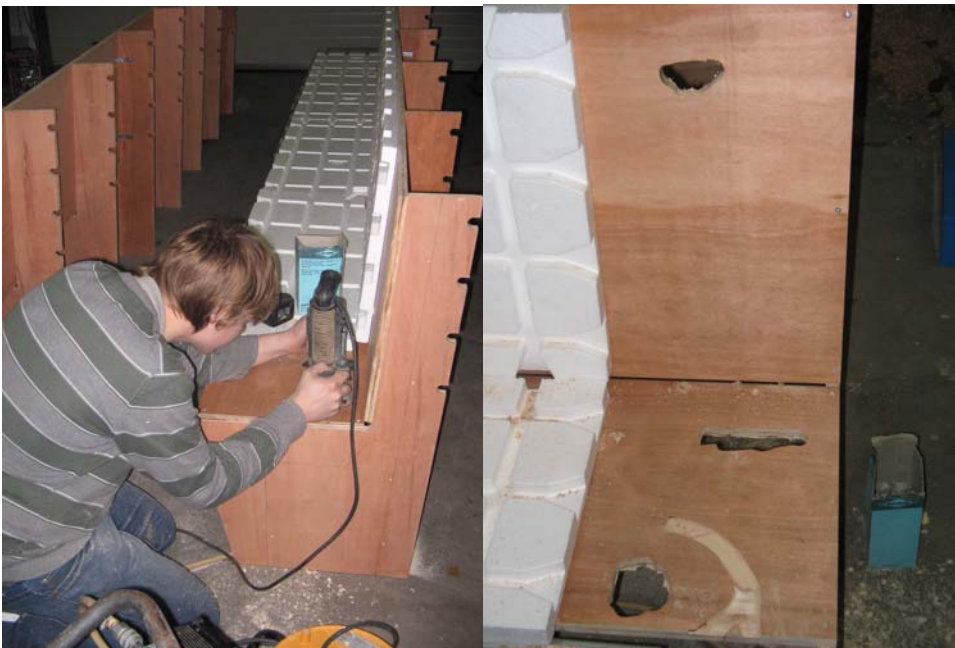
Figuur 3.35: Aanpassingen voor legschema buizen
