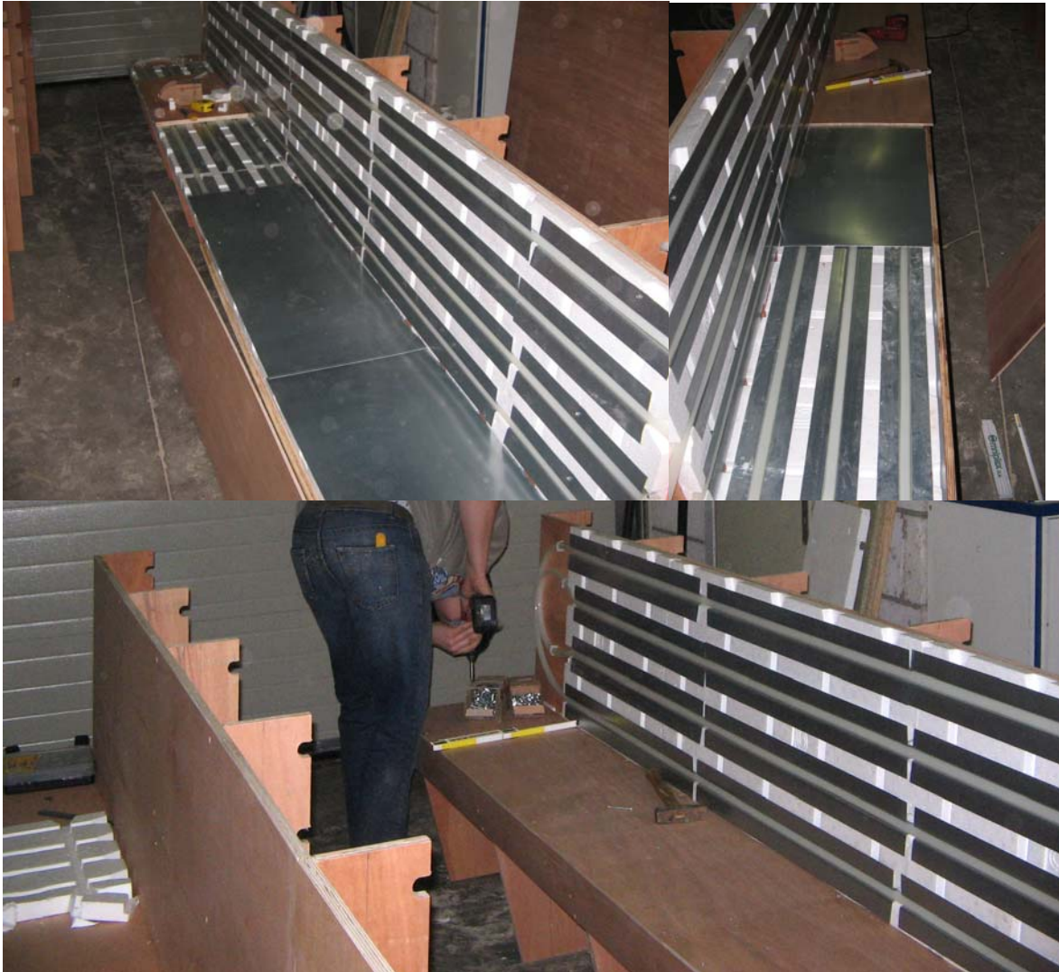
Figuur 3.38: Samenstelling droog vloerverwarmingssysteem
