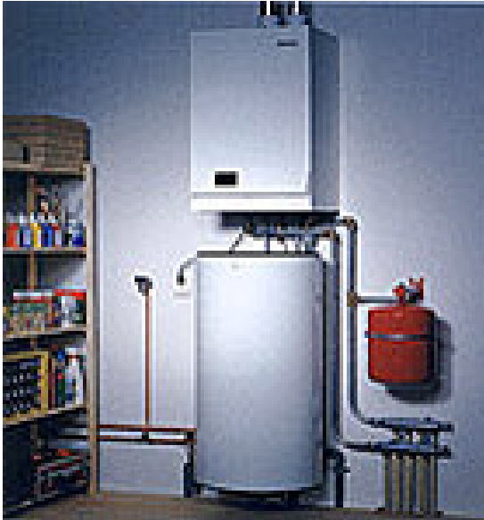
Figuur 3.15: Gascondenseerende boiler
