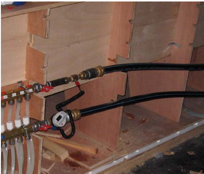
Figuur 3.50: Aansluiten chiller aan collector
