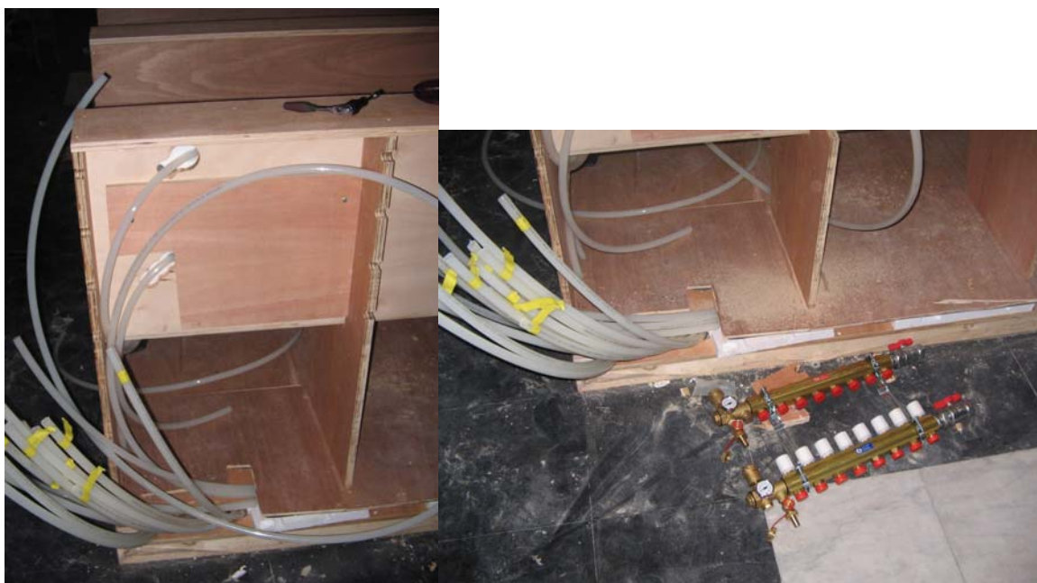
Figuur 3.44: Monteren collector
