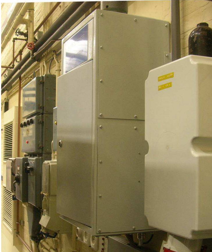
Figuur 6.12 Plaatsing van de elektriciteitskast
