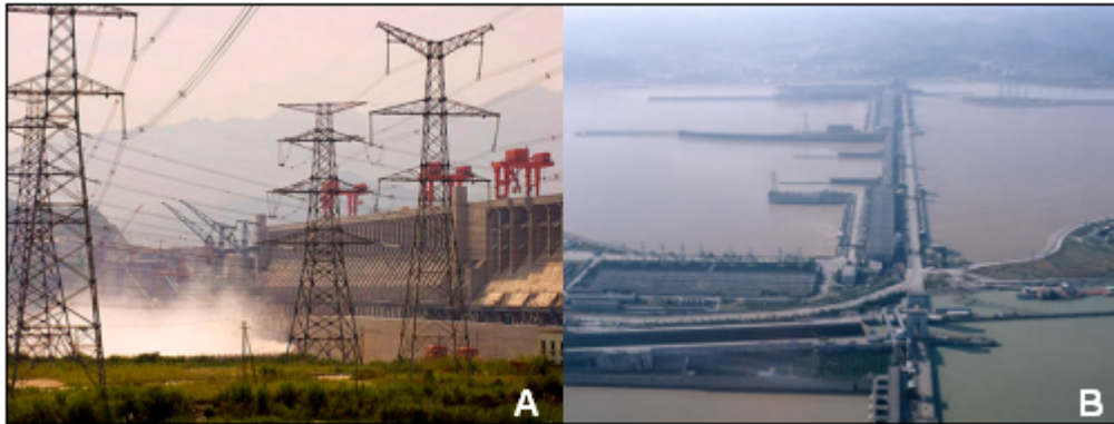
Figuur 52: Drie-Kloven-Dam (China)
