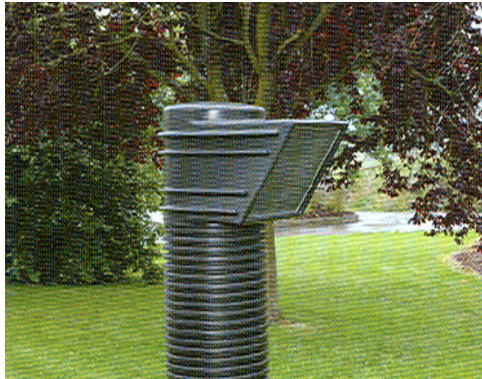
Figuur 2.12: Filter bovenaan een aanzuigkanaal, zijdelings geplaatst om het aanzuigen van neerslag te voorkomen (Fränkische Rohrwerke GmbH, 2007).
