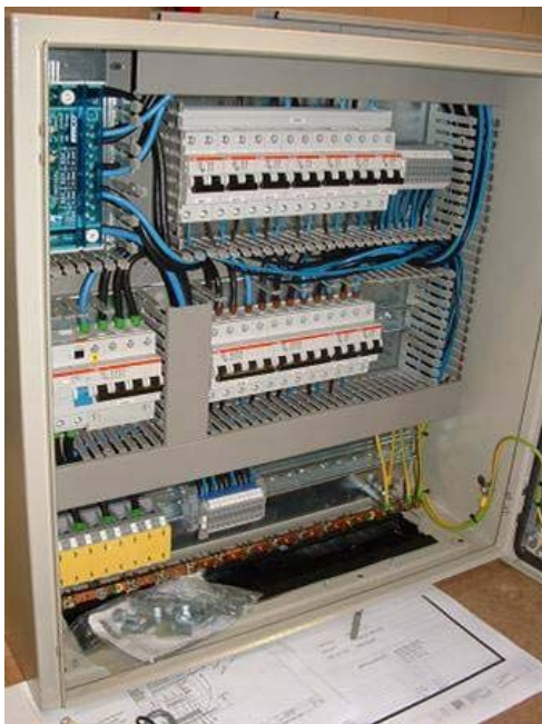
Figuur 1.3: Voorbeeld van schakelbord 1 [P&V]
