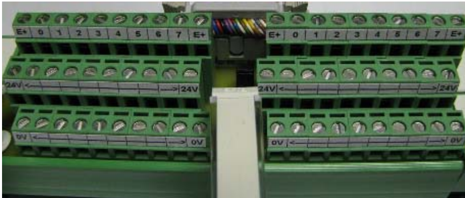
Figuur 5.43: Klemmenstrook voor I/O module
