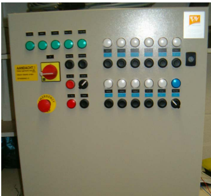
Figuur 6.19: Buitenkant afgewerkte stuurkast
