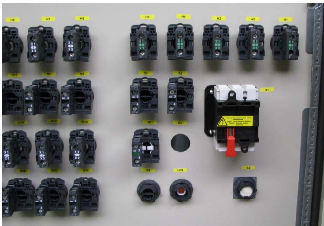
Figuur 6.14: Overzicht achterkant deur
