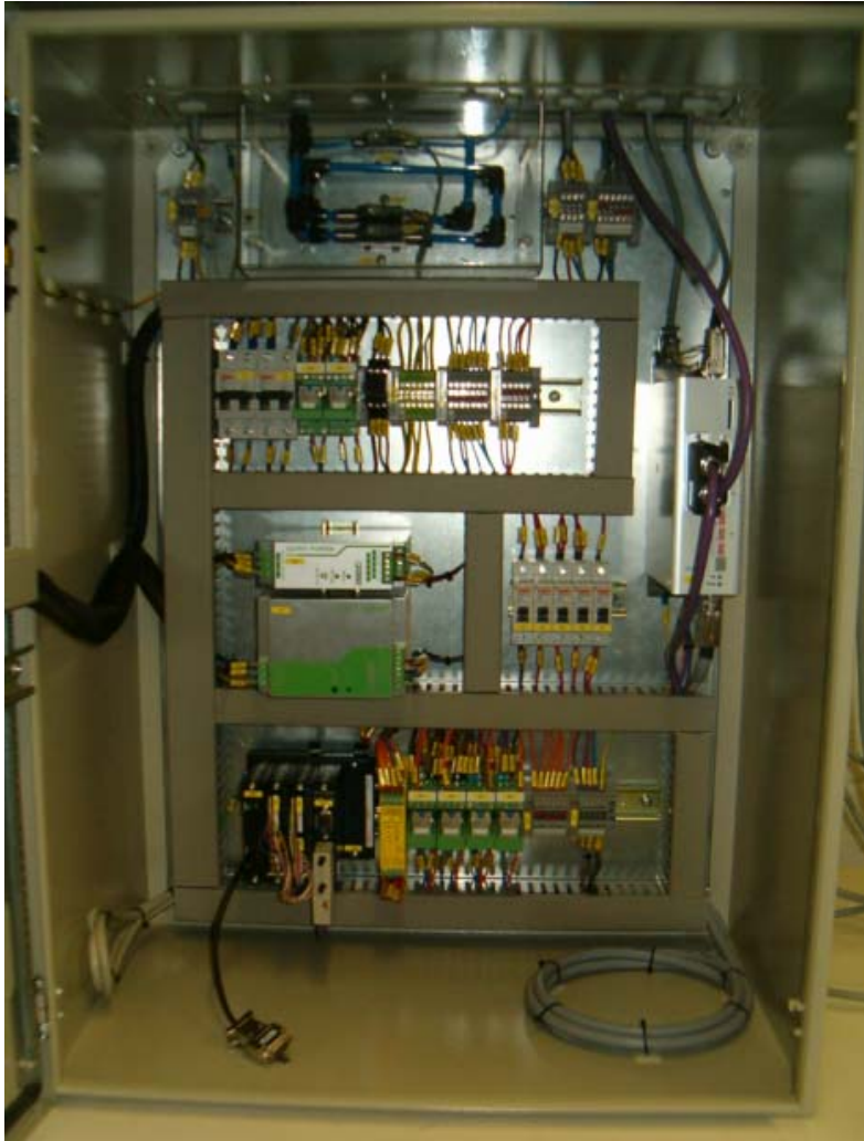
Figuur 6.18: Binnenkant afgewerkte stuurkast
