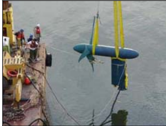
Figuur 5-8 : installatie van de Verdant turbine in de East River, New York [98]
