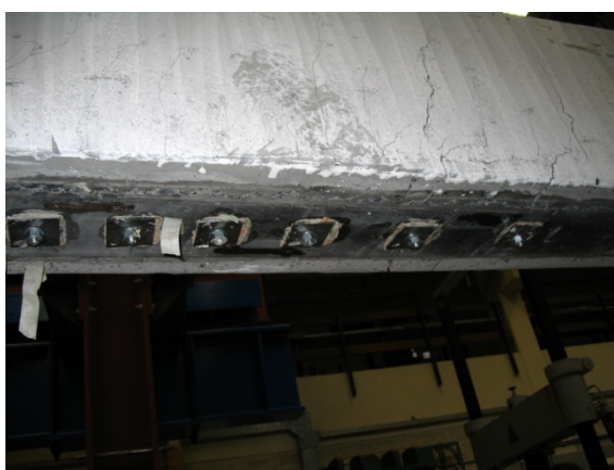
Figuur 122: Geen inscheuringen zichtbaar
