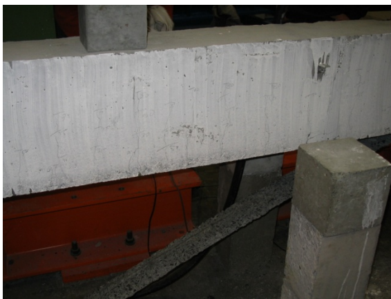
Figuur 94: Scheurvorming linkerkant balk BL2.1
