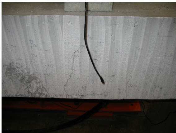
Figuur 118: Scheurvorming linkerkant balk BLA2.3
