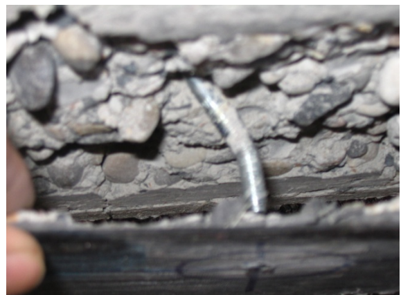
Figuur 65: Geplooid anker
