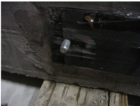
Figuur 104: Inscheuring M12 anker
