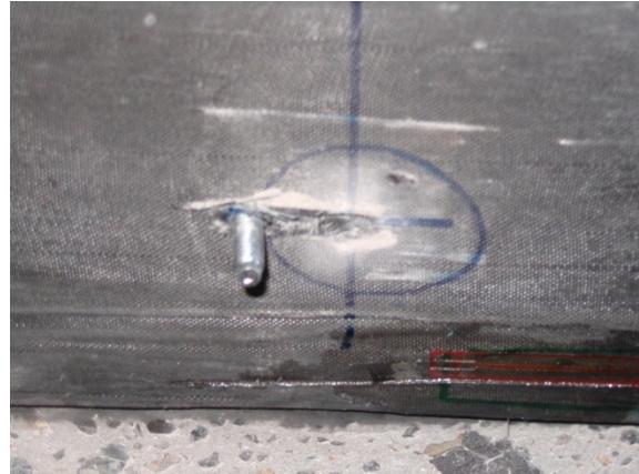
Figuur 55: Ingescheurd anker
