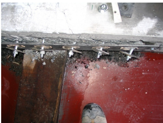
Figuur 210: Uitgetrokken ankers
