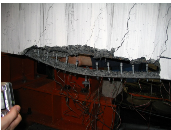
Figuur 167: Verbrokkeling van het beton na herbelasting
