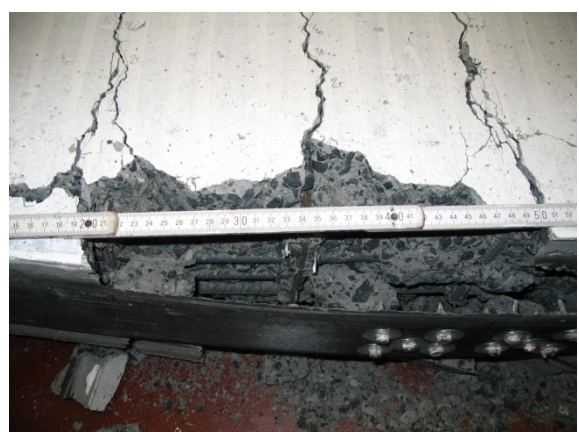
Figuur 192: Onthechting t.h.v. een verzwakte laag [3]
