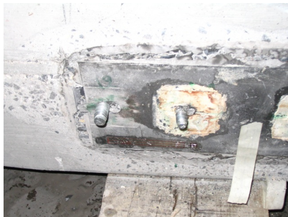
Figuur 158: Inscheuringen van meest linkse ankers
