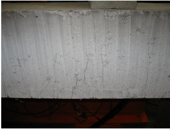
Figuur 154: Scheurvorming linkerkant balk BLA2.7
