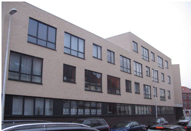
FIG 5.40 ZIJGEVEL AAN DE DRONGENSESTEENWEG
