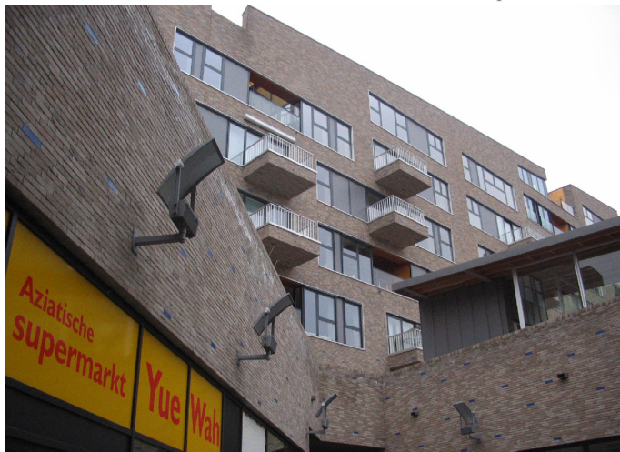
FIG 5.63 NIEUW HELMOND ACHTERGEVEL
