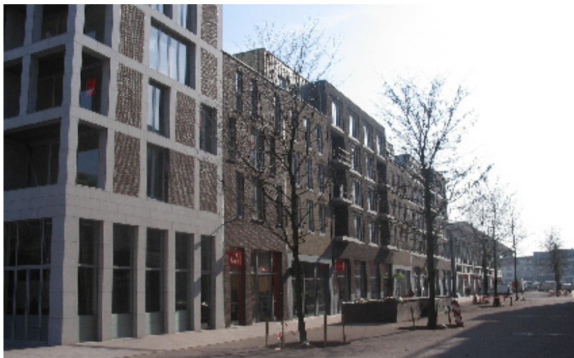
FIG 5,57 BEBOUWING AAN ST. MARTINUSPLEIN
