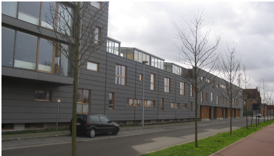
FIG 5.31 GEVEL AAN DE KOLENKAAL
