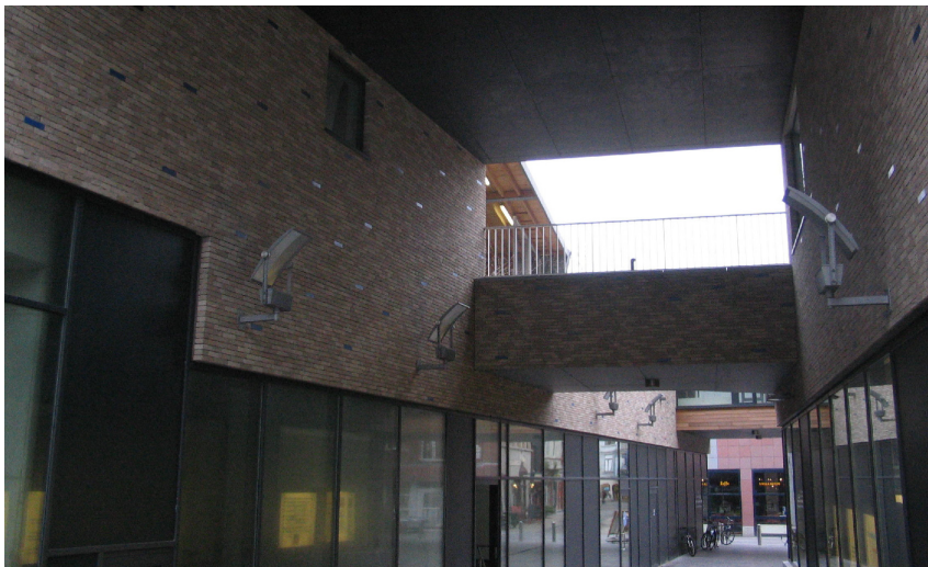
FIG 5.65 NIEUW HELMOND ONDERDOORGANG
