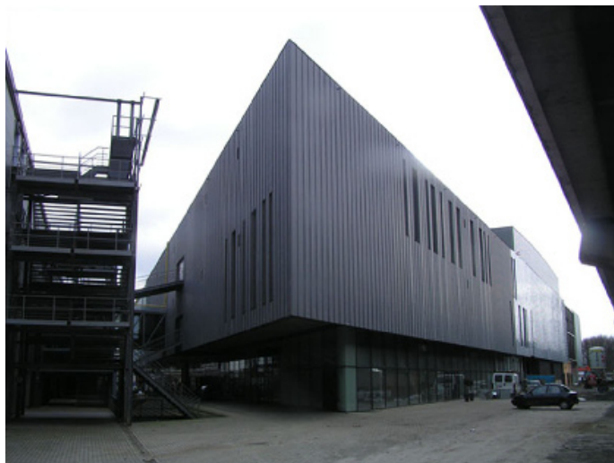
FIG 5.I2 HOEKZICHT MET GEVELOPBOW, WERFFOTO FEBRUARI 2007
