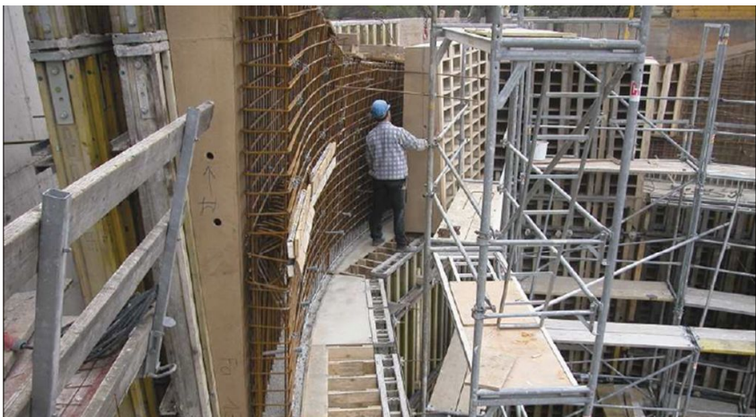
wapening tussen de bekistingspanelen in.
