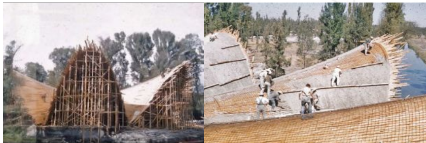
de schalen worden ter plaatse gestort
