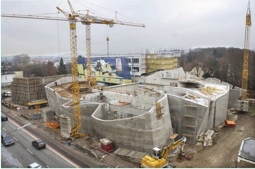
Het storten van de muren gebeurt in verschillende stortfases.
