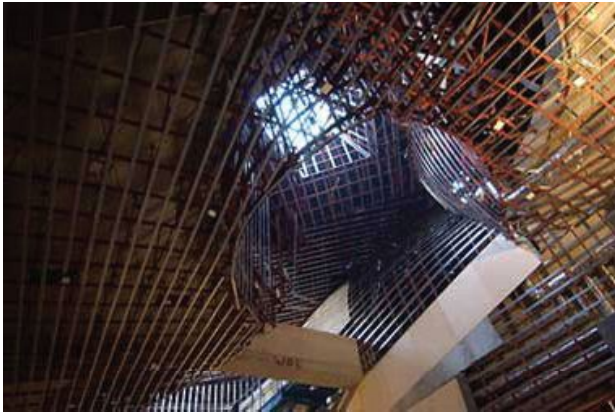
Stalen frame, waarachter leidingen en kabels worden geplaatst, waartegen de gyproc wordt bevestigd.
