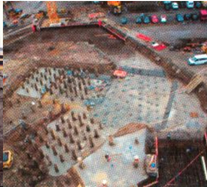
linksboven: positie van de funderingspalen rechtsboven: funderingsplaat
