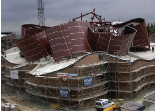
plaatsen van roestvrije stalen platen.
