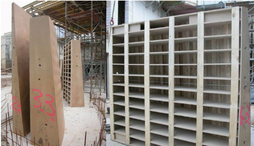
de op maat gesneden bekistingspanelen
